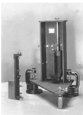
Σχήμα 1.3 Ο βραχείας περιόδου Wood-Anderson σειсмоγράφος στρέψης σε χρήση στο Cape Girardeau Seismological Observatory, μέρος του Saint Louis University group of Stations, υπό τη διεύθυνση του Jesuit Seismological Association. (J. B. Macelwane Archives, Saint Louis University)
