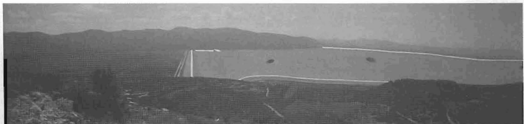
Εικόνα 2 : Η λίμνη μετά την αποκατάσταση
