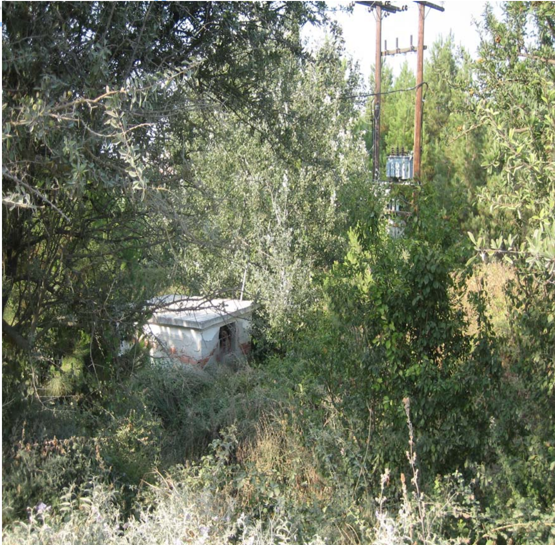
Φωτ. 2: Γεώτρηση Πηγάδι – Πλαγιάρι (η παλαιότερη γεώτρηση)
