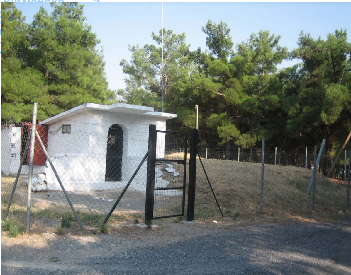
Φωτ. 9: Δεξαμενή Προφήτη Ηλία Κ. Σχολαρίου
