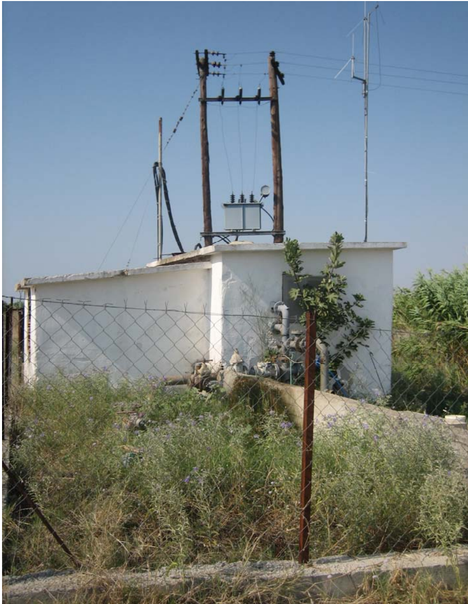
Φωτ 1: Γεώτρηση Α1 – Πλαγιάρι
