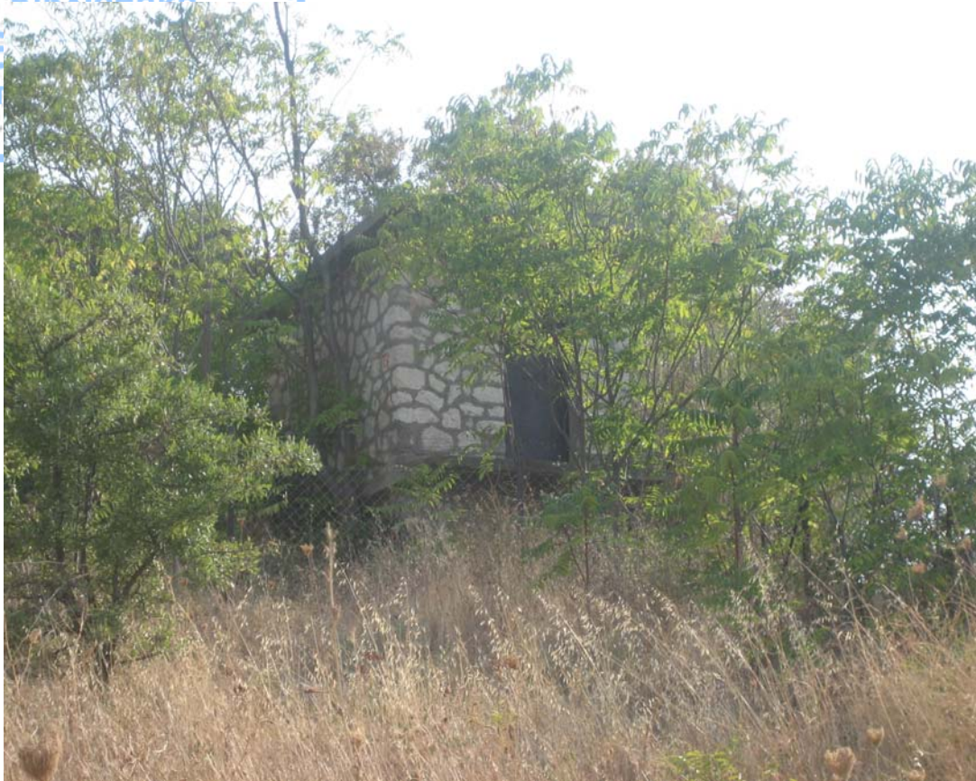
Φωτ. 7: Δεξαμενή Προφήτης Ηλίας Τριλόφου
