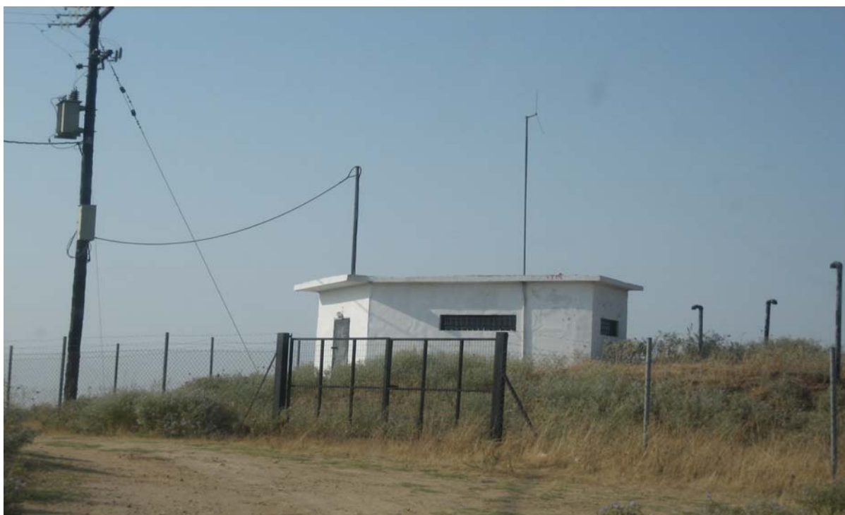
Φωτ. 10: Νέα Μεγάλη Δεξαμενή Άνω & Κάτω Σχολαρίου
