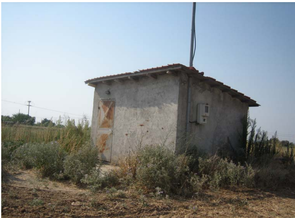
Φωτ. 4: Γεώτρηση Κακαρίνου – Καρδία
