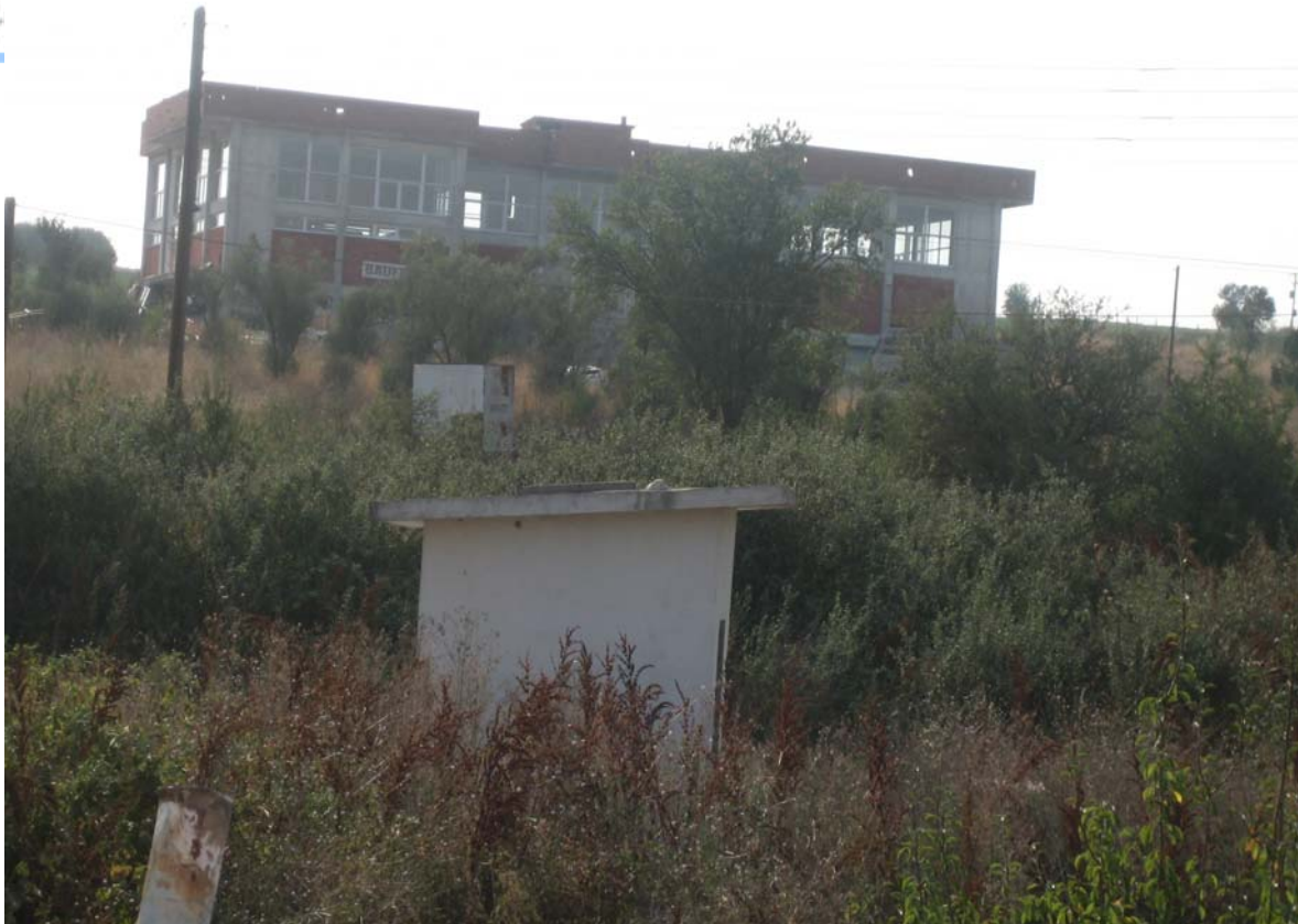
Φωτ. 3: Γεώτρηση Κυφωνίδα – Τρίλοφος
