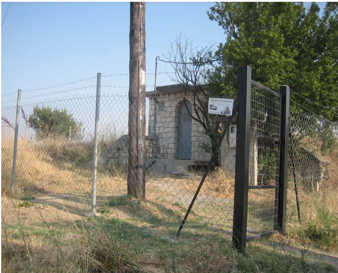
Φωτ. 6: Κεντρική Δεξαμενή Πλαγιαρίου
