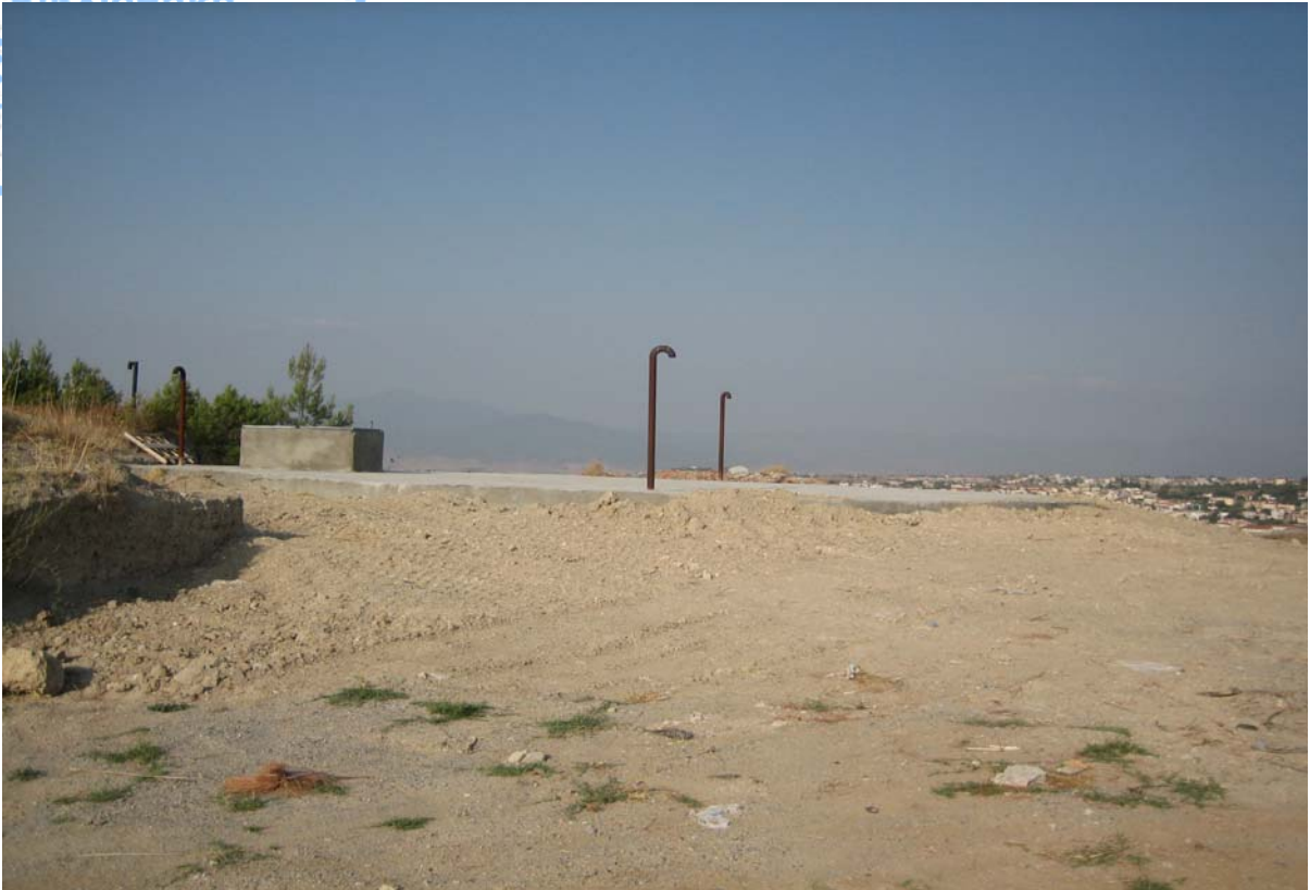
Φωτ. 5: Νέα Μεγάλη Δεξαμενή Πλαγιαρίου (Άνω Δεξαμενή)
