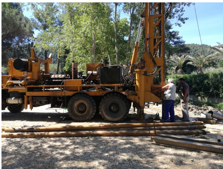
Εικόνα 4.4 Εγκατάσταση γεωτρύπανου πριν την κατασκευή των γεωτρήσεων για την τοποθέτηση του γεωεναλλάκτη
