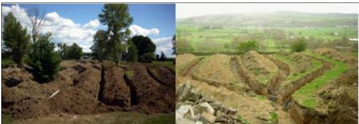
Εικόνα 3.8 Τοποθέτηση σωληνώσεων σε ορύγματα (Μυλωνάς, 2013)
