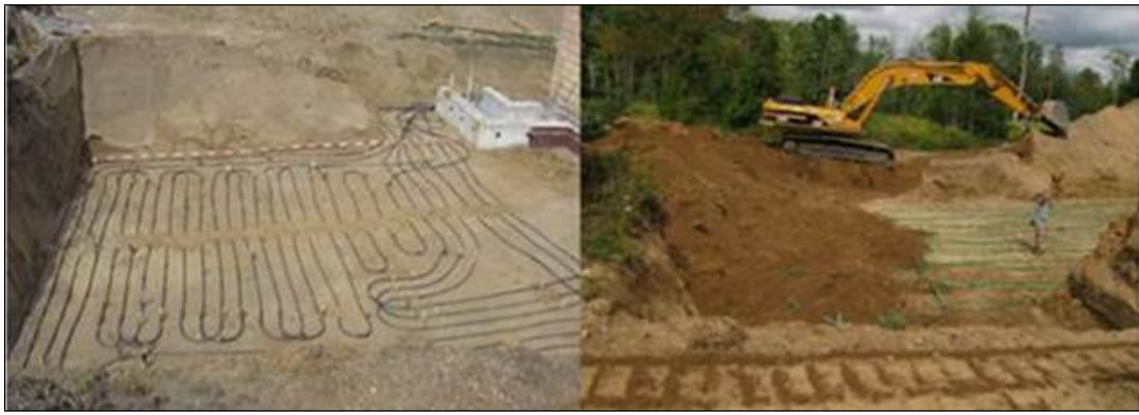
Εικόνα 3.9 Τοποθέτηση σωληνώσεων σε τάφρο με ολική αφαίρεση του εδάφους (Μυλωνάς, 2013)
