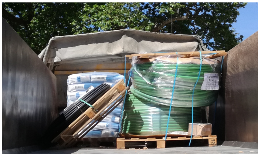
Εικόνα 4.7 Τα είδη των σωληνώσεων (αγωγών) που χρησιμοποιήθηκαν
