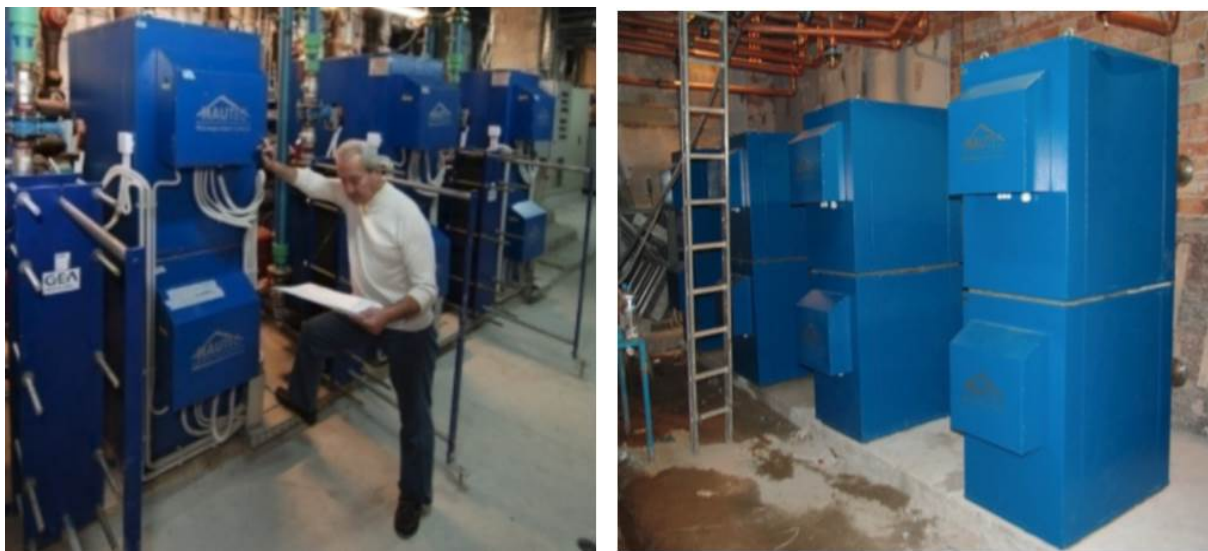
Εικόνα 3.22 και 3.23 Το μηχανοστάσιο και οι αντλίες θερμότητας του ξενοδοχείου (Μαρούδης, 2014)
