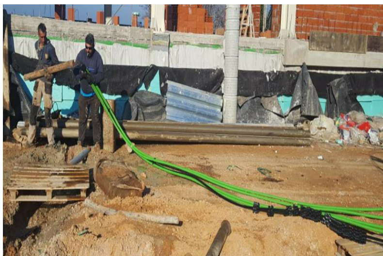
Εικόνα 4.8 Τοποθέτηση βαριδίων στις σωληνώσεις του εναλλάκτη
