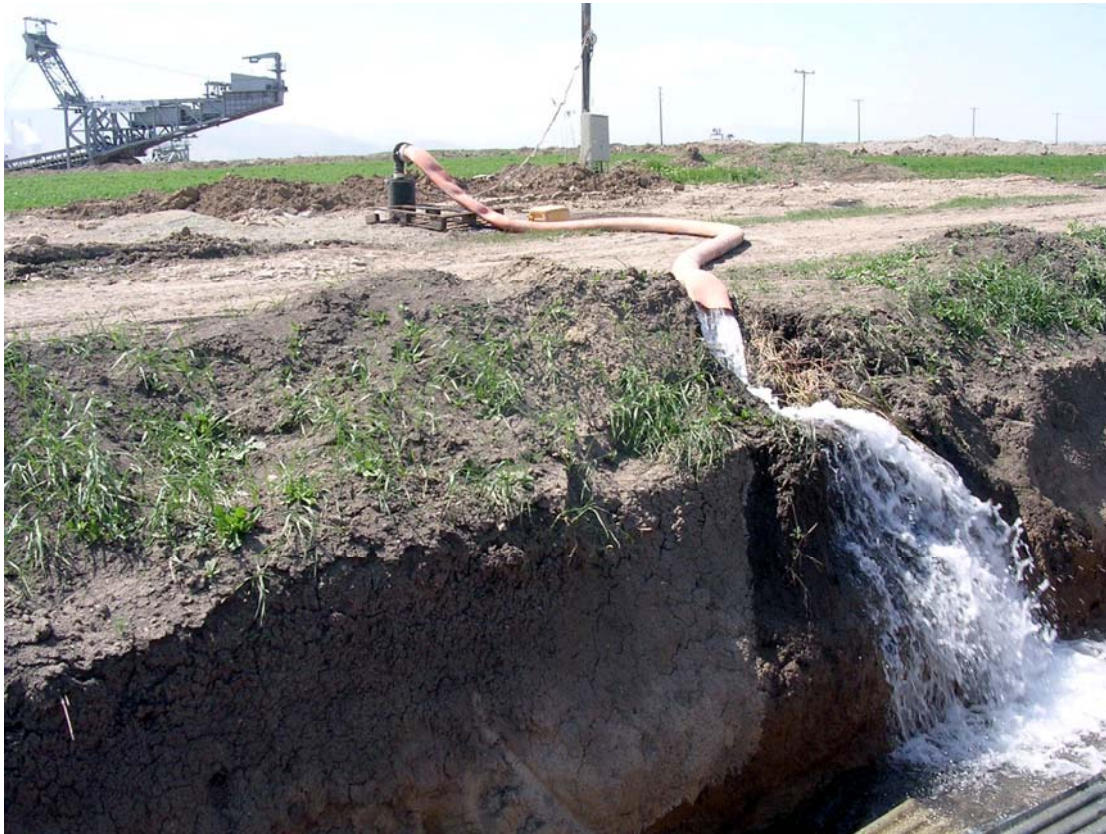
Φωτο Π.5: Υδρογεώτρηση που χρησιμοποιείται από τη Δ.Ε.Η. για την αποστράγγιση των ανοιχτών εκσκαφών των ορυχείων. Τα αντλούμενα νερά οδηγούνται μέσω εκσκαπτόμενων τάφρων, όπως αυτή της φωτογραφίας, στο ρέμα Σουλού, με τελικό αποδέκτη τη λίμνη Βεγορίτιδα.
