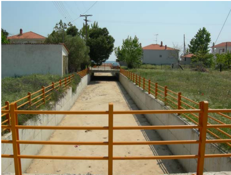
Φωτ. 12 Το κανάλι των αποστραγγιστικών έργων της Εγνατίας Οδού που περνά μέσα από τον οικισμό των Νέων Βρασνών και καταλήγει στη θάλασσα.
