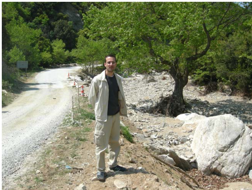
Φωτ. 1 Ένα ρέμα στα ανάντη. Το μέγεθος του ογκόλιθου στα δεξιά είναι ενδεικτικό των πολύ χονδρόκοκκων υλικών που μετακινήθηκαν. Ο δρόμος που φαίνεται σε πρώτο πλάνο υπέστη ζημιές και έχει επισκευαστεί προχειρά.
