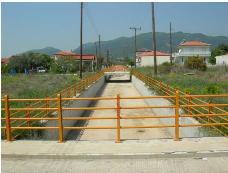
Φωτ. 13 Το κανάλι λειτούργησε εντάξει και δεν φαίνεται να επιβάρυνε την κατάσταση.
