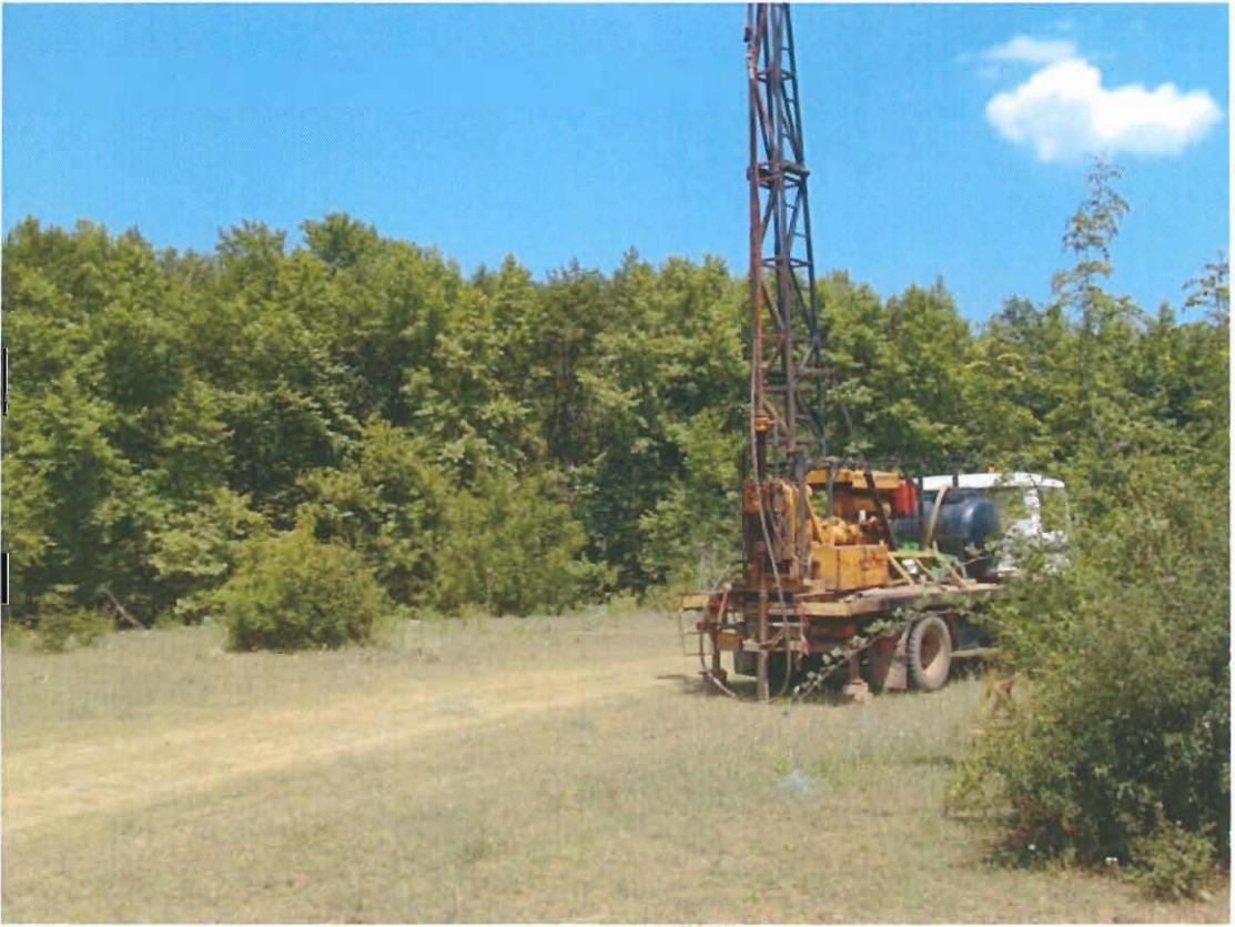
Φωτογραφία 5. Γεωτρητικές εργασίες
