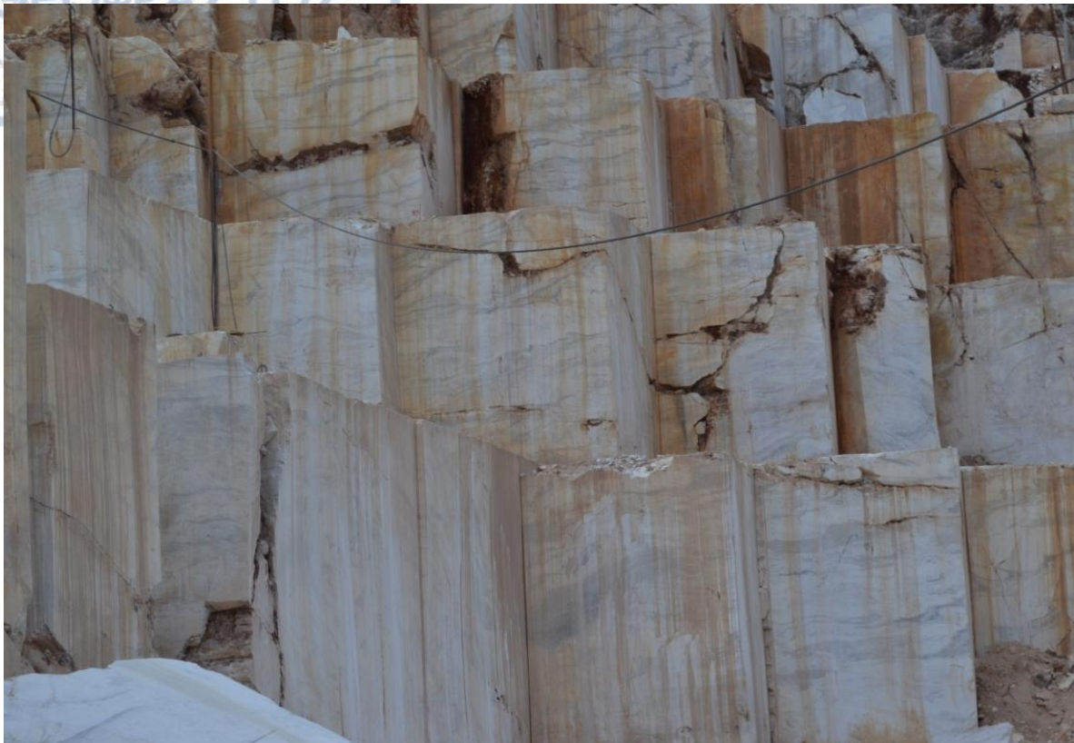
Εικόνα 16. Μερική άποψη λατομείου στην περιοχή Οχυρού Δράμας.
