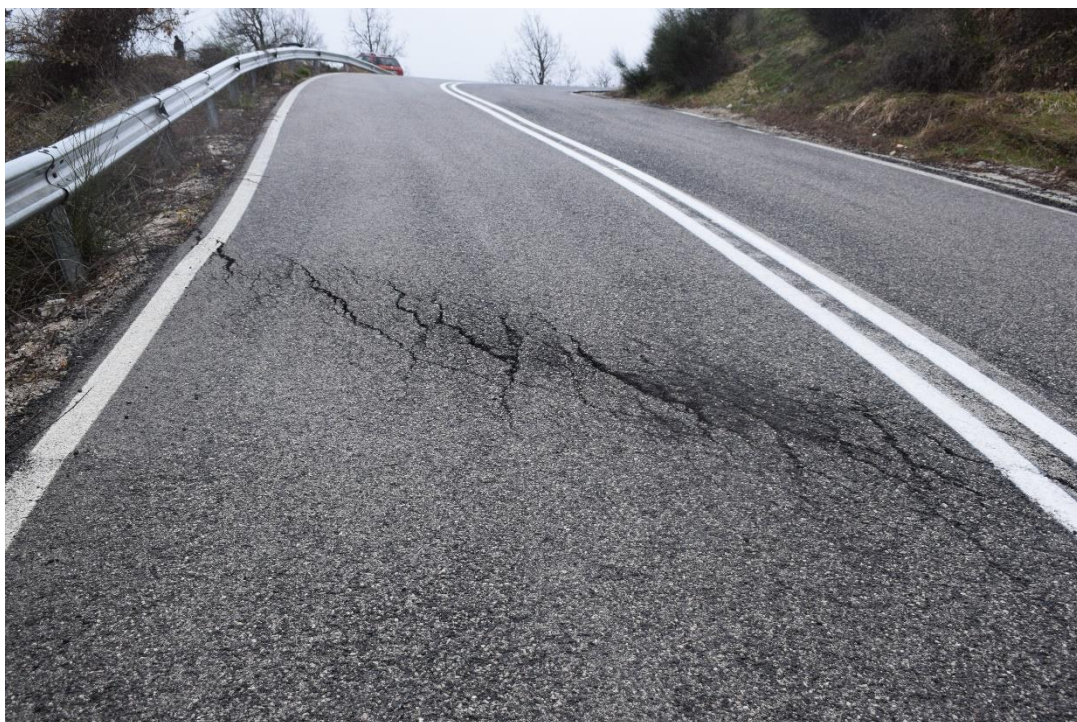
Εικόνα 6: Ρωγμές οδοστρώματος και το δεξί όριο της κατολίσθησης (από πάνω), φωτογραφία τραβηγμένη από τη συγγραφέα στις 25-3-2018.
