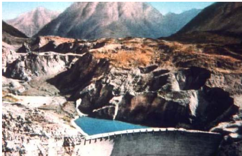
Φωτο 3.4: Άποψη του ταμιευτήρα του φράγματος Vajont, μετά την καταστροφική ολίσθηση στο αριστερό αντέρεισμα. Η ολισθαίνουσα μάζα των μεσοζωικών ασβεστολίθων εντός του ταμιευτήρα προκάλεσε κύμα ύψους 100m που υπερχειλισε επάνω από το σώμα του φράγματος και κατέκλυσε την κοιλάδα Pieve to 1963, καταστρέφοντας την πόλη Longarone, προκαλώντας το θάνατο περισσότερων από 2000 ανθρώπων (Hoek, 2000).
