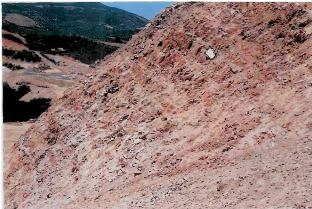
Φωτ. 6: Λεπτομέρεια της προηγούμενης φωτογραφίας. Χαλαζίτες βραχώδεις με αντίρροπη στρώση-σχιστότητα. Εκσκαφή σταθερή.
