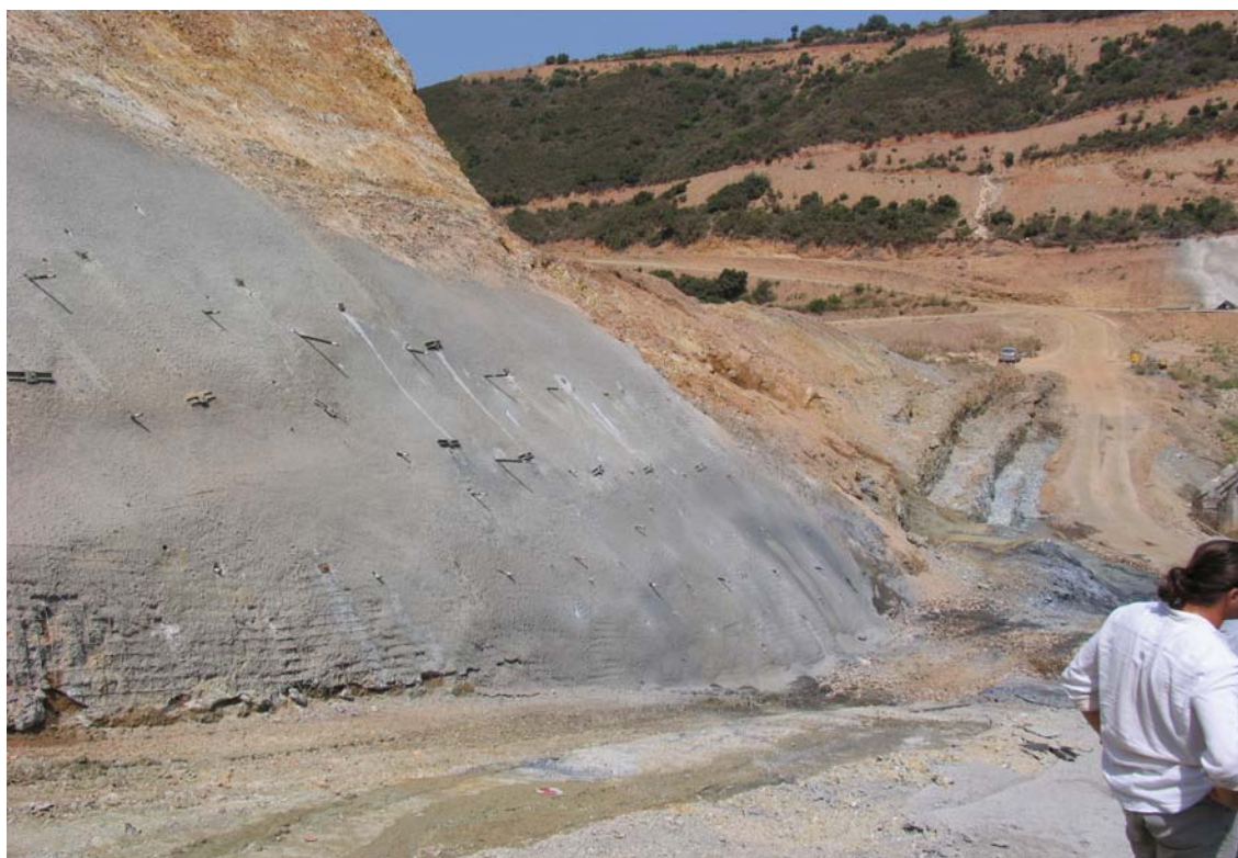
Φωτ. 13-14: Μέτρα αντιστήριξης για την αποφυγή κατολισθήσεων στο δεξιό αντέρεισμα.
