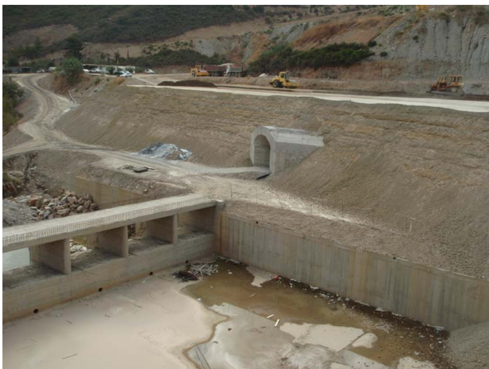
Φωτ. 19: Φωτογραφία στην βάση του φράγματος (Λήψη φωτογραφίας 26/08/2008).
