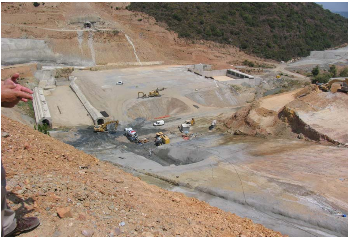
Φωτ. 16: Γενική άποψη του φράγματος (Λήψη φωτογραφίας 26/08/2008).
