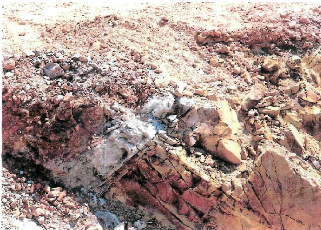
Φωτ. 7: Παρεμβολή σχιστολιθικής στρώσης εντός των χαλαζιτών με αντίρροπη στρώση-σχιστότητα στη στέψη του φράγματος, στο αριστερό αντέρεισμα (Λήψη φωτογραφίας στις 16-05-2006).
