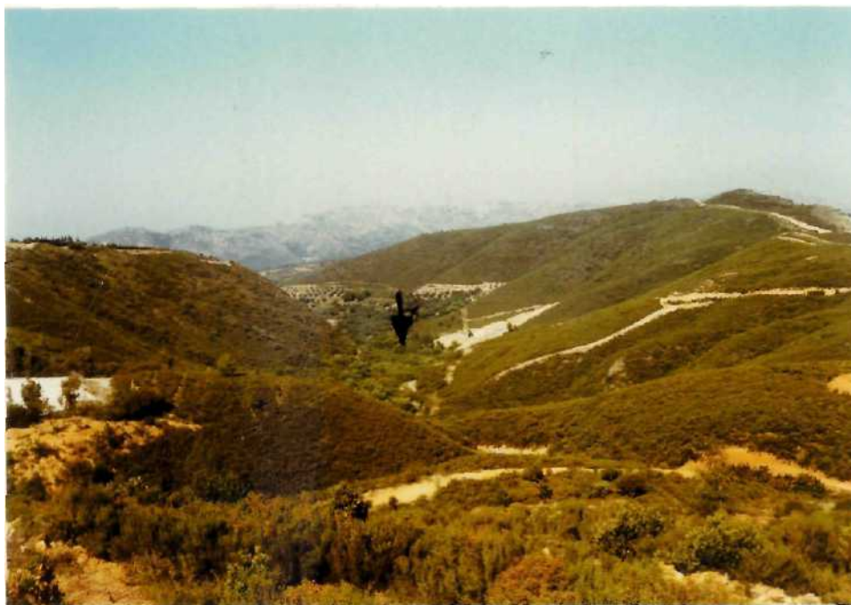
Φωτ. 1: Γενική άποψη της λεκάνης κατάκλυσης του Βαλσαμιώτη, όπως φωτογραφήθηκε από δυτική ως προς αυτή θέση. Με το σύμβολο σημειώνεται η θέση του φράγματος. ↓
