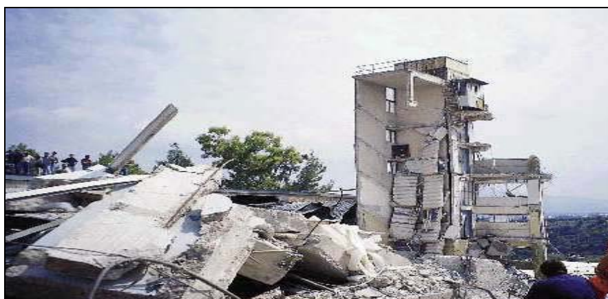
Καταστροφές κτιρίων από το σεισμό.
