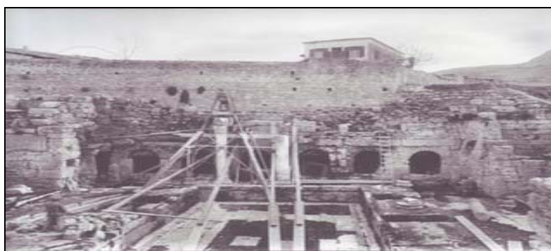
Καταστροφές από το σεισμό.
