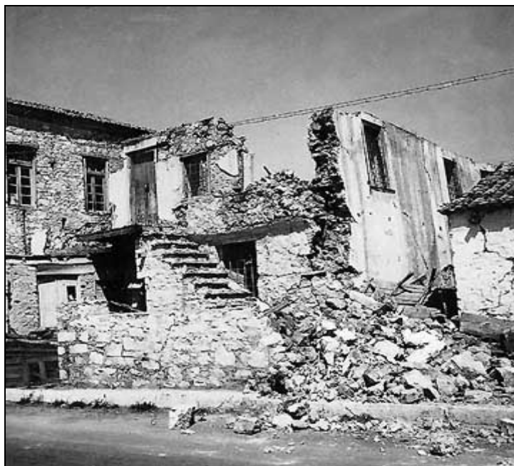
Στη Ρόδο 16 σπίτια σωριάστηκαν, μετά τον καταστροφικό σεισμό.
