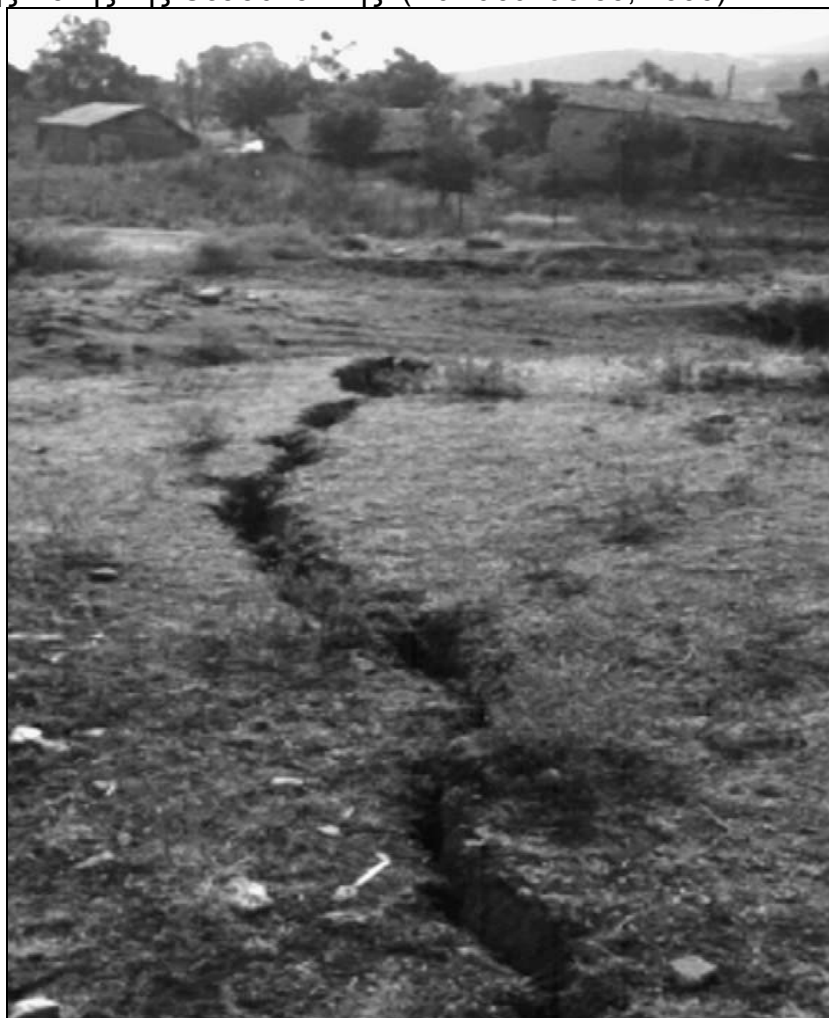
Εδαφική διάρρηξη που παρουσιάζει περίπου 10 εκατ. της κάθετης μετατόπισης και περίπου 10 εκατ. της ανύψωσης που εμφανίστηκαν συνεπεία του σεισμού (1978) πλησίον του χωριού Στίβος. (Pavlidis & Caputo, 2004).
