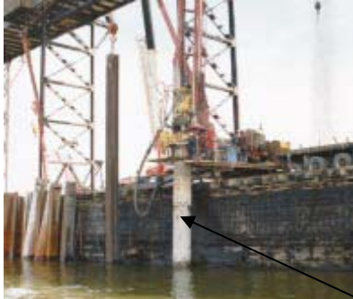
(διοχέτευση σκυροδέματος σε πέδιλο γέφυρας)
