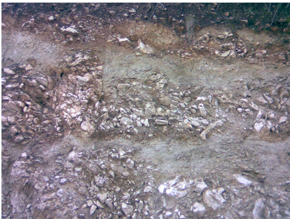
Εικόνα 3.14: Κατώτερος ορίζοντας Ηωκαινικού φλύσχη, νότια της Καρυάς, με τη τεκτονική επαφή του με τον Ασβεστόλιθο του «Παντοκράτορα».
