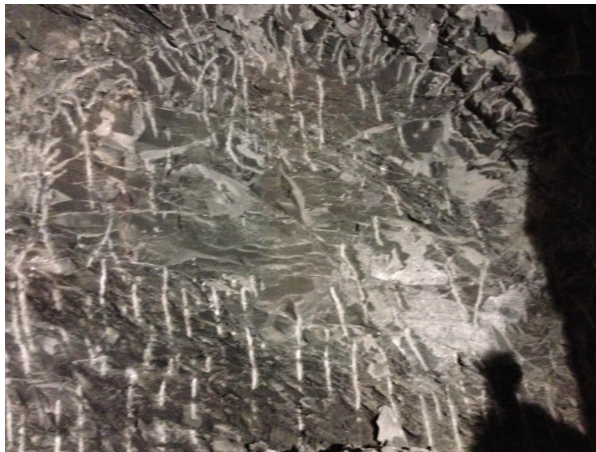
Φωτογραφία 7.2. Μέτωπο κατά την προχώρηση της σήραγγας φυγής στη Χ.Θ. 4+812
