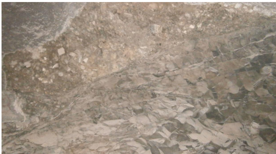
Φωτογραφία 4.6. Επαφή σκληρού μαζικού κροκαλοπαγούς με λεπτο-μεσοστρωματώδη ψαμμίτη, ο οποίος διατέμνεται από πυκνό σύστημα διακλάσεων
