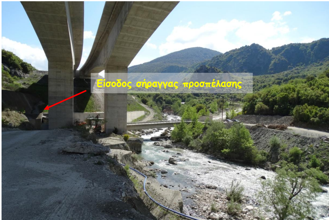
Φωτογραφία 3.1. Γενική άποψη περιοχής ενδιαφέροντος, όπου διακρίνεται η γέφυρα της Εγνατίας Οδού και ο Μετσοβίτικος ποταμός
