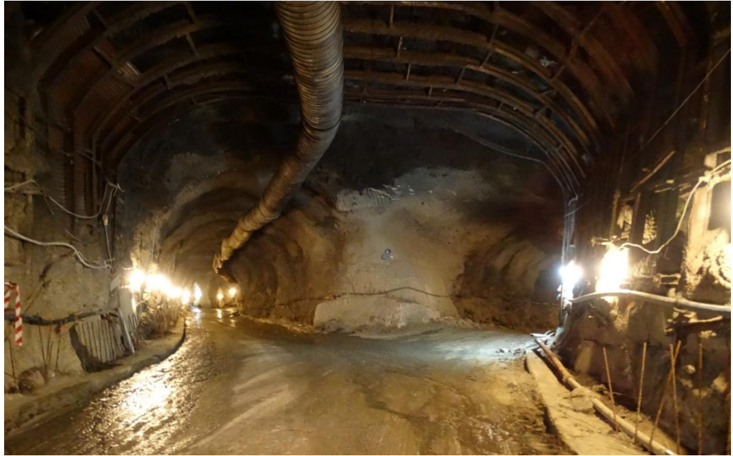
Φωτογραφία 2.4. Διακλάδωση εντός της σήραγγας προσπέλασης. Δεξιά προς σταθμό παραγωγής. Αριστερά προς κατάντη θάλαμο ανάπαλσης
