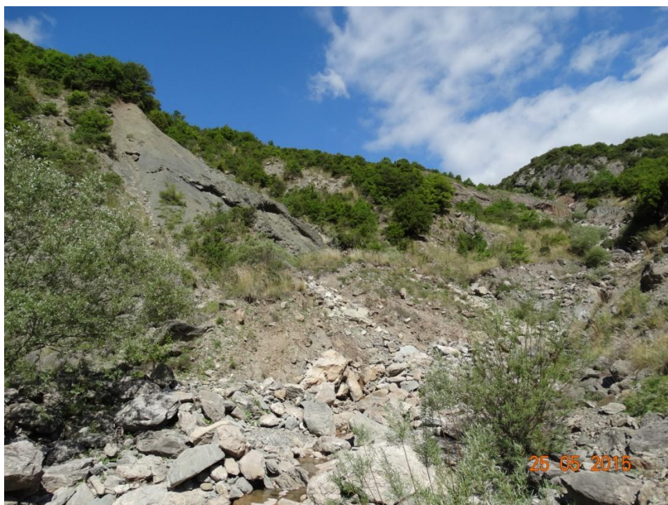
Φωτογραφία 7.7. Η ίδια κατολίσθηση με τη φωτογραφία 7.6. στην περιοχή του φρέατος ανάπαλσης
