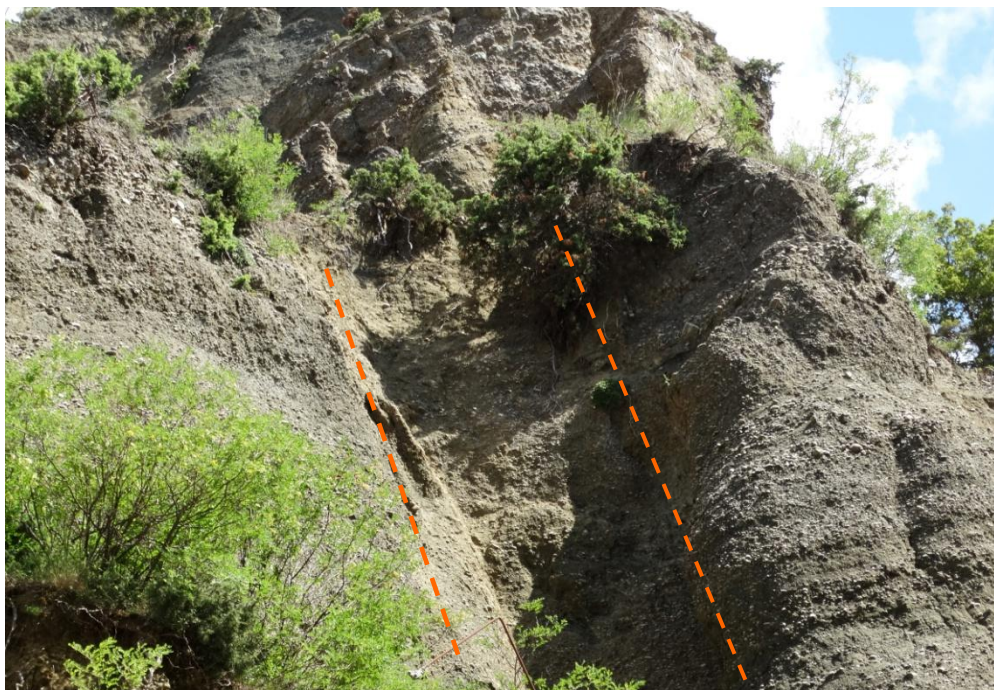
Φωτογραφία 6.2. Δημιουργία πλατιάς διαβρωμένης ζώνης (από την ενοποίηση δύο κατακόρυφων διακλάσεων), εξαιτίας της κυκλοφορίας του νερού μέσω των διακλάσεων αυτών
