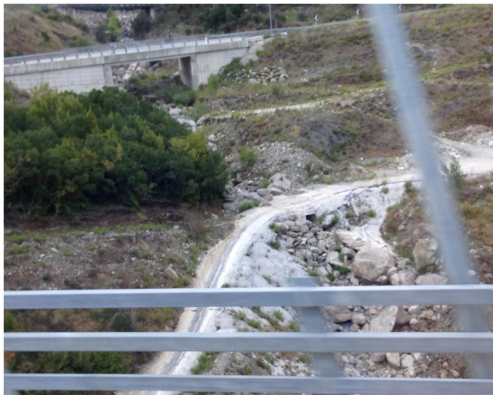
Φωτογραφία 7.6. Η κατολίσθηση του 1987 στην περιοχή του συγκροτήματος υπόγειων έργων (λήψη από γέφυρα Μεγάλου Περιστερίου της Εγνατίας Οδού)
