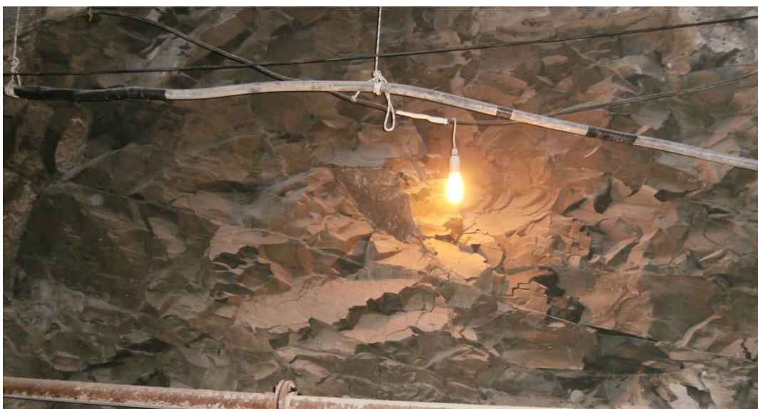
Φωτογραφία 4.5. Μεσοστρωματώδης ψαμμίτης. Πυκνό δίκτυο ασυνεχειών (διακλάσεων). Διακρίνεται ασυνέχεια πληρωμένη με ασβεστιτικό υλικό
