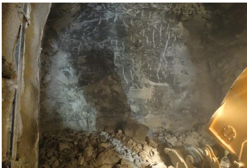
Φωτογραφία 7.4. Μέτωπο κατά την προχώρηση της σήραγγας φυγής στη Χ.Θ. 4+869
