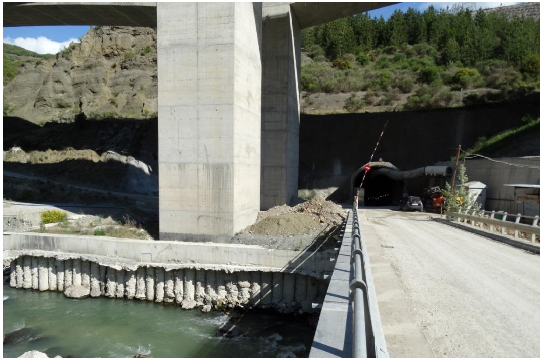
Φωτογραφία 2.5. Είσοδος στη σήραγγα προσπέλασης. Διακρίνονται ακόμη τα βάθρα της γέφυρας Μεγάλου Περιστερίου (Εγνατία Οδός) και ο Μετσοβίτικος ποταμός.
