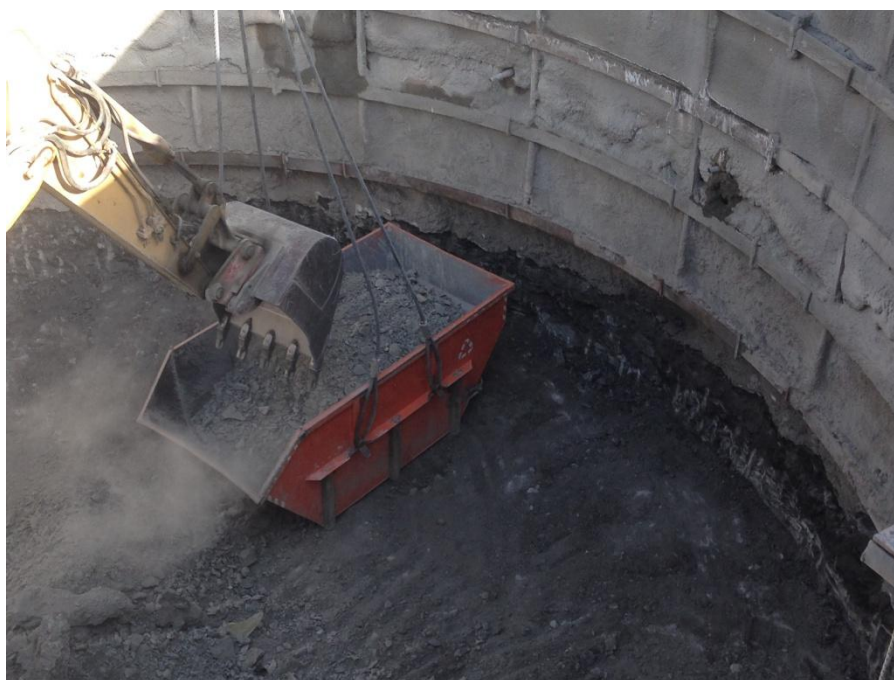
Φωτογραφία 7.9. Εκσκαφή – αποκομιδή προϊόντων εκσκαφής φρέατος ανάπαλσης
