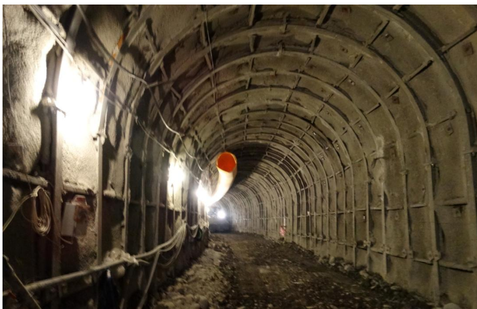
Φωτογραφία 2.8. Σήραγγα φυγής
