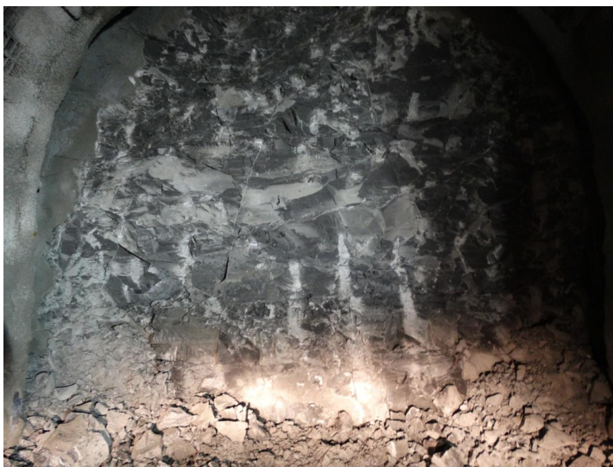
Φωτογραφία 7.3. Μέτωπο κατά την προχώρηση της σήραγγας φυγής στη Χ.Θ. 4+837
