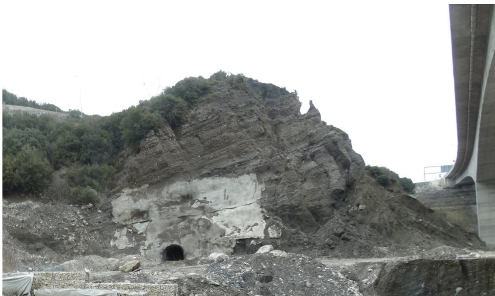
Φωτογραφία 2.7. Έξοδος σήραγγας καλωδίων – διαφυγής. Πάνω από τη σήραγγα διακρίνεται ο σχηματισμός του κροκαλοπαγούς με τη χαρακτηριστική στρωσιγένεια. Δεξιά, η γέφυρα του Μεγάλου Περιστερίου (Εγνατία Οδός)
