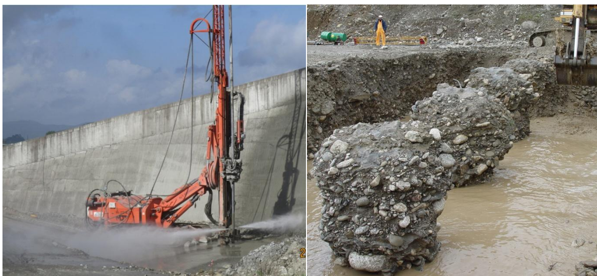
Φωτογραφία 2.1. Διαδικασία κατασκευής εδαφοπασσάλων τύπου jet grouting
