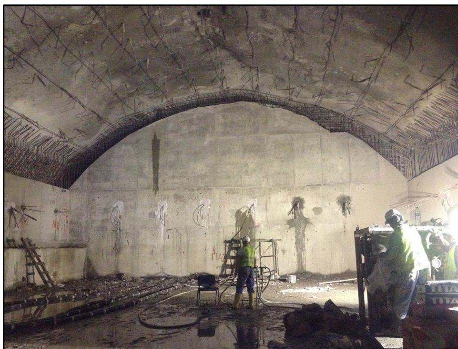
Φωτογραφία 2.3. Οροφή και Β' φάση σταθμού παραγωγής
