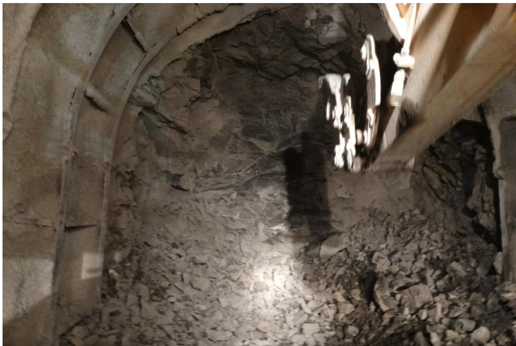
Φωτογραφία 7.1. Χρήση εκρηκτικών και μηχανικών μέσων για την προχώρηση της διάνοιξης (συμβατική μέθοδος)
