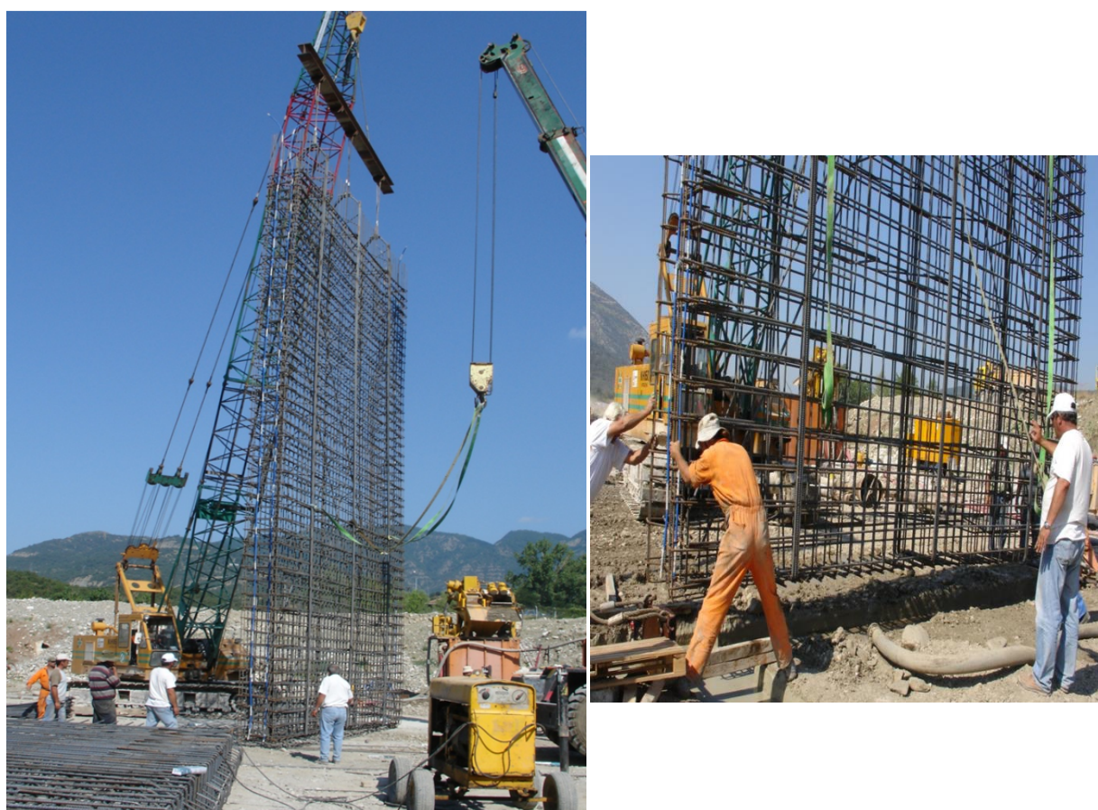
Φωτογραφία 2.2. Τοποθέτηση οπλισμένου διαφράγματος
