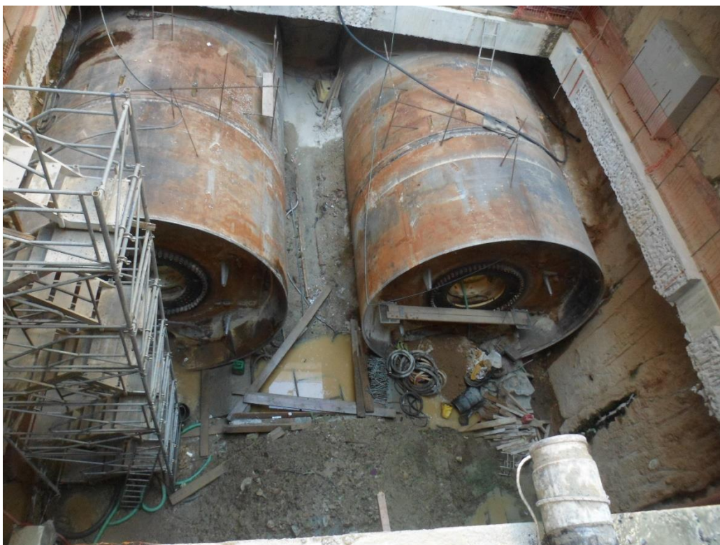
Εικόνα 7.26. Μηχανήματα EPB στον υπόγειο σταθμό Συντριβάνι του Μετρό Θεσσαλονίκης.
