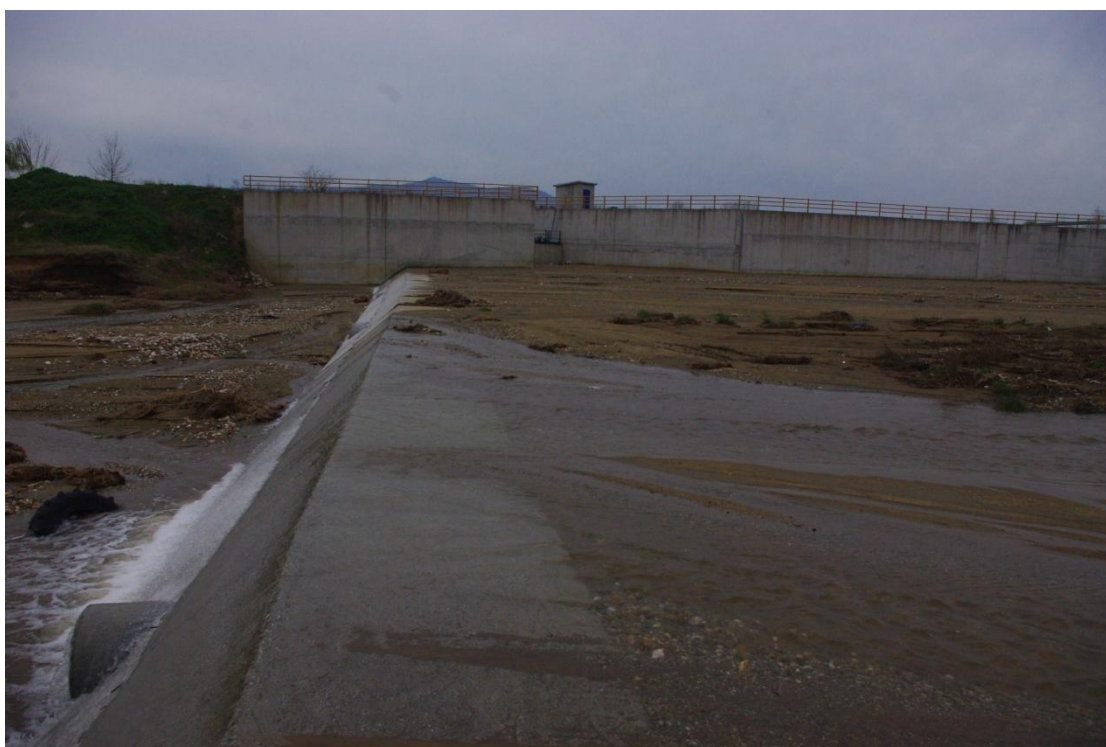
Φωτ.12. Χείμαρρος Σχολαρίου, θέση λήψης δείγματος SHOL.04. Στο βάθος διακρίνεται ο ρουφράκτης στην είσοδο της διώρυγας διαχείρισης (Ημ. Λήψης: 15/03/2015)
