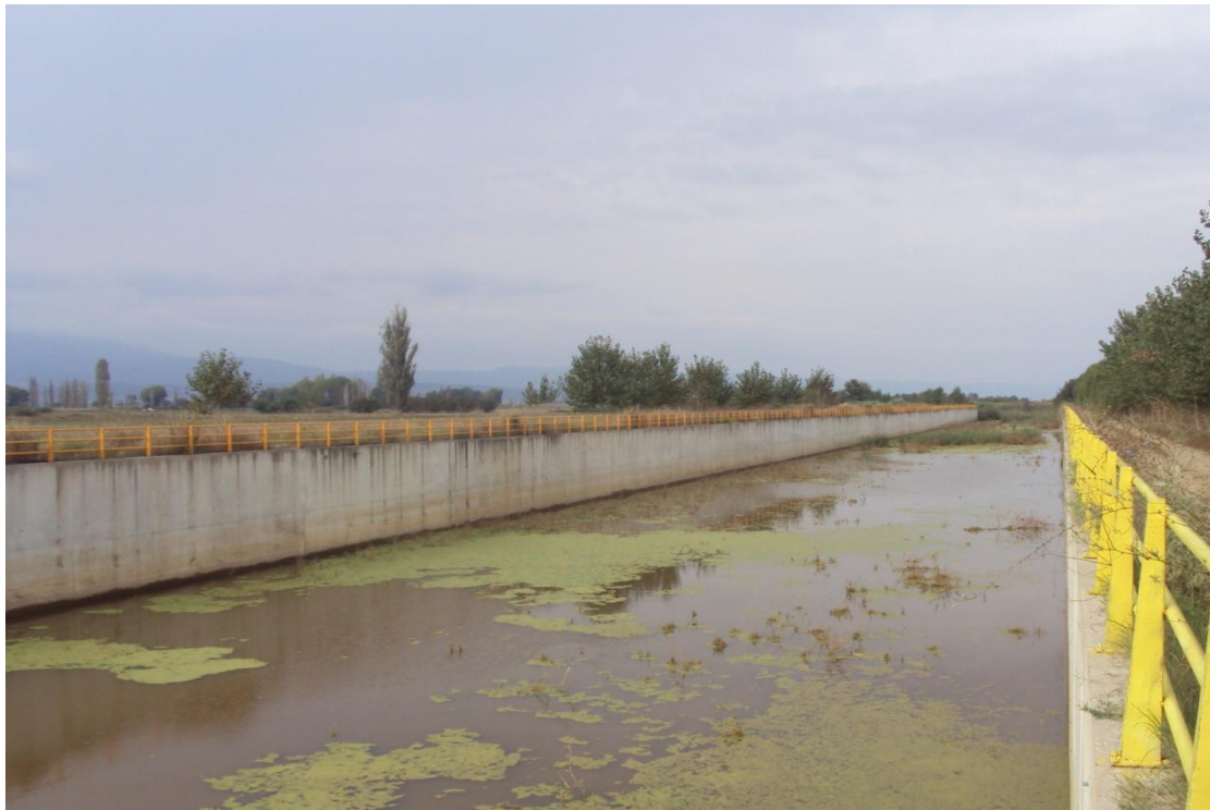
Φωτ.7. Αποψη της ενωτικής τάφρου στη θέση κατασκευής των τοιχίων αντιστήριξης (Ημ. Λήψης: 03/10/2014)
