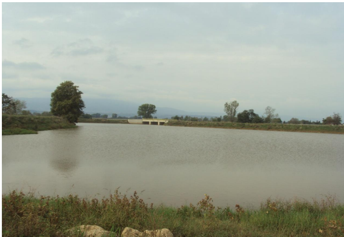
Φωτ.5. Λεκάνη αναρρύθμισης. Στο βάθος διακρίνεται η επαρχιακή οδός Λαγκαδικίων-Λαγκαδά και το ανατολικό όριο της ενωτικής τάφρου (Ημ. Λήψης: 03/10/2014)
