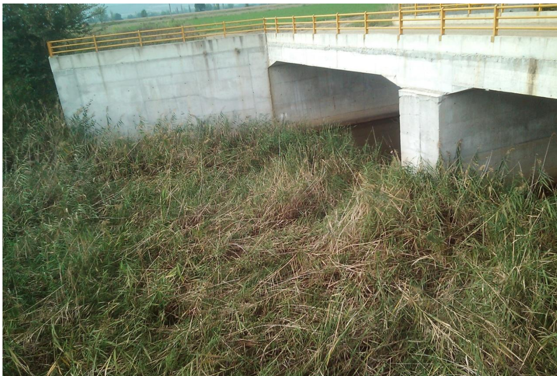
Φωτ.19. Καλαμώνες εντός της ενωτικής τάφρου (Ημ. Λήψης: 03/10/2014)
