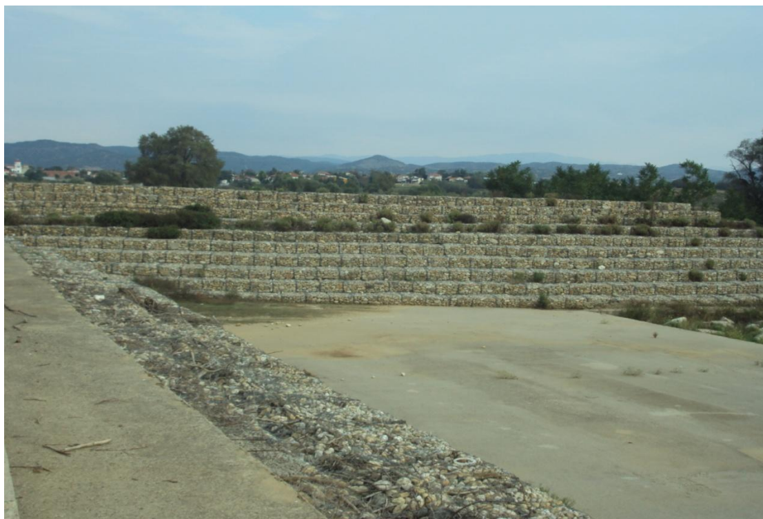
Φωτ.6. Φράγμα λεκάνης αναρρύθμισης αποτελούμενο από σκυρόδεμα και λιθόπλήρωτα συρματοκιβώτια (σαραζανέτια) (Ημ. Λήψης: 03/10/2014)
