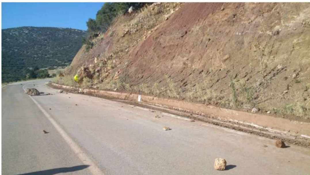
Σχήμα 2.10 Βραχοπτώσεις σε οδικό άξονα ( www.oasp.gr ).
