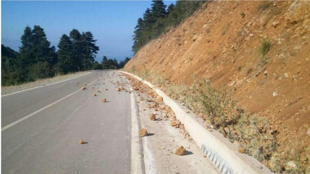
Σχήμα 2.9 Βραχοπτώσεις σε οδικό άξονα ( www.oasp.gr ).
