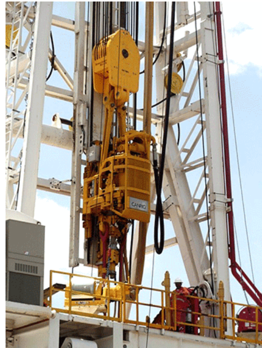
Επικρεμώμενος κινητήρας – top drive system
