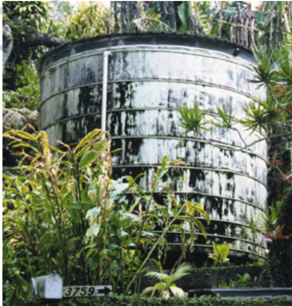
Εικόνα 3: Ξύλινη δεξαμενή νερού στη Χαβάη, ΗΠΑ http://www.unep.or.jp/ietc/publications/urban/urbanenv-2/9.asp
