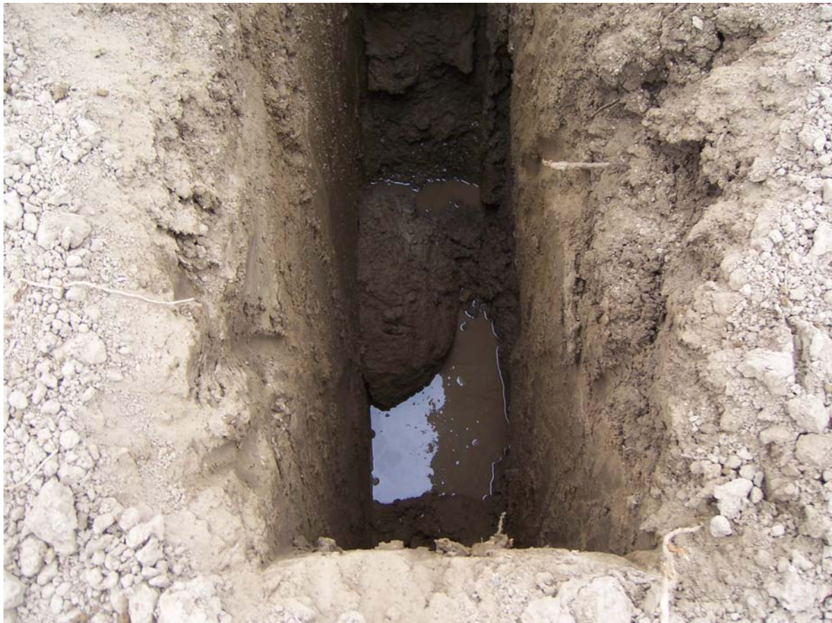
Φωτογραφία 6: Θέση δειγματοληψίας E2 στα 2,10m, όπου συναντήθηκε νερό.
