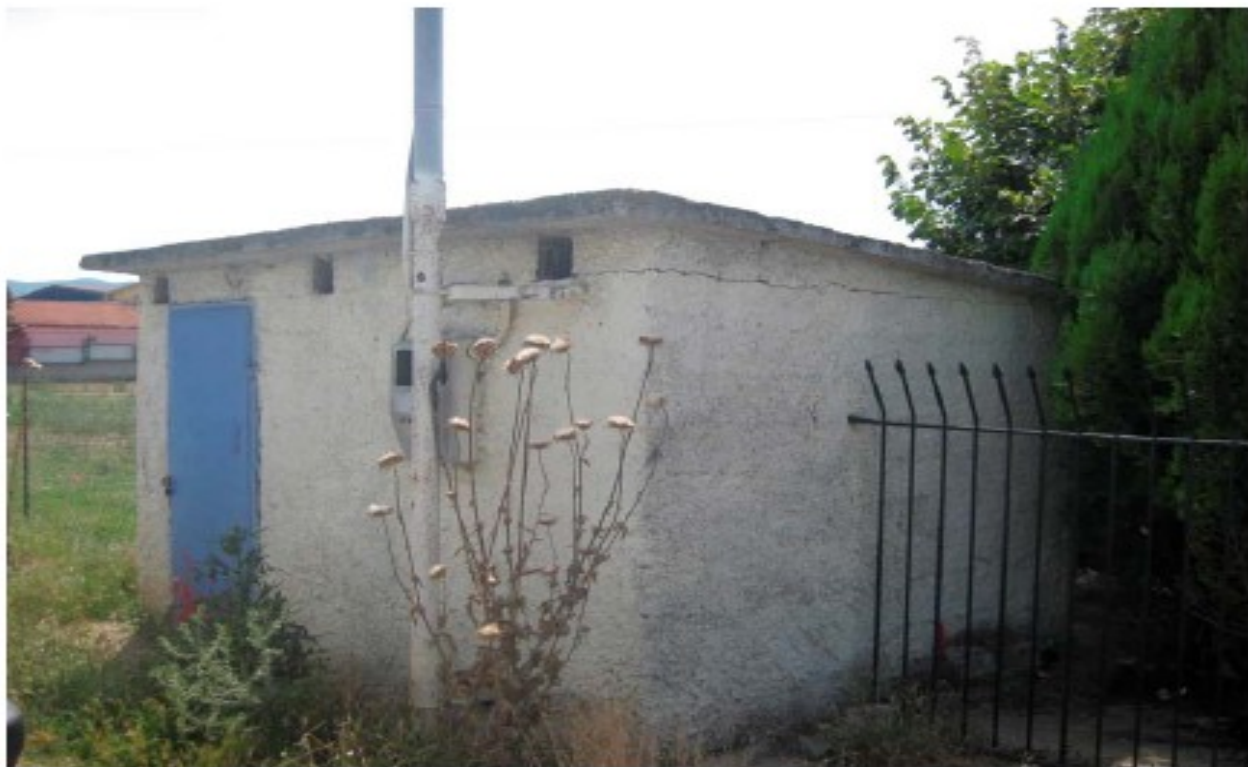
Φωτογραφία 7: Υδρευτική γεώτρηση Γ.8 Τοπικού Διαμερίσματος Λαγκαδικίου
