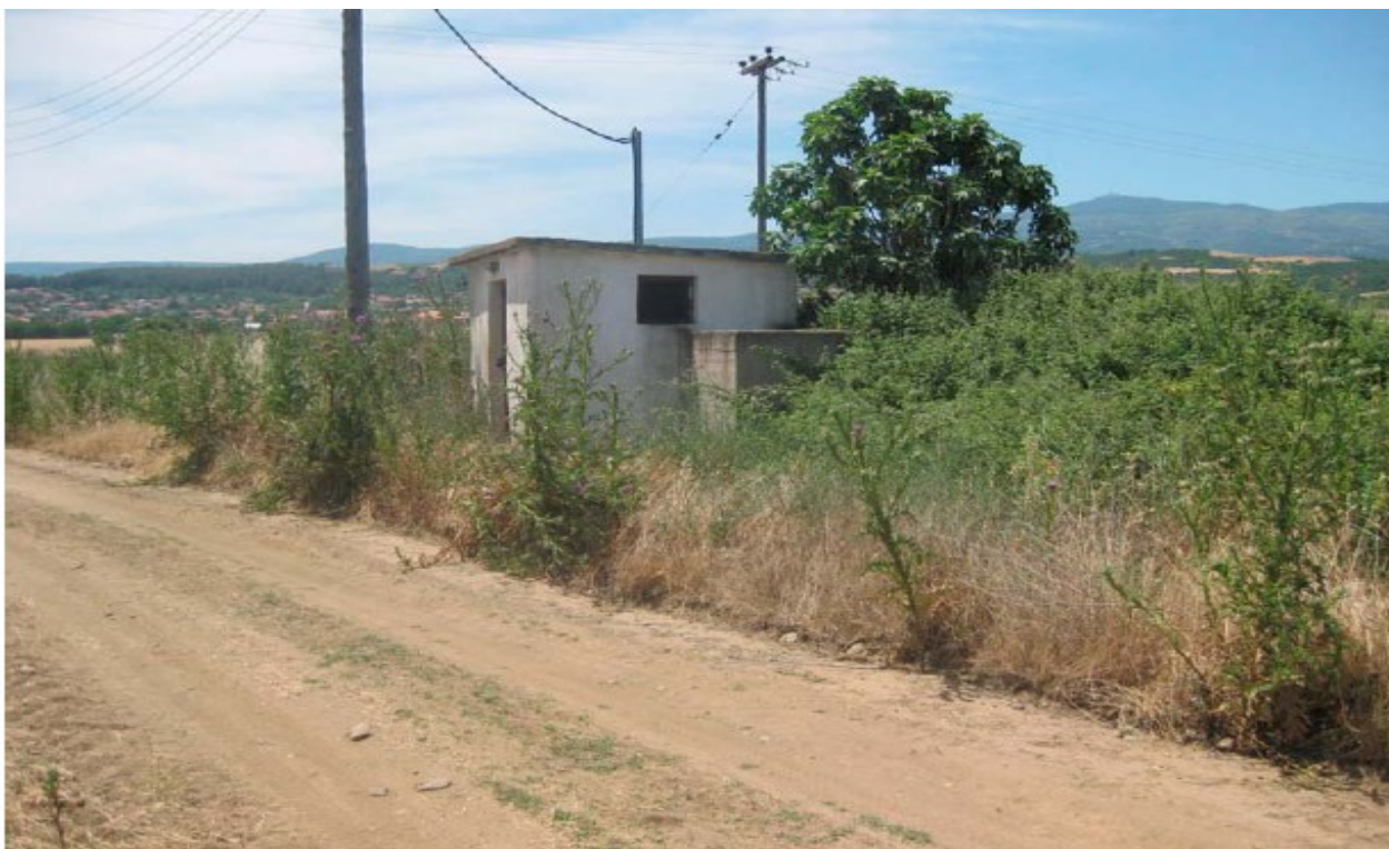
Φωτογραφία 6: Υδρευτική γεώτρηση Τοπικού Διαμερίσματος Γερακαρούς
