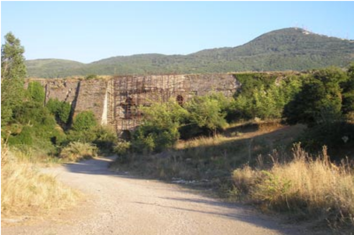
Εικόνα 6 : Γενική άποψη Υδραγωγείου του Χορτιάτη.
