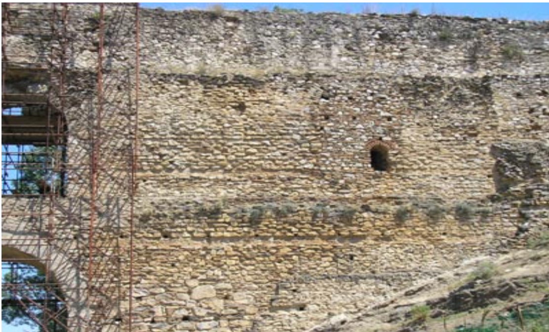
Εικόνα 7 : Εργασίες αποκατάστασης του Υδραγωγείου.
