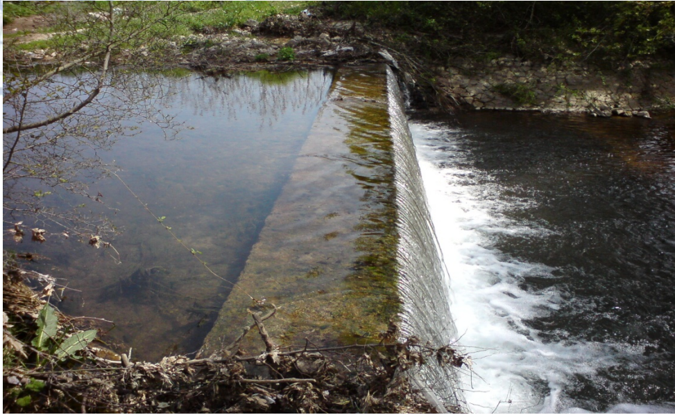
Εικ. 4. Έχουν χτίσει δύο τέτοια μικρά φράγματα ανάσχεσης της ροής, τα οποία συγκρατούν τα πολύ χοντρόκοκκα υλικά, κυρίως κροκάλες και χαλίκια, τα οποία τα συναντούμε μόνο στα βορειότερα σημεία του ριπιδίου, πριν τα φράγματα. Η γεωγραφική θέση του συγκεκριμένου είναι 40^{\circ} 47' 54,7'' , 22^{\circ} 20' 6,5'' .
