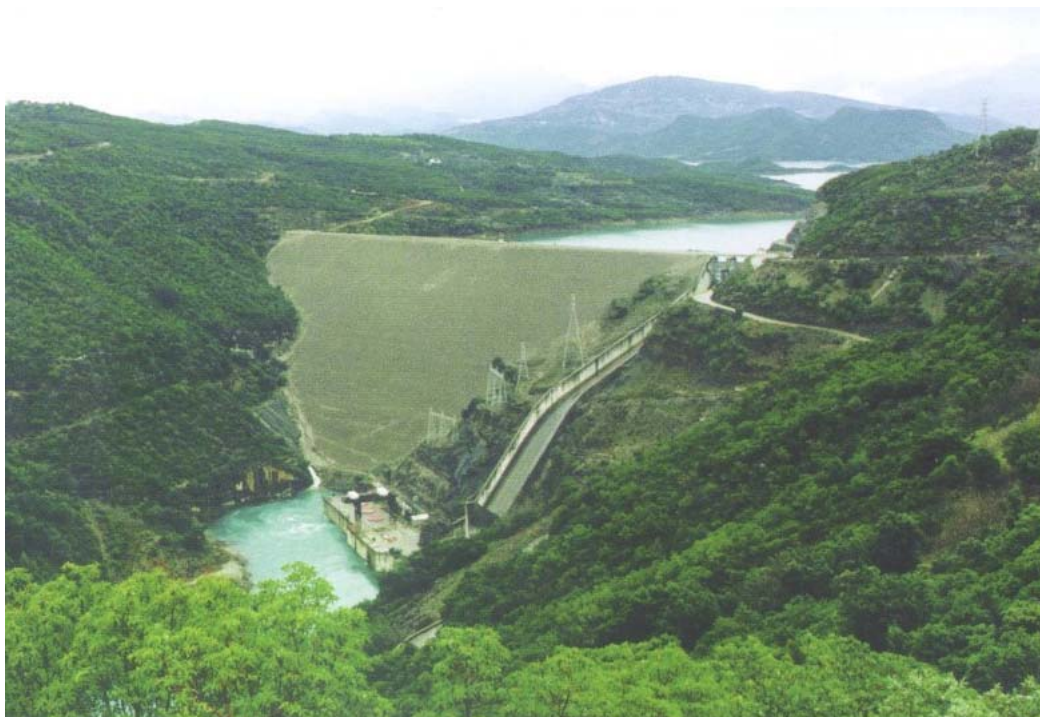
Εικόνα 6: Κατάντι όψη του φράγματος των Κρεμαστών. (Αχελώος Ποταμός). Η κατασκευή του φράγματος ολοκληρώθηκε τον Ιανουάριο του 1966.(ΕΛΚΕΘΕ)
