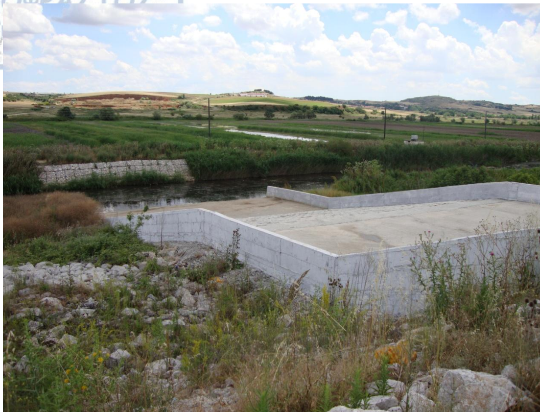
(Εικ.7) Υπερχειλιστήρας από την πλευρά του καναλιού αποστράγγισης
