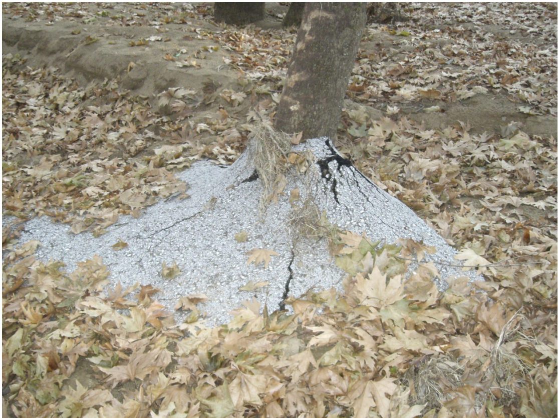
Εικόνα 13 φερτά υλικά εξ αιτίας διαβρωτικής δράσης νερού
