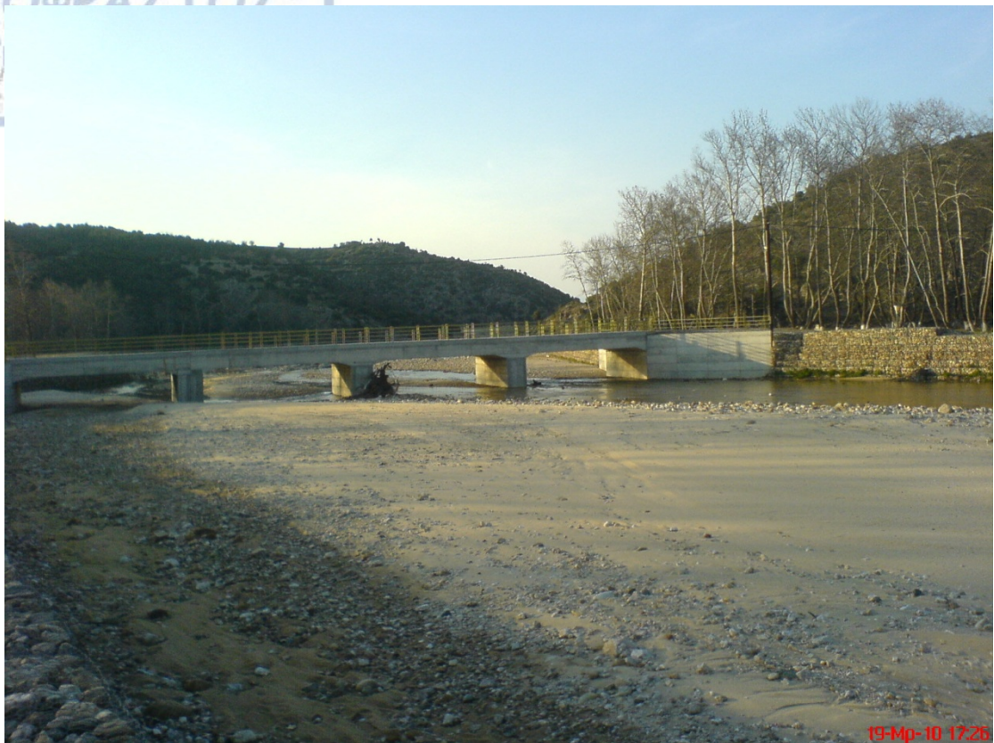
Εικόνα 26 κατασκευή γέφυρας - αντιπλημμυρικά έργα Μελισσουργού
