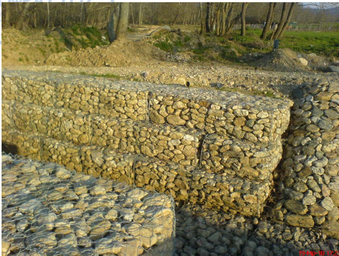
Εικόνα 24 πλακόστρωτος οχετός - αντιπλημμυρικά έργα Μελισσουργού
