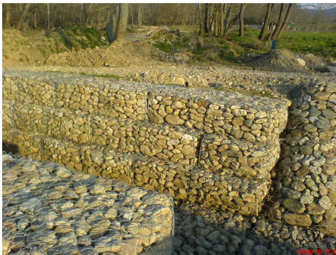
Εικόνα 25 πλακόστρωτος οχετός - αντιπλημμυρικά έργα
