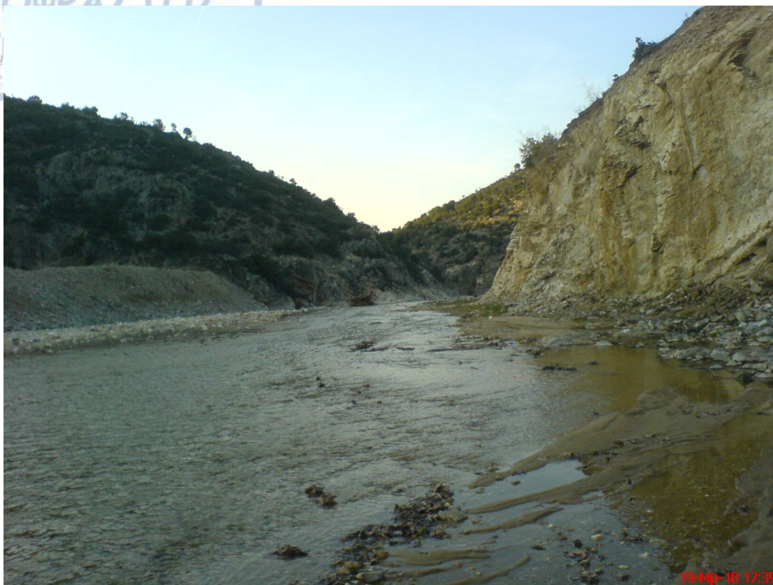
Εικόνα 30 διάνοιξη στα χείμαρρο Μελισσουργού στα στενά του φαραγγιού
