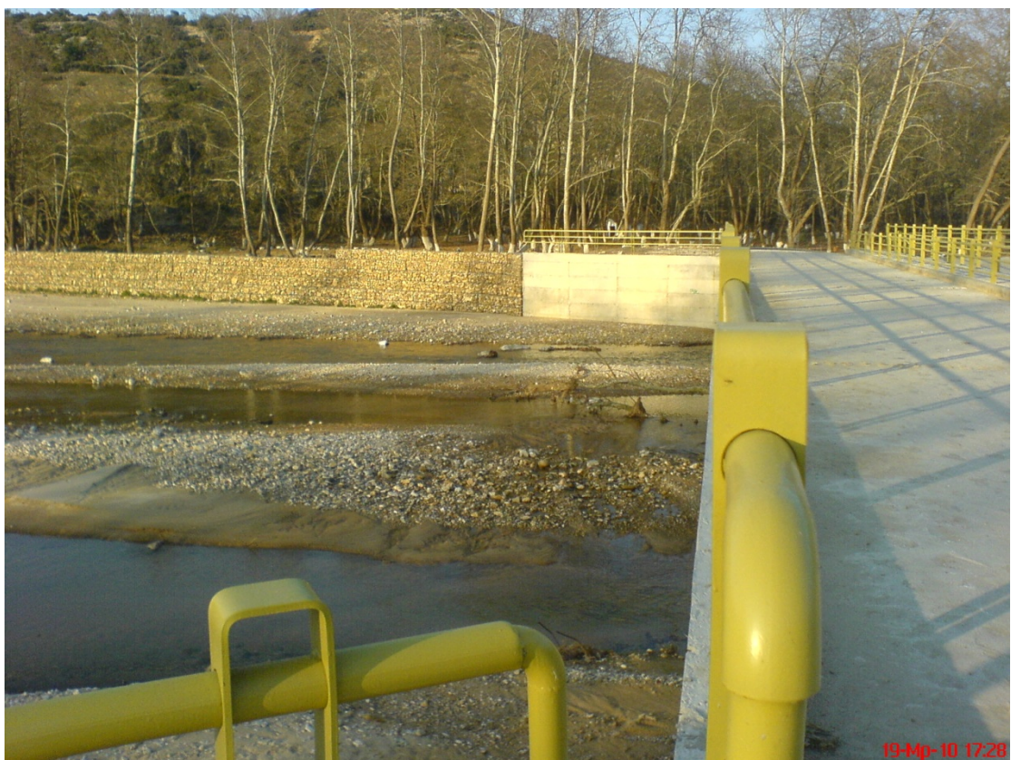
Εικόνα 27 κατασκευή γέφυρας - αντιπλημμυρικά έργα Μελισσουργού
