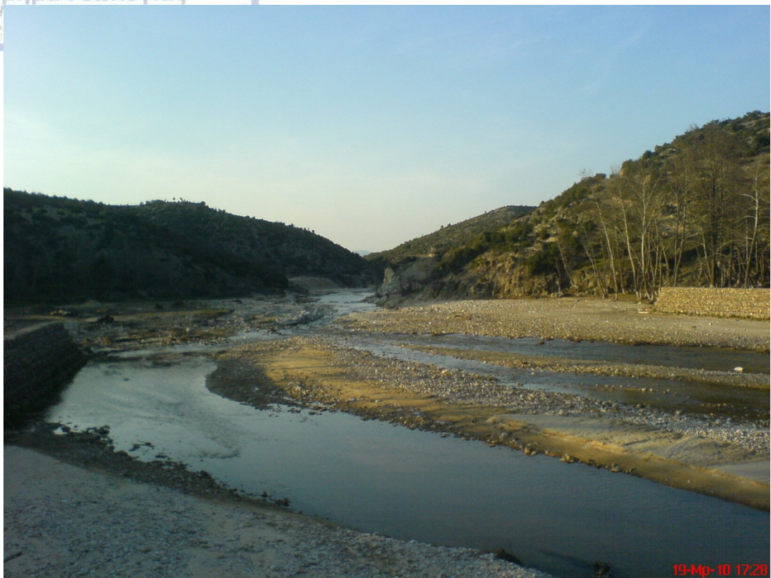
Εικόνα 28 διευθέτηση και διάνοιξη κοίτης χειμάρρου Μελισσουργού
