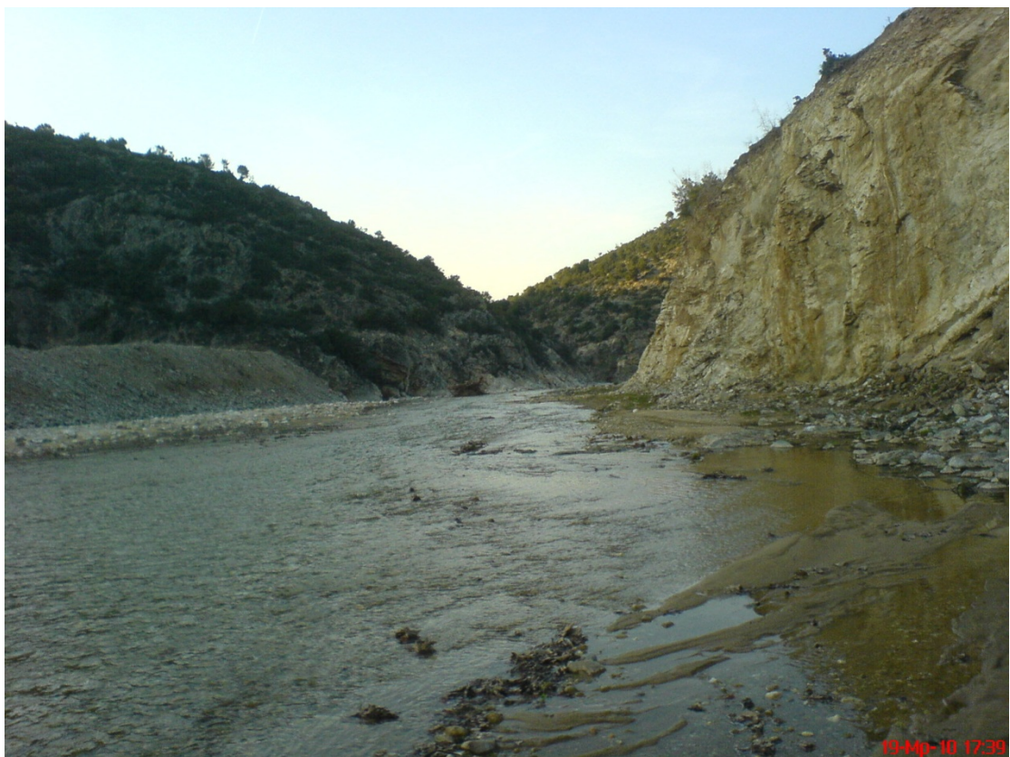
Εικόνα 29 διάνοιξη κοίτης χειμάρρου Μελισσουργού
