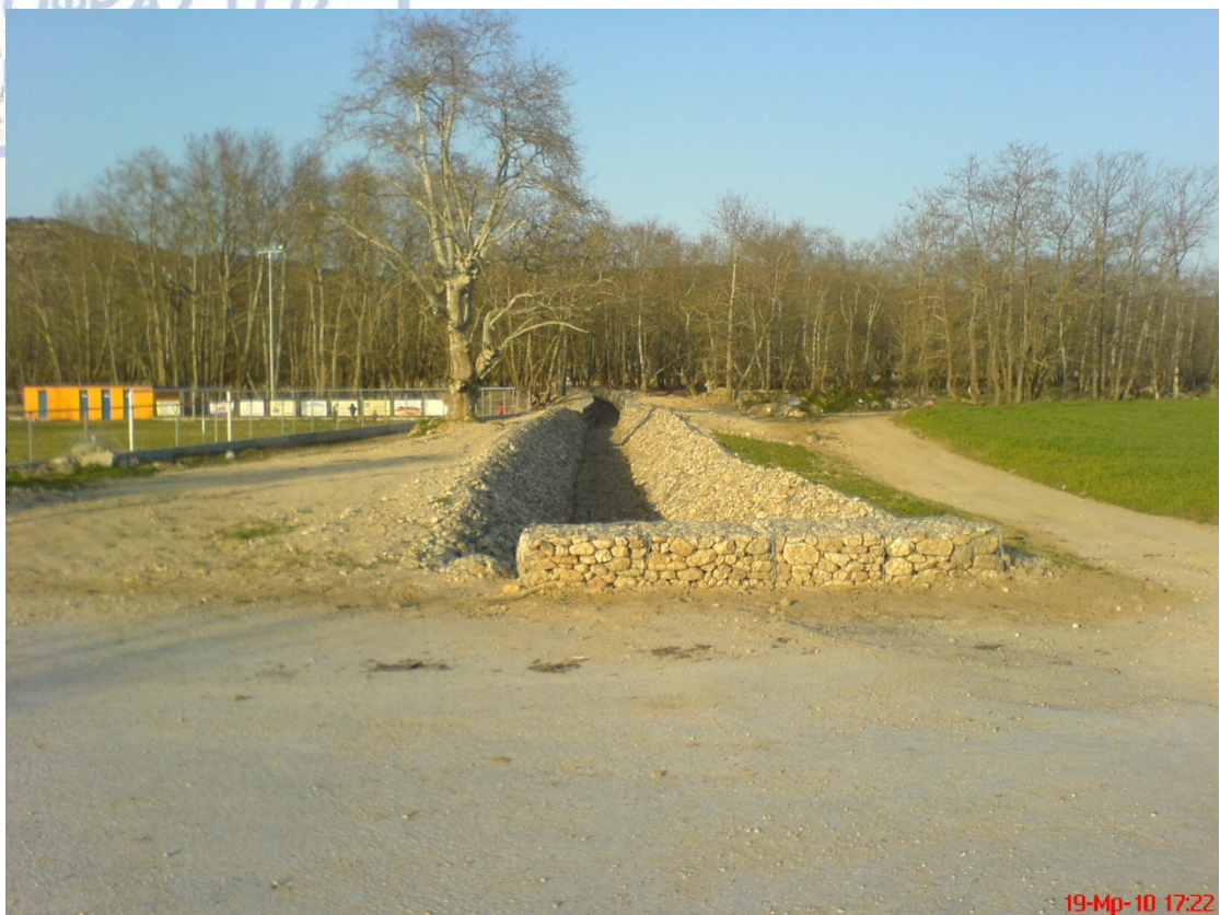
Εικόνα 22 πλακόστρωτος οχετός- αντιπλημμυρικά έργα Μελισσουργού
