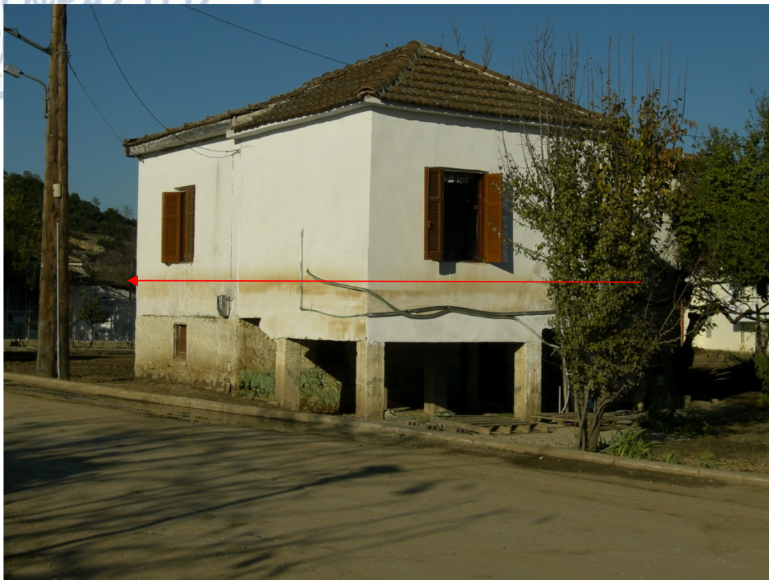
Εικόνα 20 ύψος πλημμύρας σε οίκημα στη χαμηλή ζώνη του χωριού
