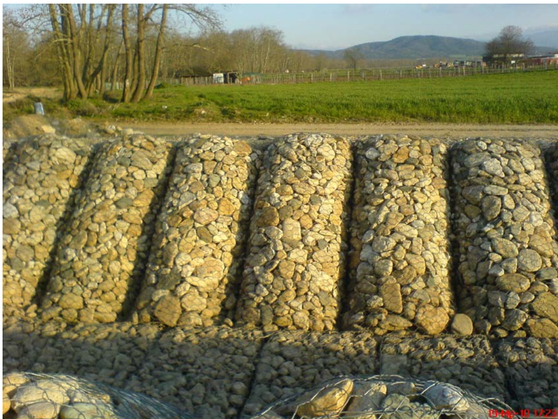
Εικόνα 23 πλακόστρωτος οχετός - αντιπλημμυρικά έργα Μελισσουργού
