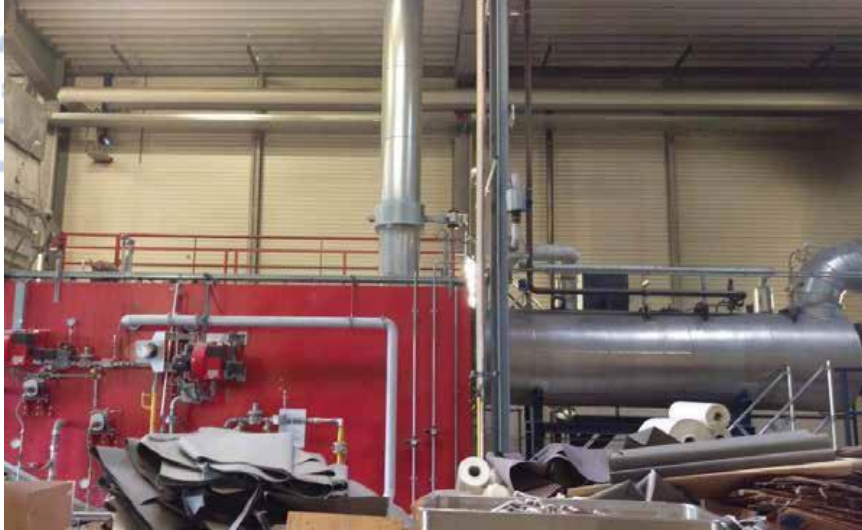
Εικ.9: Αποτεφρωτήρας 5000 τόνων για καύση τοξικών αποβλήτων στην Λεμεσό(Πηγή: philenews.com)
