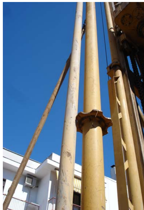
Εικόνα 16. Τοποθέτηση καινούριου στελέχους..
