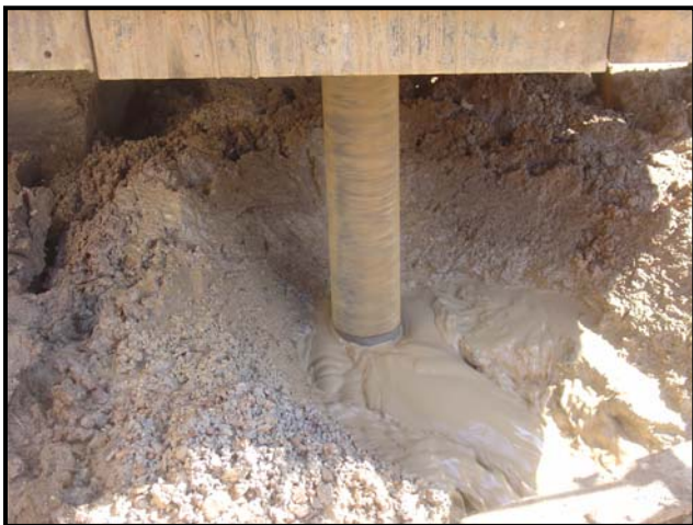
Εικόνα 9. Έναρξη της γεώτρησης (φωτογραφία 1 η ).
