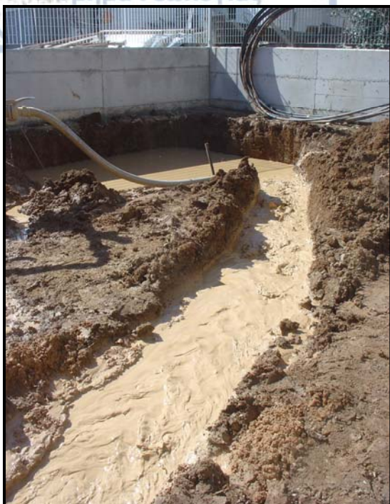
Εικόνα 1. Λάκκος απομάκρυνσης του πολτού κυκλοφορίας.
