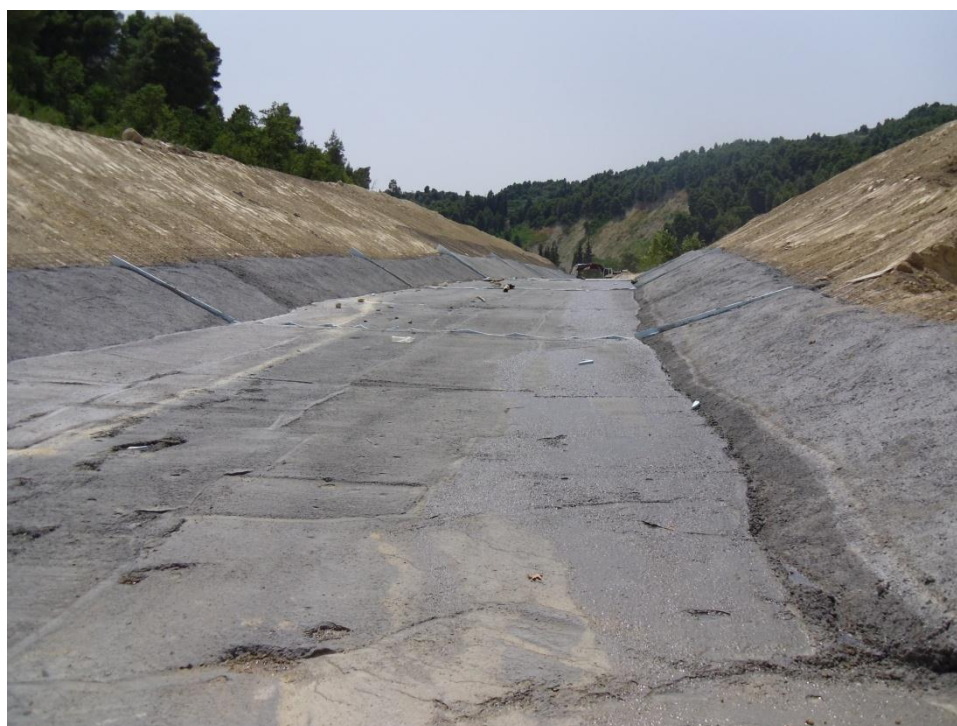
Εικόνα 12: Έργα της κατασκευής του φράγματος στου Ασωπό ποταμό (πηγή: www.ekorinthos.gr )
