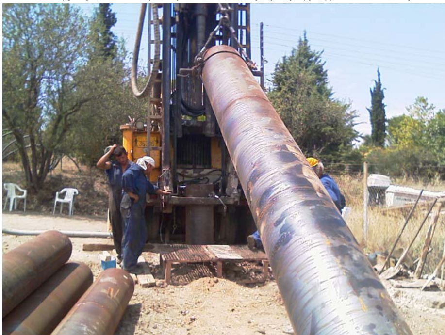
Φωτογραφία 6. Ανύψωση και τοποθέτηση περιφραγματικού σωλήνα.
