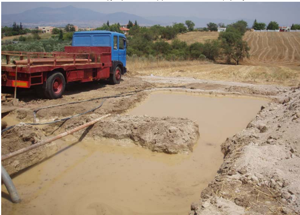
Φωτογραφία 3. Σκάμμα πολτού κυκλοφορίας.
