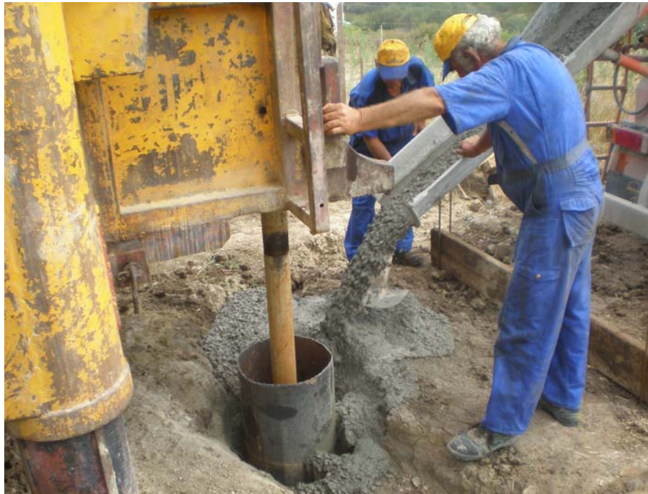
Φωτογραφία 7. Εργασίες τσιμέντωσης.
