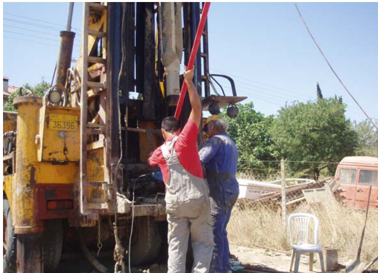
Φωτογραφία 13. Τοποθέτηση φορατή.
