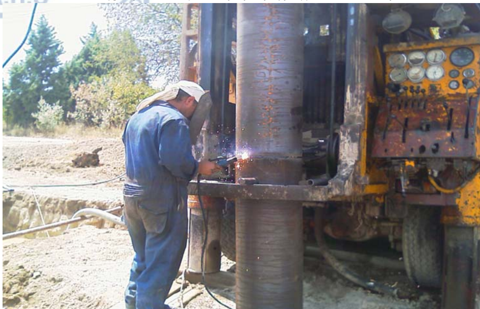
Φωτογραφία 5. Συγκόλληση περιφραγματικών σωλήνων.
