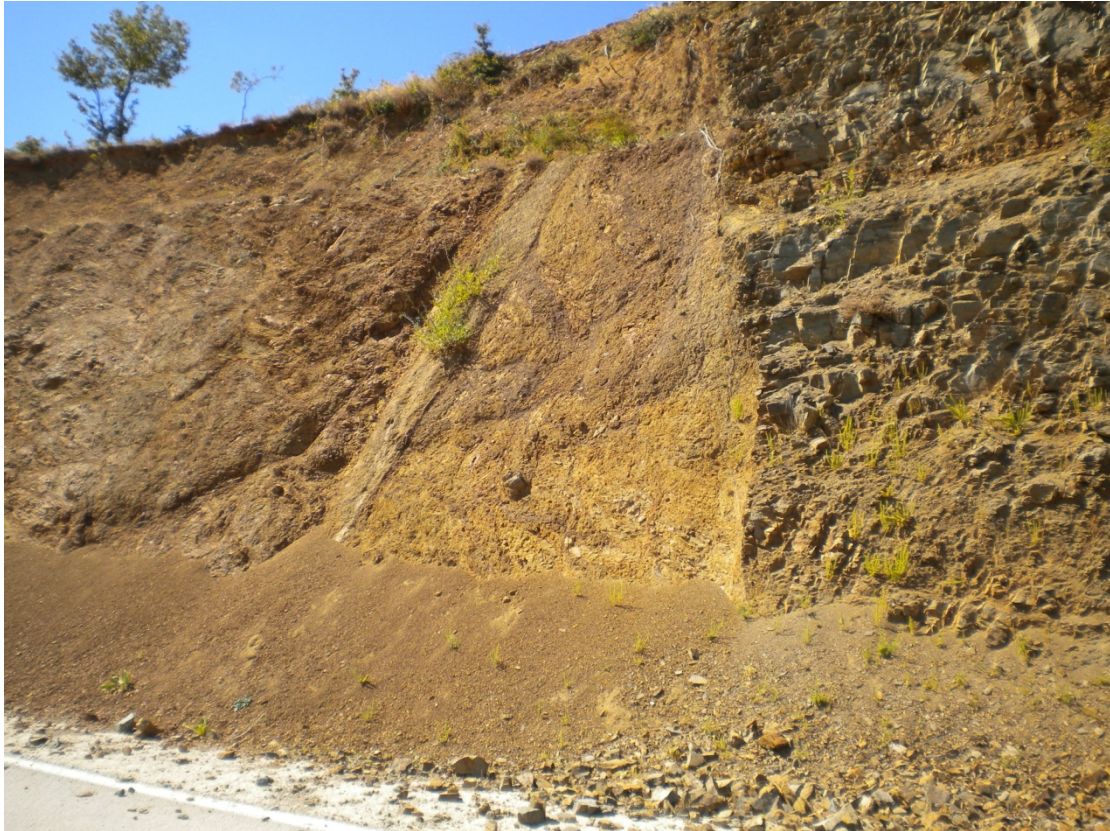
Φωτογραφία 4.8. Τύπος VIII γνευσιακής βραχώμαζας στην περιοχή μελέτης (στο κέντρο). Ζώνη διάτμησης.
