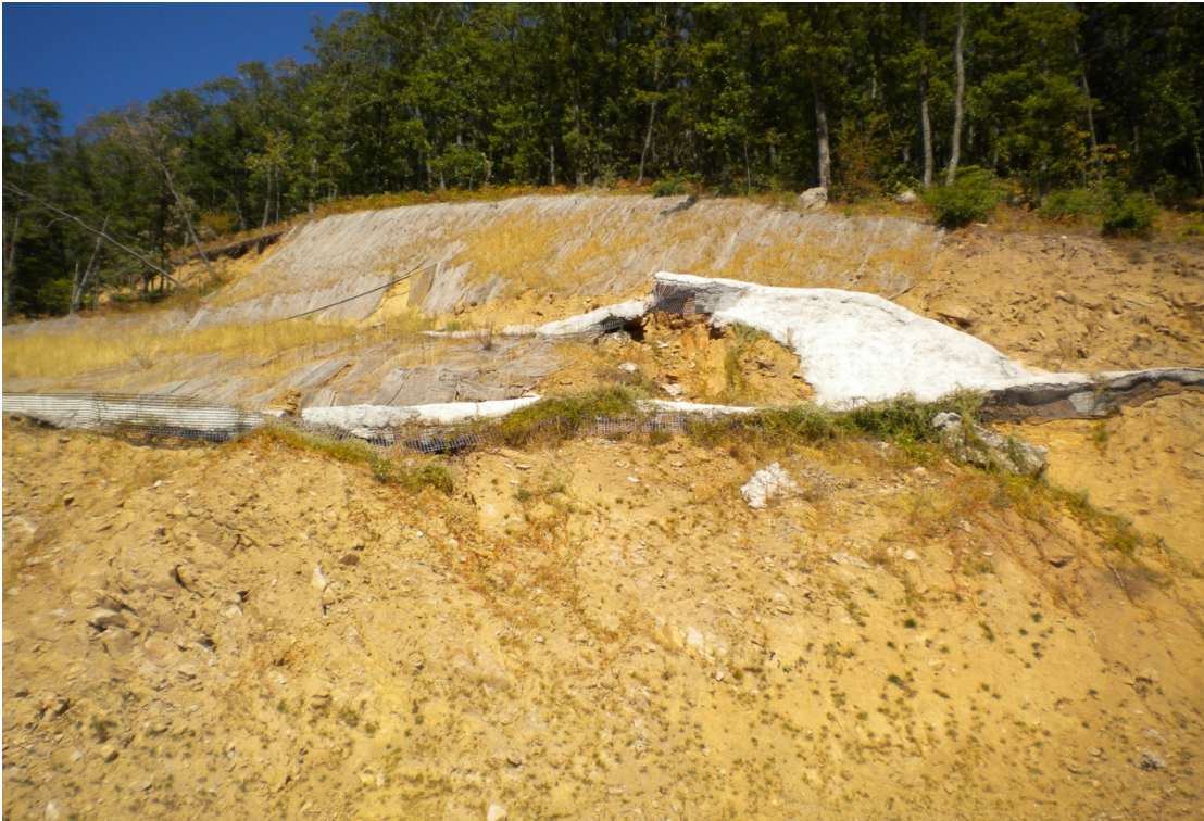
Φωτογραφία . Η δεξιά άποψη του αμφίπλευρου Ο28. Πάνω αριστερά διακρίνεται το φρύδι της κατολίσθησης που δημιουργήθηκε από την δεύτερη αστοχία του το 2012.
