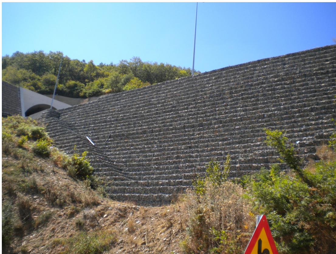
Φωτογραφία . Ζαρζανέτια του επιχώματος 34
