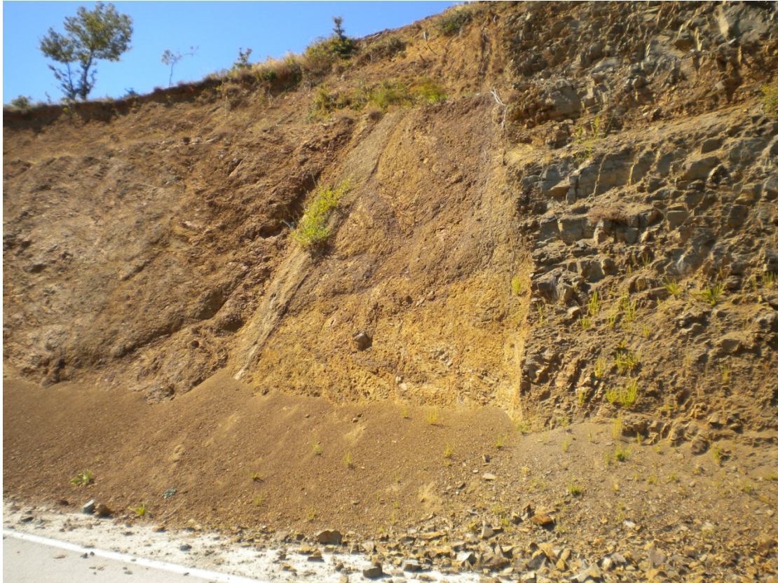
Φωτογραφία 5.8. Ζώνη διάτμησης GSI < 10
