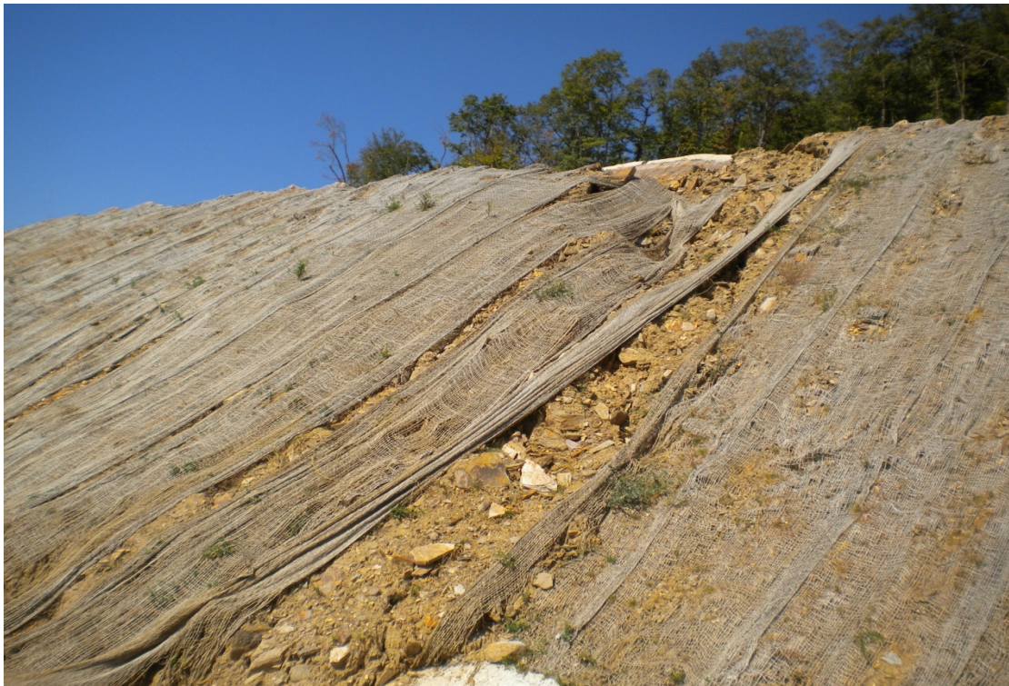
Φωτογραφία . Γεωυφάσματα τύπου GEOMAT που τοποθετήθηκαν πριν την κατολίσθηση στο O28.
