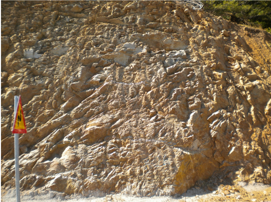
Φωτογραφία 5.1. Μη αποσαθρωμένη γνευσιακή βραχόμαζα στη περιοχή μελέτης. GSI=70-80
