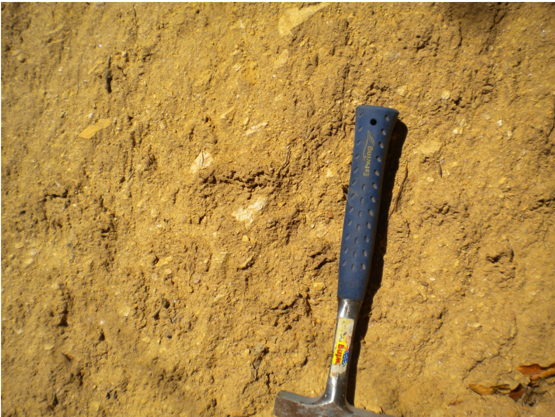
Φωτογραφία . Η επιφάνεια του ρήγματος (παραοριζόντια ζώνη διάτμησης) διεύθυνσης Α-Δ που βρίσκεται πλευρικά της μάζας της κατολίσθησης.
