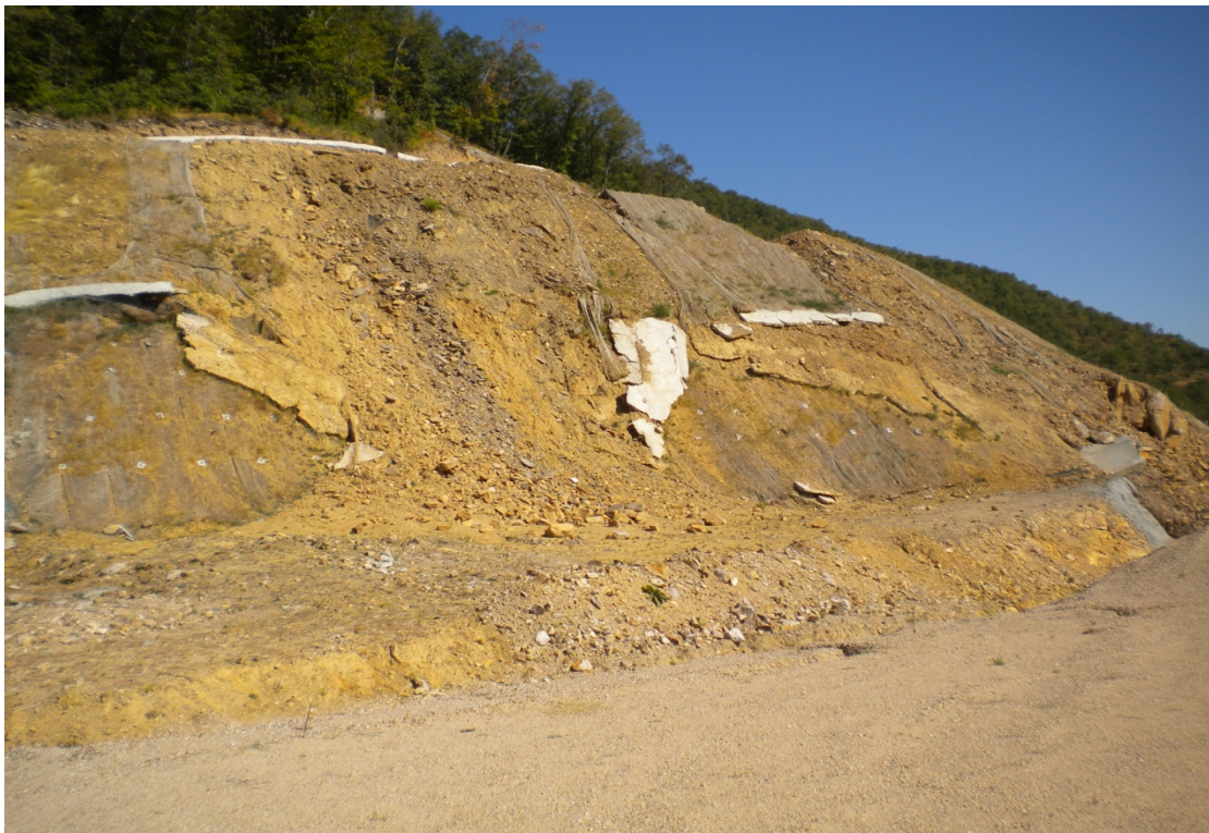
Φωτογραφία . Η αριστερή άποψη του Ο28. Διακρίνονται οι θραύσεις των αναβαθμών ( με τα φρέατα) και των τσιμέντινων δοκαριών.
