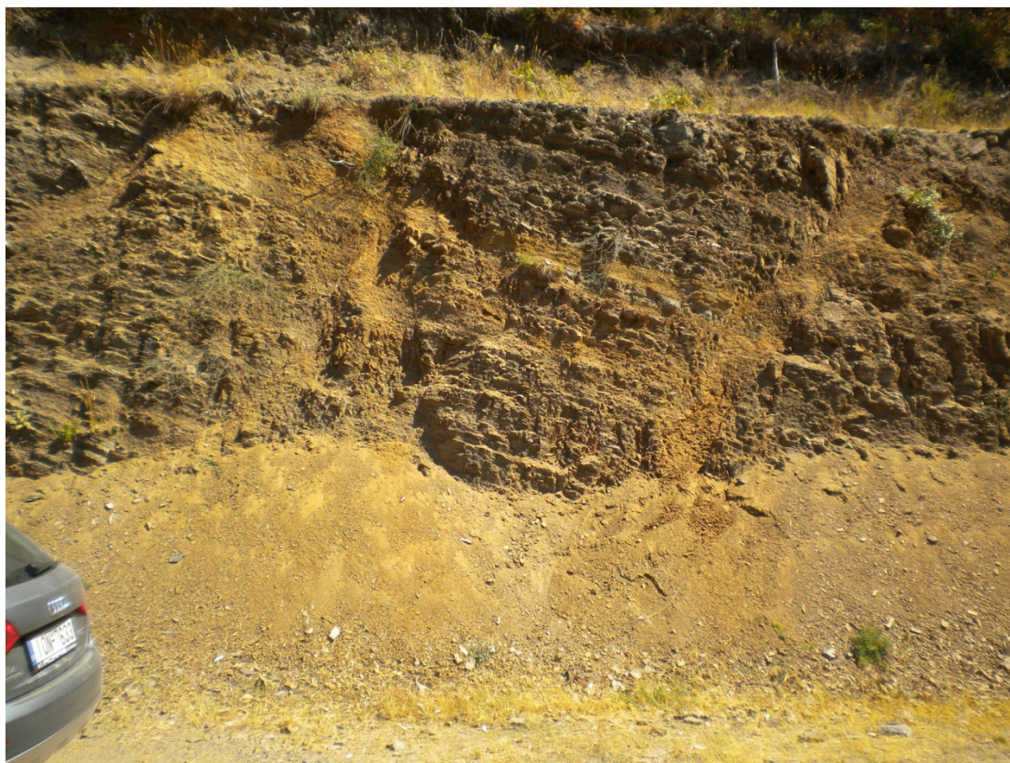
Φωτογραφία 5.4. Αποσαθρωμένη γνευσιακή βραχώμαζα της περιοχής μελέτης. GSI=30-40
