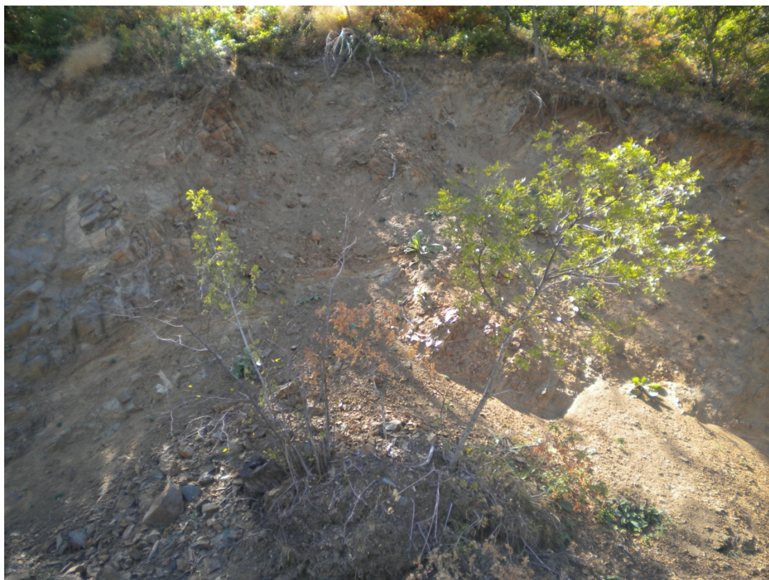
Φωτογραφία 5.7. Πλήρως αποσαθρωμένη γνευσιακή βραχώμαζα της περιοχής μελέτης. Διακρίνεται κατάπτωση ενός δενδριλίου από την κορυφή του πρανούς. GSI=10-20
