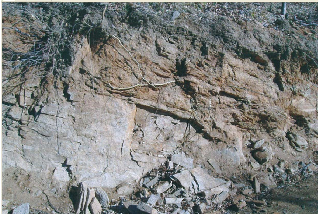
Φωτογραφία 5.2. Ελαφρώς αποσαθρωμένη γνευσιακή βραχώμαζα της περιοχής μελέτης. GSI=50-60
