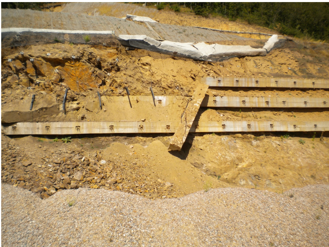
Φωτογραφία . Καταστροφή των τσιμέντινων δοκαριών στο Ο28.
