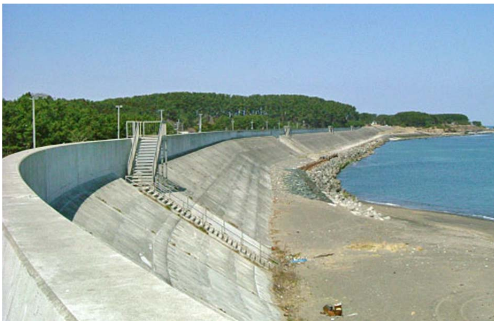
Εικόνα 3.8: Τοίχος προστασίας-Seawall. (URL 8 )
