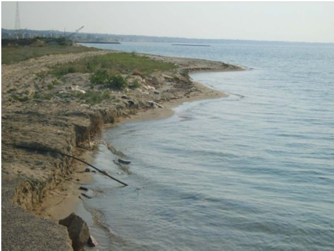
Εικόνα 3: Έντονη διαβρωτική διαδικασία στην Περαιά, κοντά στο αεροδρόμιο.
