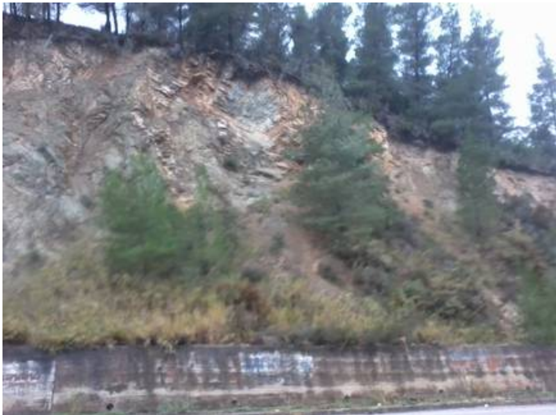
ΦΩΤΟΓΡΑΦΙΑ18: ΜΕΤΑΜΟΡΦΩΜΕΝΑ ΠΕΤΡΩΜΑΤΑ ΜΕΣΗΣ ΔΙΑΒΡΩΣΙΜΟΤΗΤΑΣ
