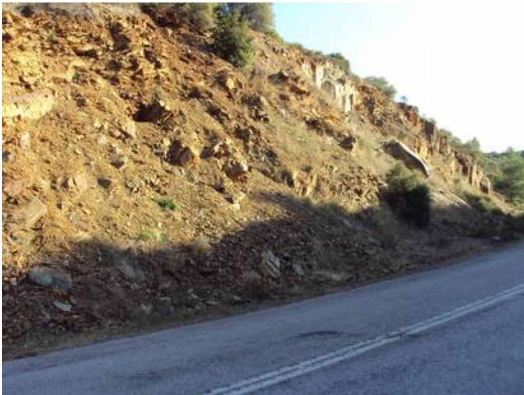
ΦΩΤΟΓΡΑΦΙΑ 53: ΑΛΛΗ ΛΗΨΗ ΤΟ ΠΕΤΡΩΜΑ ΕΧΕΙ ΔΙΑΒΡΩΘΕΙ ΤΕΛΕΙΩΣ.
