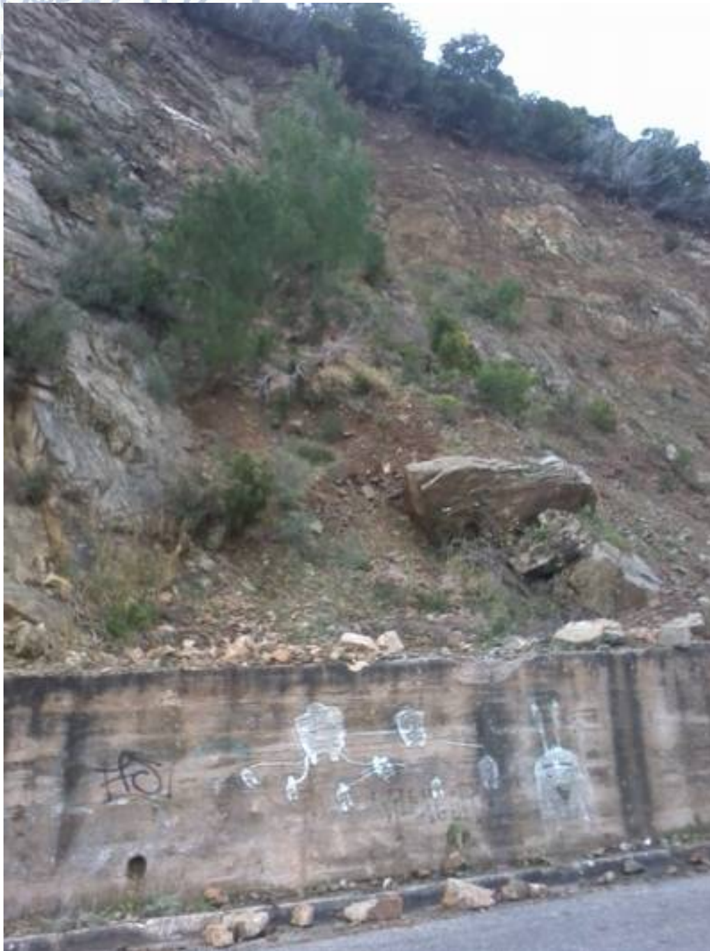
ΟΓΡΑΦΙΑ 26: ΚΑΤΑΠΤΩΣΗ ΜΕΓΑΛΩΝ ΤΕΜΑΧΙΩΝ ΤΟΥ ΓΕΥΣΙΟΥ ΑΠΟ ΤΟ ΠΡΑΝΕΣ ΣΤΟ ΠΡΟΣΤΑΤΕΥΤΙΚΟ ΤΕΙΧΟΣ
