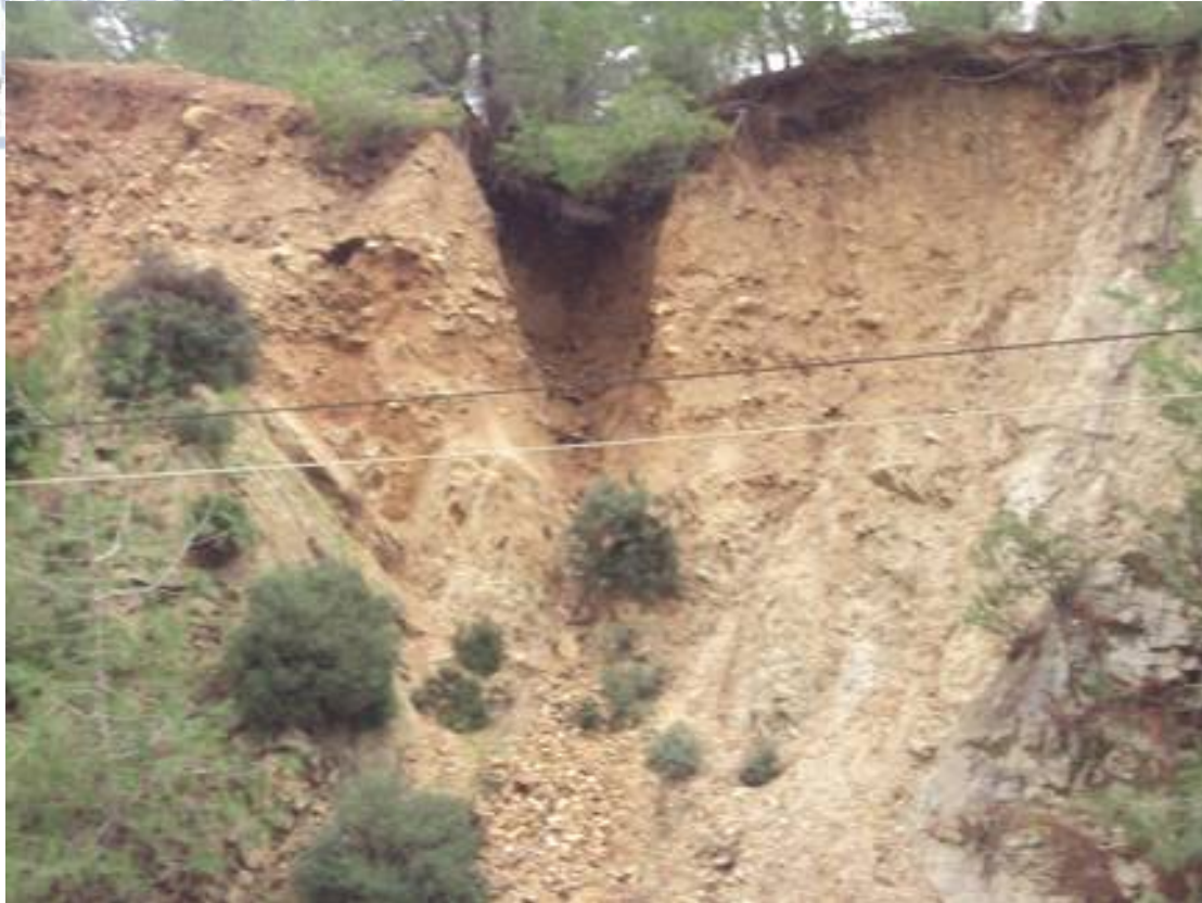
ΦΩΤΟΓΡΑΦΙΑ14: ΔΕΞΙΑ ΠΛΕΥΡΑ ΤΟΥ ΔΡΟΜΟΥ ΠΑΡΑΤΗΡΕΙΤΑΙ Η ΧΑΡΑΚΤΗΡΙΣΤΗΚΗ ΜΟΡΦΗ ΥΠΟΛΕΙΜΜΑΤΙΚΗΣ ΔΙΑΒΡΩΣΗΣ.ΣΕΙΡΑ ΕΡΥΘΡΩΝ ΑΡΓΙΛΩΝ ΜΕ ΥΨΗΛΗ ΕΠΙΚΙΝΔΥΝΟΤΗΤΑ ΔΙΑΒΡΩΣΗΣ.
