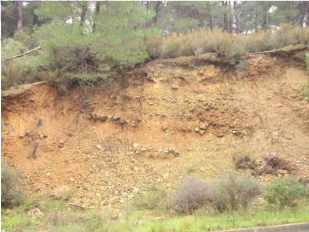
ΦΩΤΟΓΡΑΦΙΑ15 :ΔΙΑΒΡΩΣΗ ΛΟΓΩ ΤΗΣ ΚΛΙΣΗΣ ΤΟΥ ΠΡΑΝΟΥΣ ΤΗΣ ΣΕΙΡΑΣ ΕΡΥΘΡΩΝ ΑΡΓΙΛΩΝ ΜΕ ΥΨΗΛΗ ΙΚΑΝΟΤΗΤΑ ΔΙΑΒΡΩΣΗΣ.
