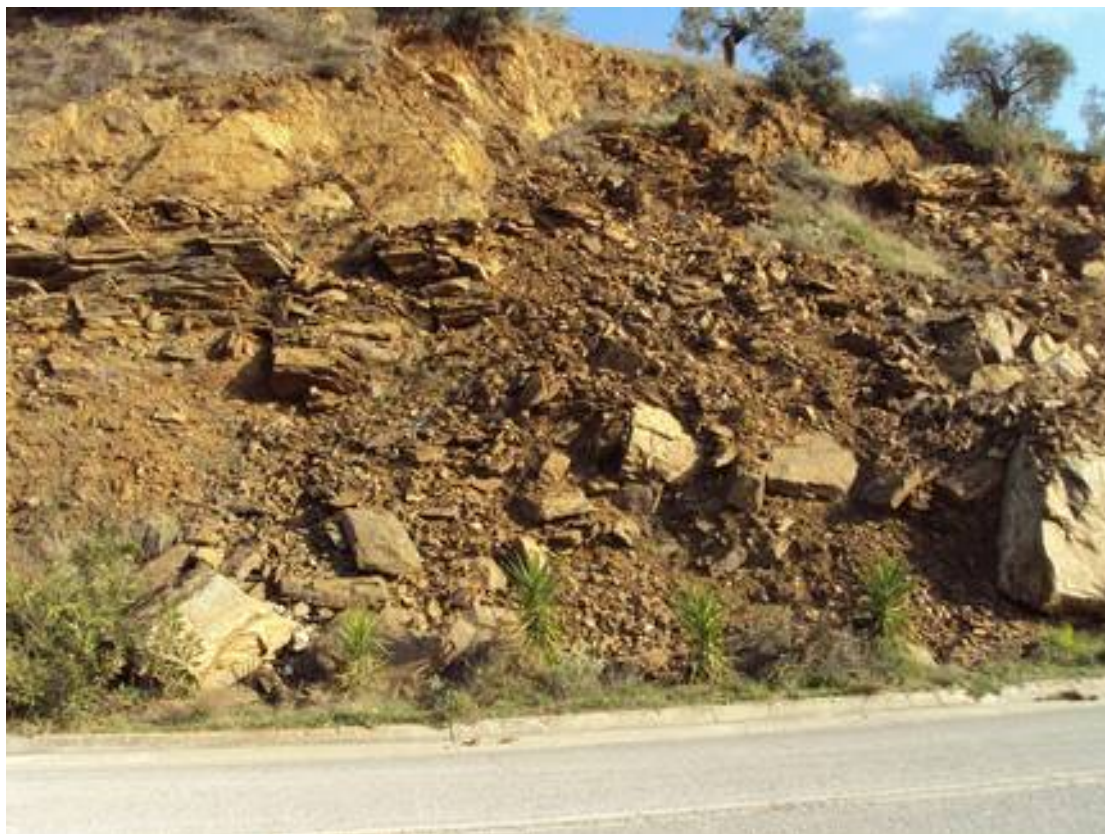
ΦΩΤΟΓΡΑΦΙΑ 47: ΚΑΤΟΛΙΣΘΗΣΗ ΠΡΑΝΟΥΣ-ΑΠΟΚΟΛΛΗΣΗ ΟΓΚΟΛΙΘΩΝ ΑΠΟ ΤΗΝ ΚΥΡΙΑ ΜΑΖΑ
