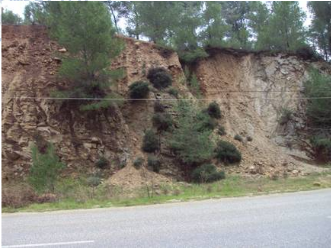
ΦΩΤΟΓΡΑΦΙΑ12 :ΔΕΞΙΑ ΠΛΕΥΡΑ ΤΟΥ ΔΡΟΜΟΥ ΣΤΟ ΒΑΘΟΣ ΥΠΑΡΧΕΙ
