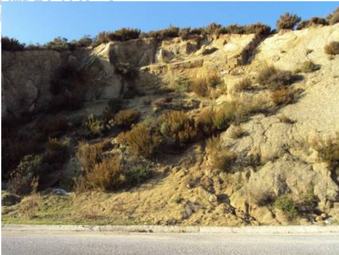
ΦΩΤΟΓΡΑΦΙΑ 40: ΑΡΙΣΤΕΡΗ ΠΛΕΥΡΑ ΤΟΥ ΠΡΑΝΟΥΣ.ΔΙΑΚΡΙΝΕΤΑΙ ΚΑΘΑΡΑ Η ΑΠΩΛΕΙΑ ΤΕΜΑΧΟΥΣ ΠΕΤΡΩΜΑΤΟΣ.
