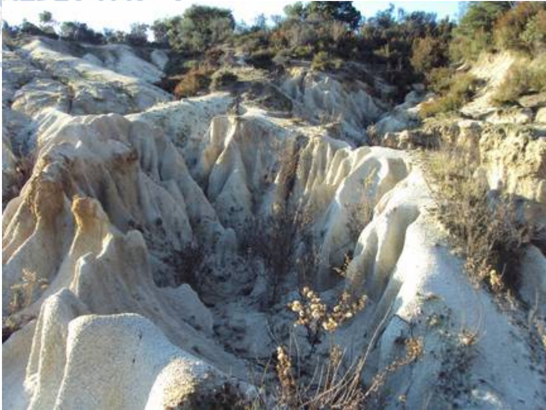
ΦΩΤΟΓΡΑΦΙΑ 32: ΦΥΣΙΚΗ ΔΙΑΒΡΩΣΗ ΥΛΙΚΟΥ ΛΟΓΩ ΕΠΙΔΡΑΣΗ ΤΟΥ ΝΕΡΟΥ ΜΕ ΧΑΡΑΚΤΗΡΙΣΤΙΚΕΣ ΑΥΛΑΚΩΣΕΙΣ.
