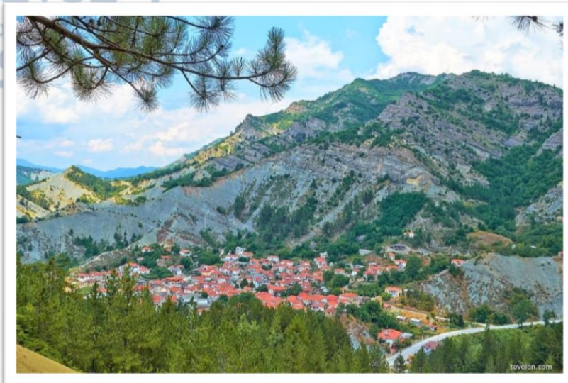
Σχήμα 1.2 Πανοραμική εικόνα του εξεταζόμενου πρανούς ανάντη του οικισμού του Επταχωρίου. ( http://www.tovoion.com/ )
