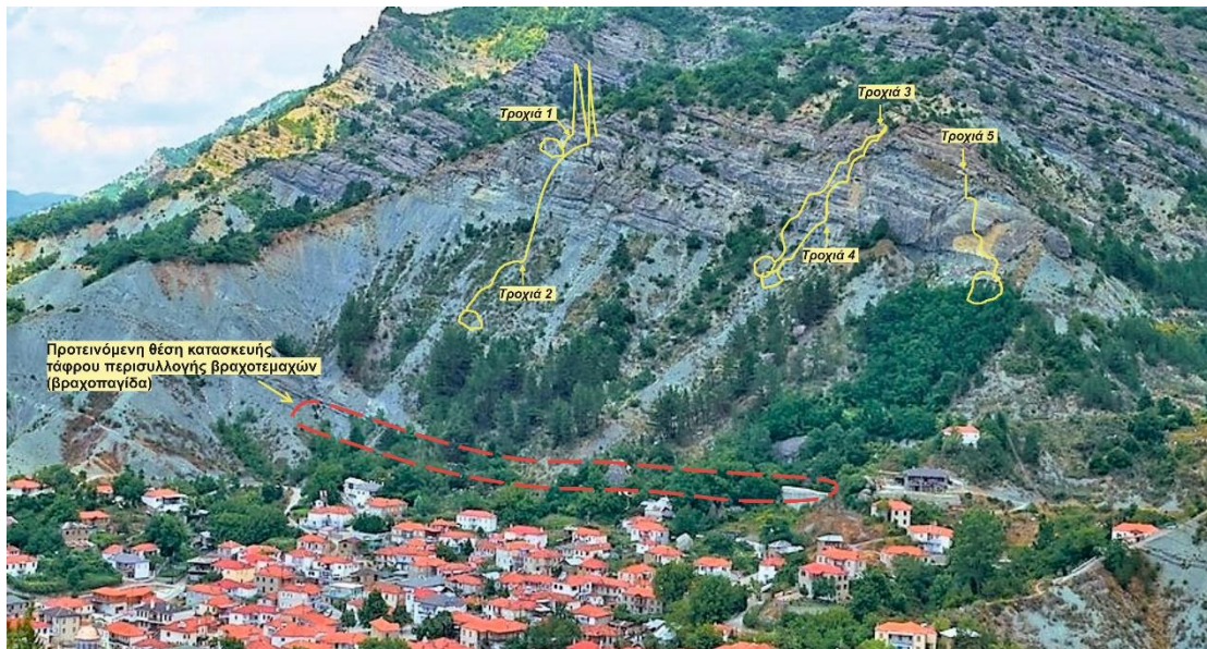
Σχήμα 7.9 Προτεινόμενη θέση κατασκευής τάφρου περισυλλογής βραχοτεμαχίων (κόκκινη διακεκομμένη γραμμή) στη βάση του πρανού
