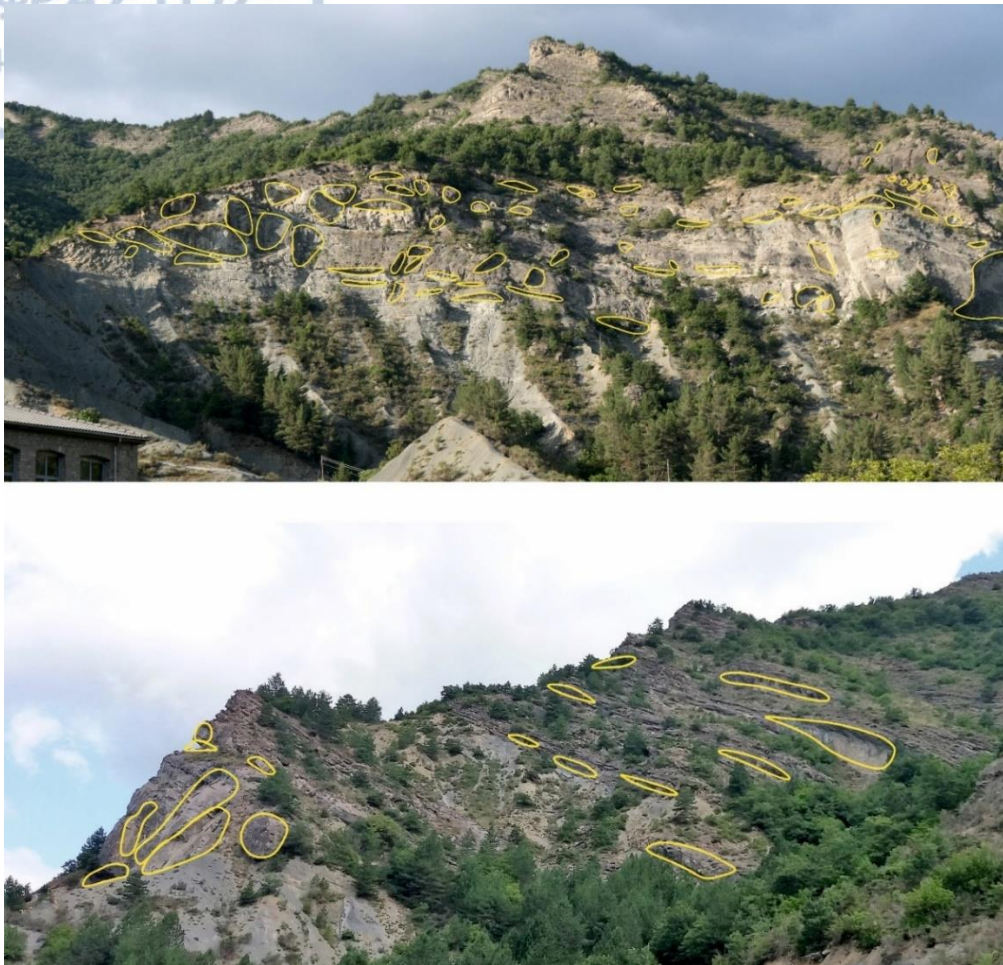
Σχήμα 4.9 Παρουσίαση επικρεμάμενων τεμαχών, τεμαχών επιδεκτικών σε κατάπτωση, δομών παλαιότερων καταπτώσεων και δομών υποσκαφής, επάνω: όψη πρανούς προς ΝΔ, κάτω: όψη πρανούς προς ανατολικά.
