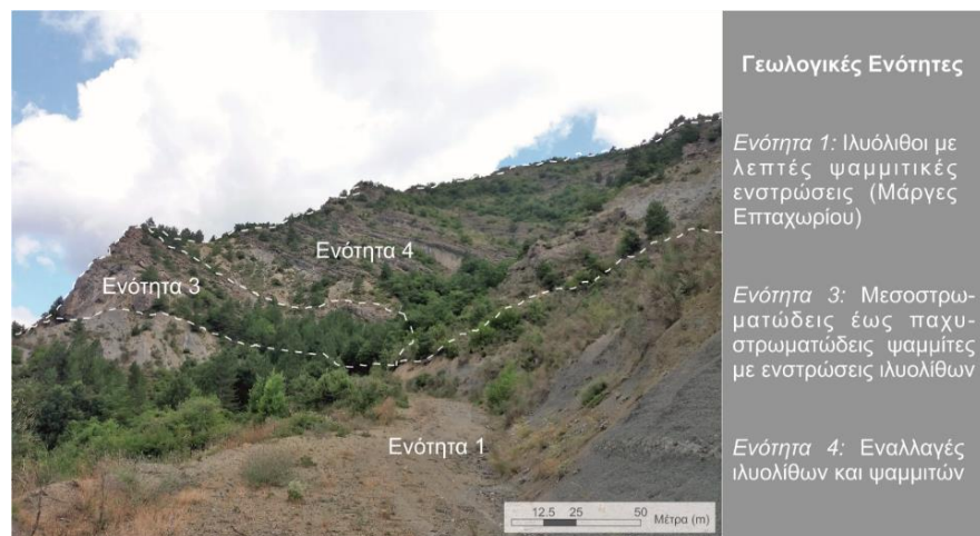
Σχήμα 2.11 Όψη του πρανούς προς ΑΒΑ όπου διακρίνονται οι γεωλογικές ενότητες της περιοχής και η στρώση των ιλυολιθικών και ψαμμιτικών οριζόντων (φωτογραφία από προσωπικό αρχείο, ημερομηνία λήψης 12/07/2018)
