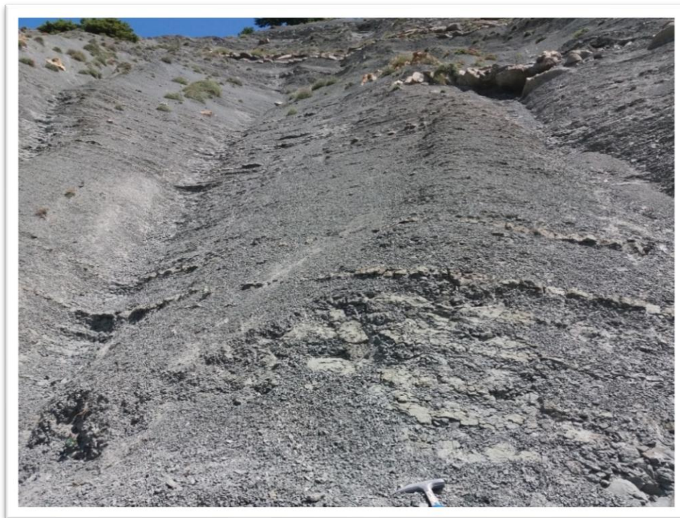
Σχήμα 2.8 Μάργες Επταχωρίου με το χαρακτηριστικό τεφροκύανό τους χρώμα στη βάση του πρανού με λεπτές ψαμμιτικές ενστρώσεις, όπου στα ανώτερα τμήματα διακρίνονται ψαμμιτικοί πάγκοι με αυξανόμενο πάχος. Διακρίνεται η αποσάθρωση των ιλυολίθων (σχάση) και οι χαρακτηριστικές δομές λόγω επιφανειακής απορροής υδάτων (φωτογραφία από προσωπικό αρχείο, ημερομηνία λήψης 09/07/2018)
