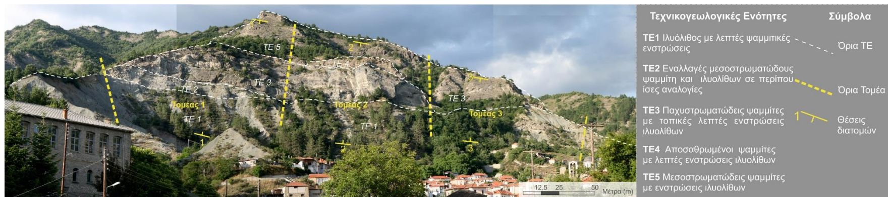
Σχήμα 3.3 Διάκριση πέντε (5) Τεχνικογεωλογικών Ενότητων (TE) και θέσεις διατομών κατά μήκος του εξεταζόμενου πρανού
