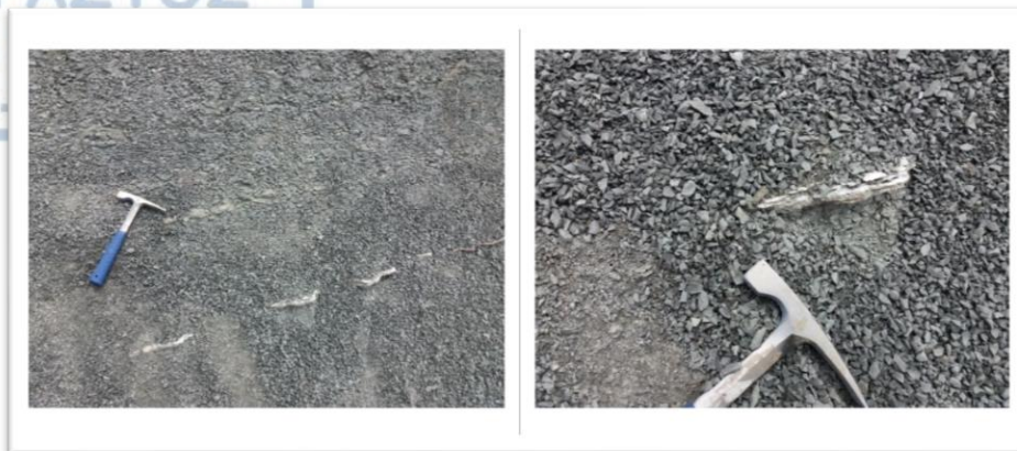
Σχήμα 3.6 Ιλυόλιθος με το χαρακτηριστικό τεφρακύανο χρώμα στη βάση του πρανούς έντονα αποσαθρωμένος με αποδιοργανωμένη δομή
