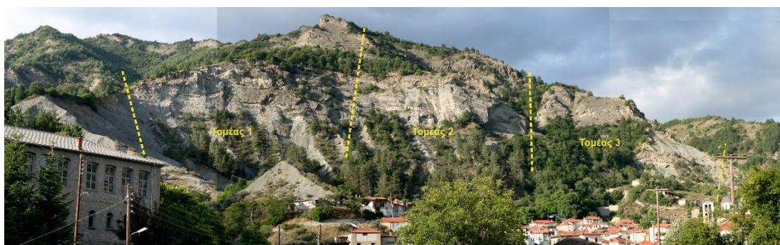
Σχήμα 3.1 Τρεις τομείς κατά μήκος του πρανούς (φωτογραφία από προσωπικό αρχείο, ημερομηνία λήψης 18/07/2018)
