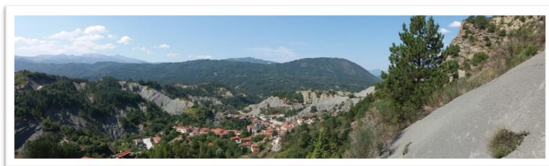
Σχήμα 1.4 Χαρακτηριστικές δομές μαργών Επταχωρίου λόγω αποσάθρωσης. Λήψη επί της του ανατολικού τμήματος του πρανού (φωτογραφία από προσωπικό αρχείο, ημερομηνία λήψης 23/08/2018)
