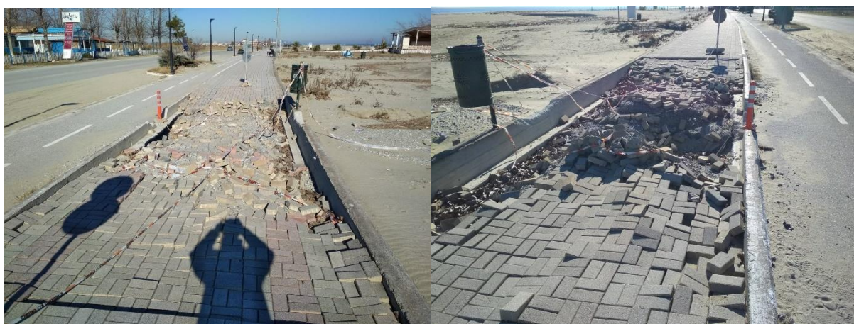
Εικόνα 4.3-4.4: Καταστροφές εξαιτίας έντονων βροχοπτώσεων και μπάζωμα των θινών (Παραλία 2017)
