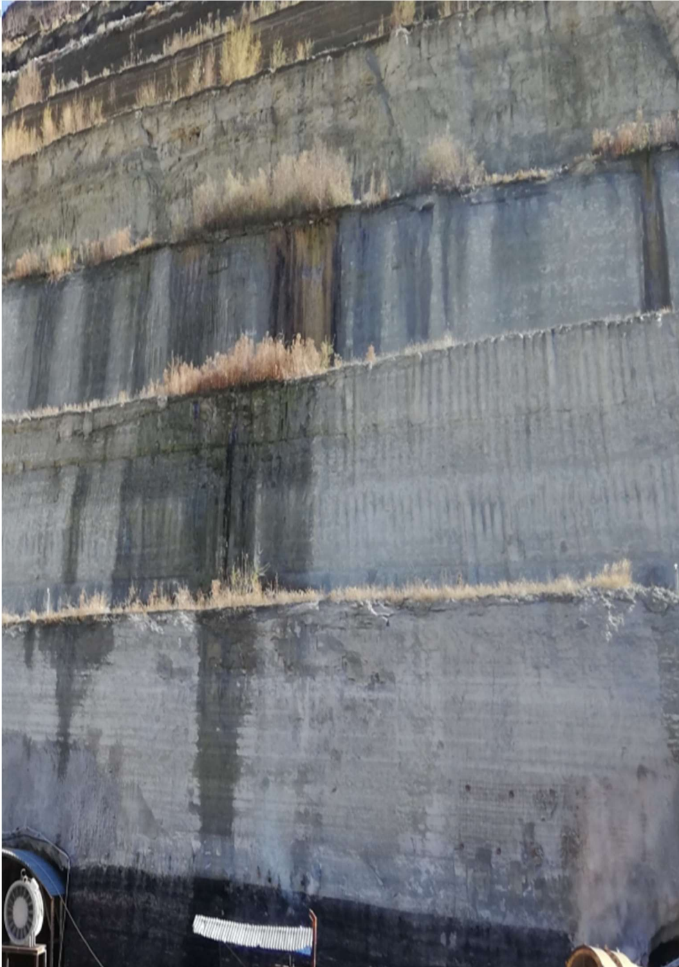
Φωτογραφία 6.8. Απεικονίζεται το μεγάλο ύψους του πρανούς στο σύνολο του και η κάθε αναβαθμίδα με μέσο ύψος περί τα 10m έκαστη.
