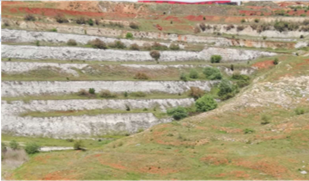
Φωτογραφία 6.6. Προσανατολισμός πρανούς λιγότερο ευνοϊκός στην ολίσθηση
