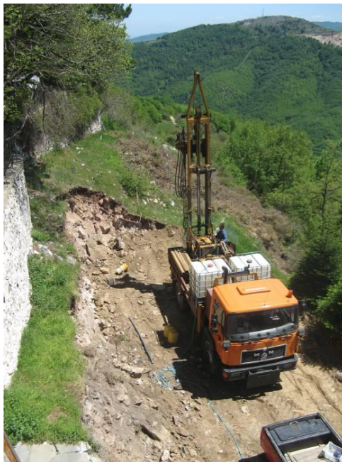
Εικόνα 8: Δειγματοληπτική γεώτρηση στο πλαίσιο γεωτεχνικής έρευνας. (Πηγή: www.geognosi.gr )
