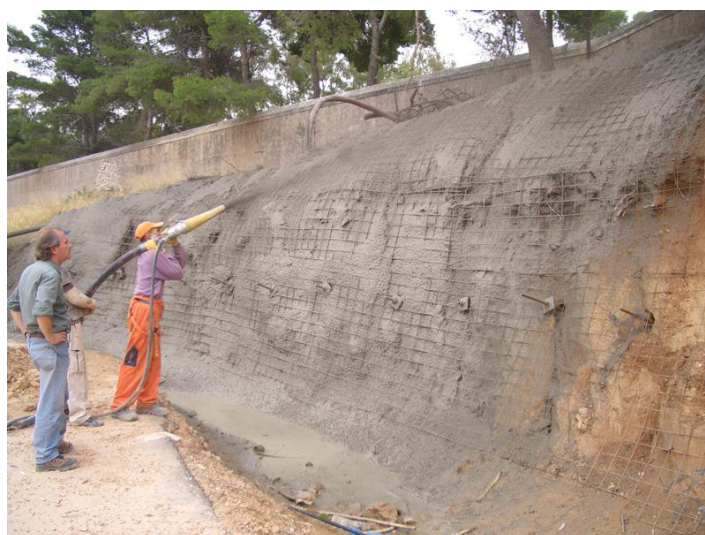
Εικόνα 19: Εκτοξευόμενο σκυρόδεμα. (Πηγή: http://www.epidomos.gr )
