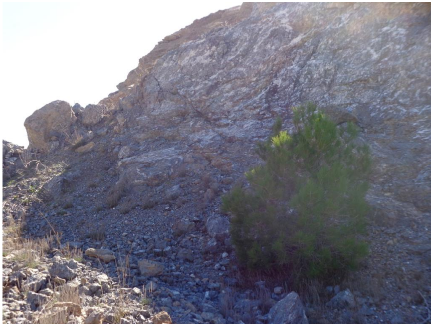
Εικόνα 1: Τεχνικογεωλογικός τύπος Α ασβεστολιθικής βραχώμαζας στη θέση μελέτης.
