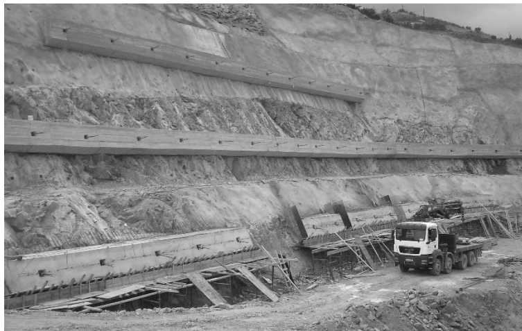
Εικόνα 17: Προεντεταμένα αγκύρια για την εξασφάλιση της ευστάθειας του πρανούς. (Πηγή: www.ekkaf.happyartists.net )
