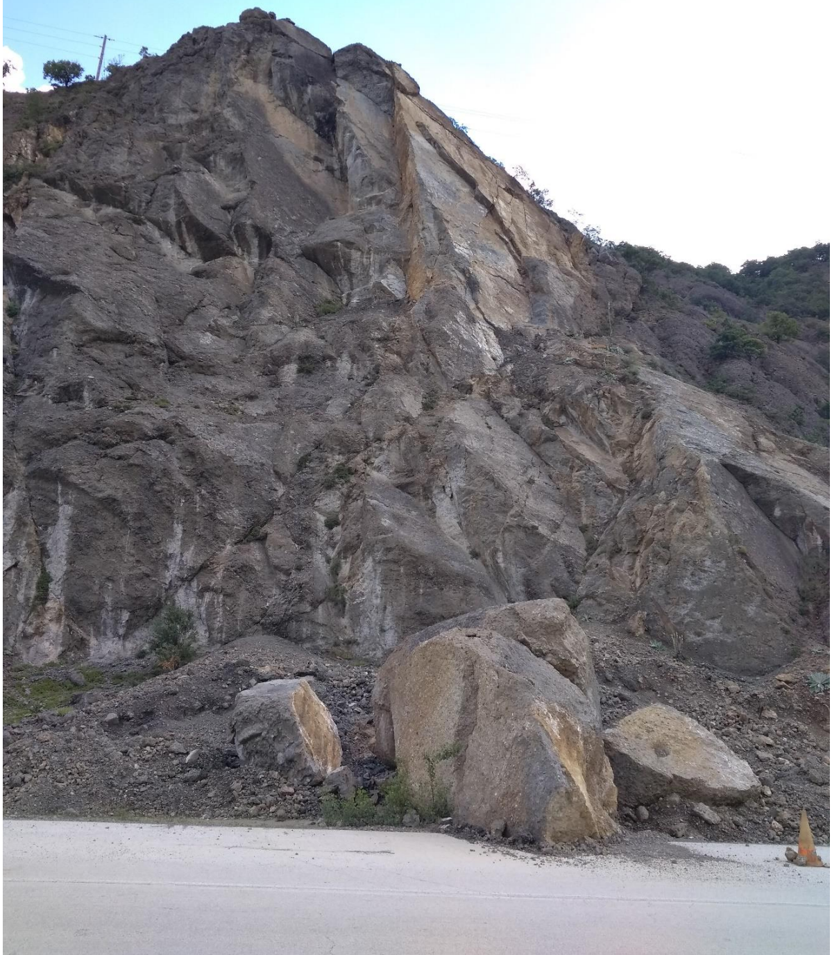
Εικόνα 1 Εξεταζόμενο πρανές μέσου ύψους 25m και μέγιστος όγκος κατάπτωσης 14.1 m 3
