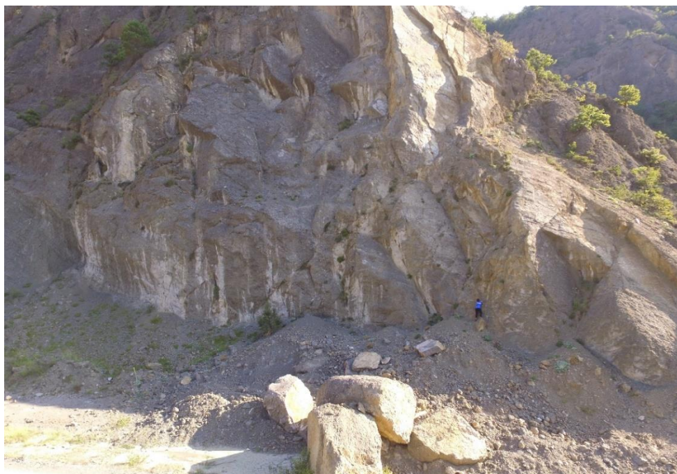
Εικόνα 35 Εξεταζόμενο πρανές. Λήψη από UAV
