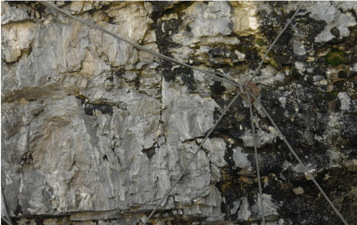
Εικόνα 8 Αντιστήριξη ασβεστολιθικής βραχώμαζας στην περιοχή του φράγματος Vajont, Ιταλία με χρήση αγκυριών. (Ενεργητικά μέτρα αντιστηρίξης)
