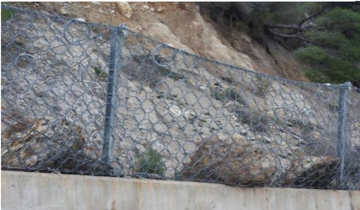
Εικόνα 9 Αντιστήριξη βραχώμαζας στο δρόμο που οδηγεί στον Άγιο Νικήτα, Λευκάδας. (Παθητικά μέτρα αντιστηρίξης, ( http://aromalefkadas.gr )
