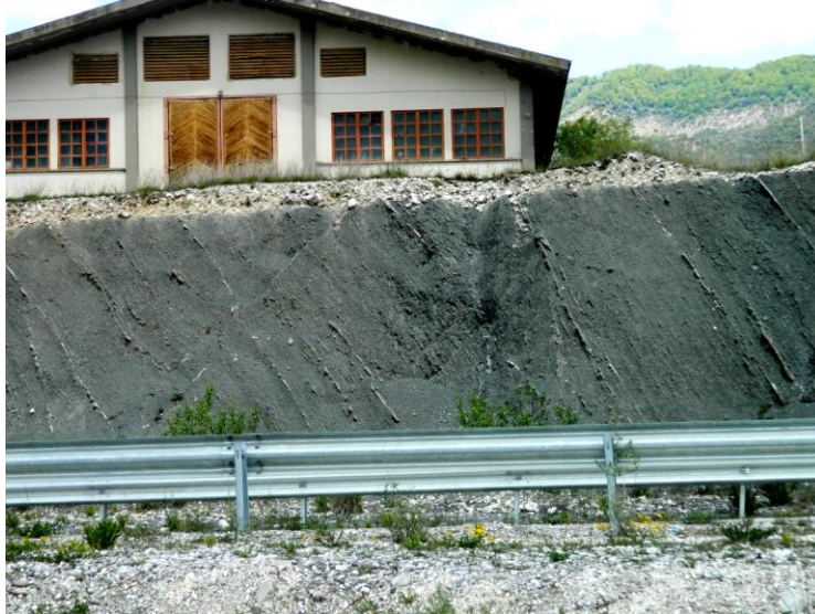
Εικόνα 3.2.2.13: Ιλύολιθος με λεπτές ενστρώσεις ψαμμίτη που εμφανίζεται με ανοικτή πτύχωση- Τύπος VI (εικόνα από πρανάς στην περιοχή Χρισοβίτσα του Δήμου Μετσόβου, 2019)
