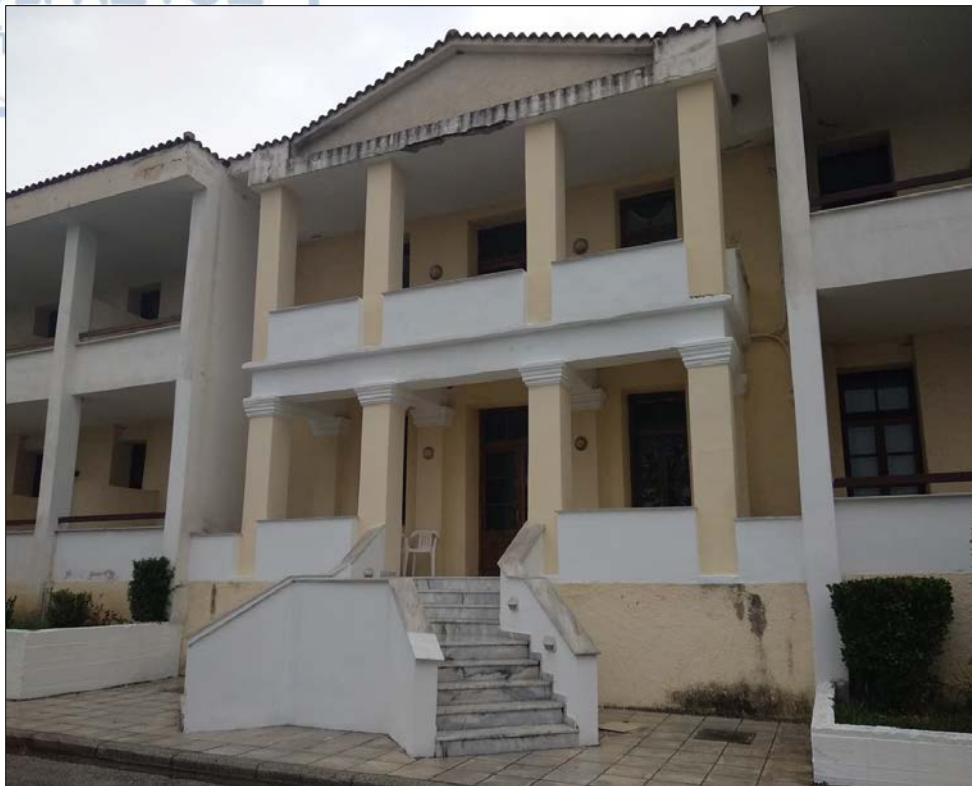
Εικόνα 42: Το ξενοδοχείο «ΠΗΓΗ» στις εγκαταστάσεις των λουτρών Σιδηροκάστρου (6/02/2019).
