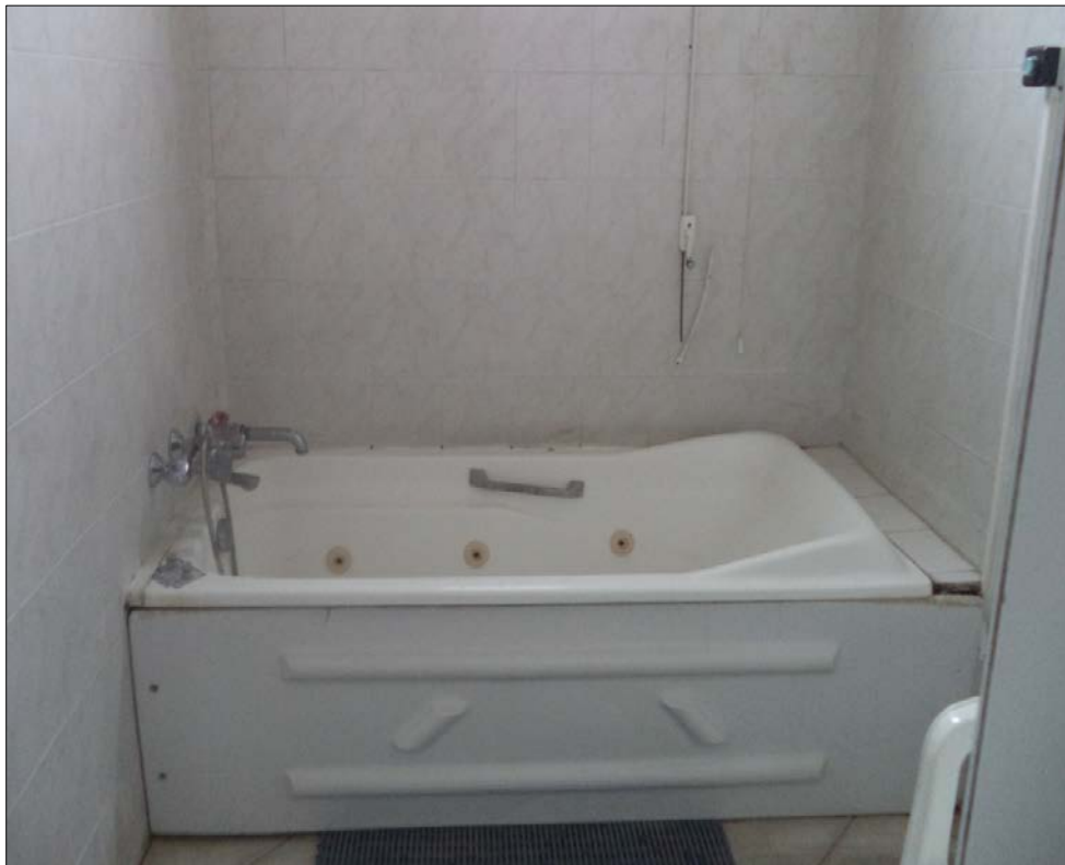
Εικόνα 44: Ατομικός λουτήρας στα λουτρά Σιδηροκάστρου με βάνες για ρύθμιση της θερμοκρασίας (6/02/2019).
