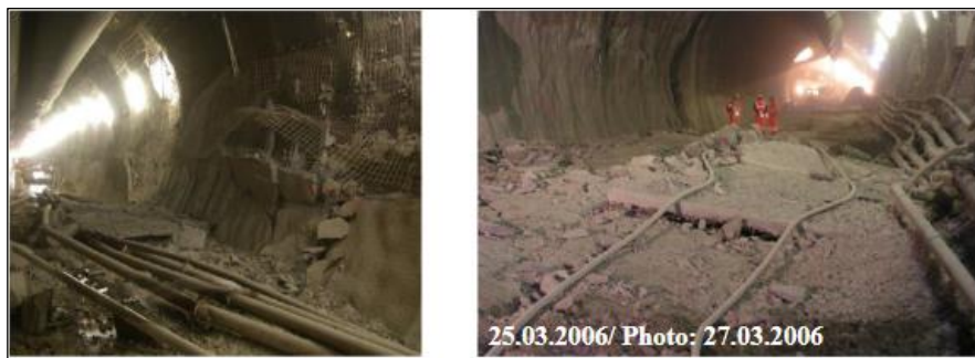
Εικόνα 11: Περίπτωση αστοχίας μέτρων υποστήριξης (αριστερά), αστοχία μετά από σεισμικό συμβάν M2.4 (δεξιά).
