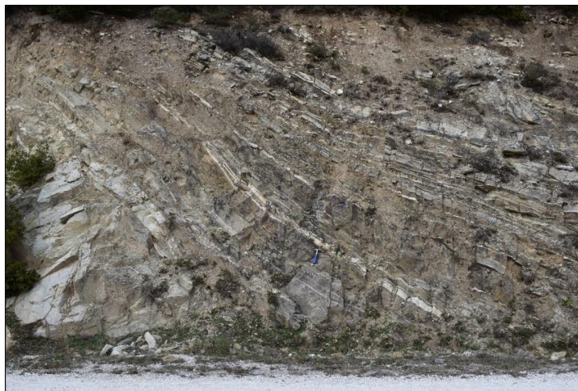
Εικόνα 18: Ελαφριά πτύχωση γνευσίου. Μετρίως αποσαθρωμένος (III) γνεύσιος, GSI 30-40.
