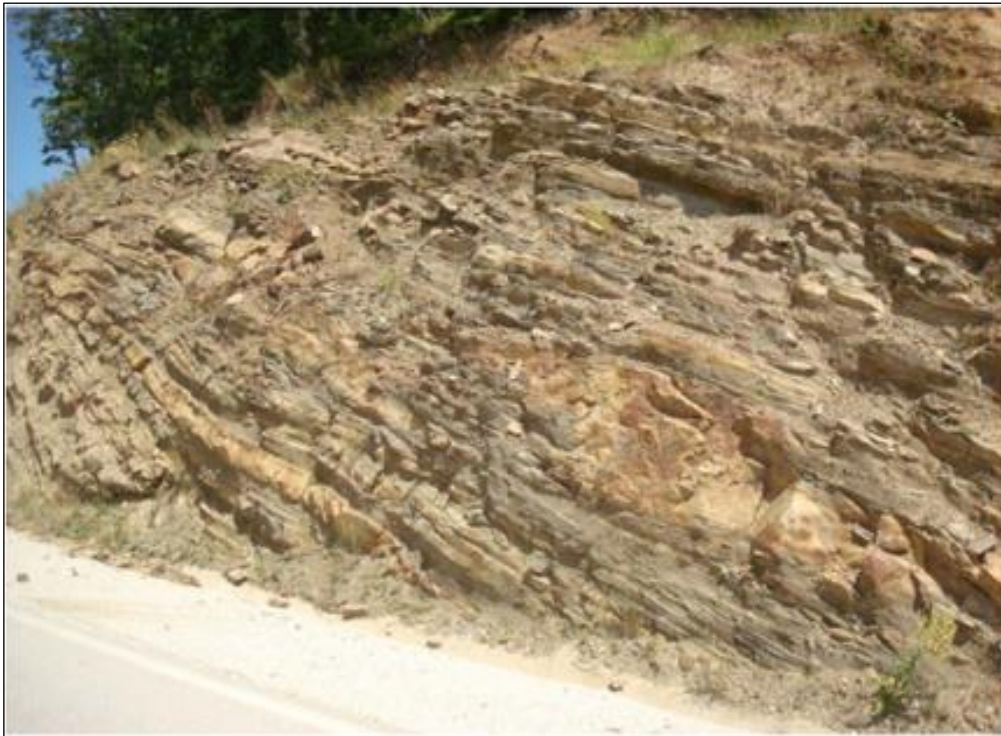
Εικόνα 2: Ελαφρώς αποσαθρωμένη σχιστώδης γενευσιακή βραχομάζα.
