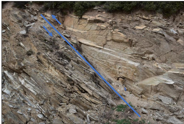
Εικόνα 17: Ανάστροφο ρήγμα. Ελαφρά αποσαθρωμένος (II) γνεύσιος GSI 50-60 (πάνω), μετρίως αποσαθρωμένος (III) γνεύσιος GSI 30-40.
