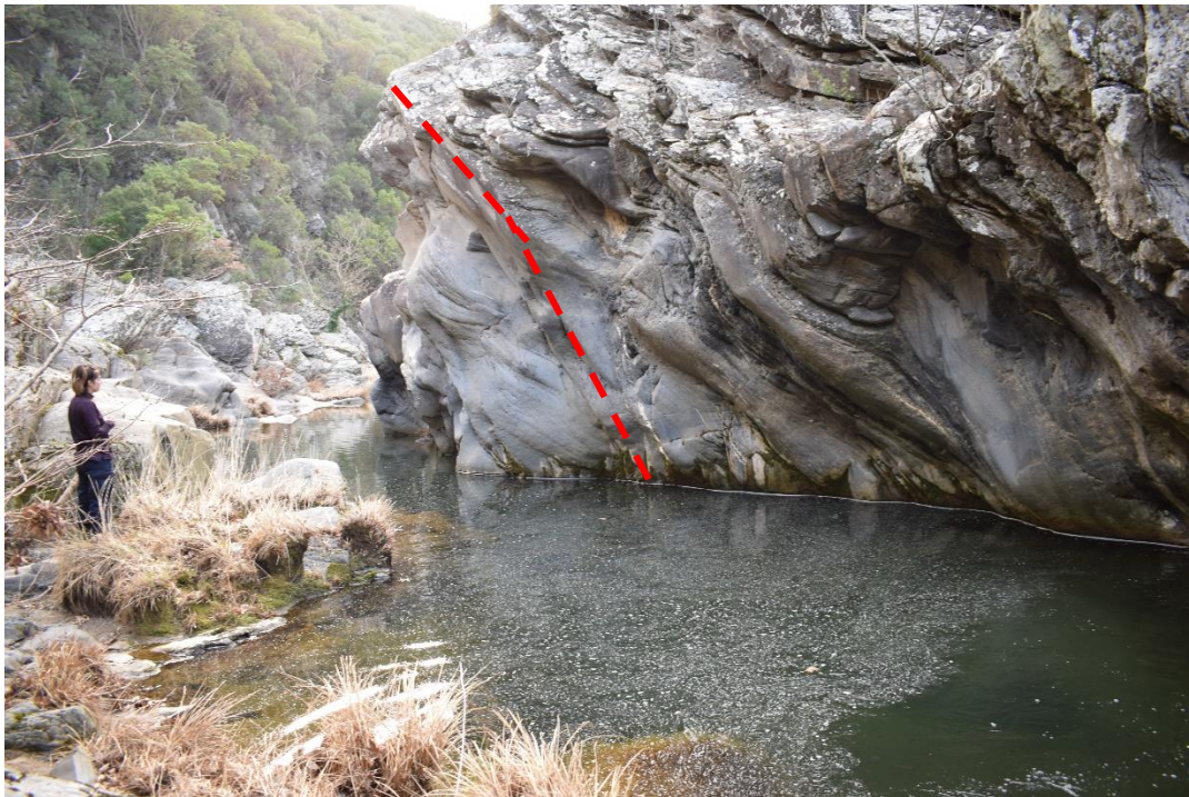
Εικόνα 39. Θέση θεμελίωσης φράγματος από ανάντη, παρουσία ανάστροφου ρήγματος.
