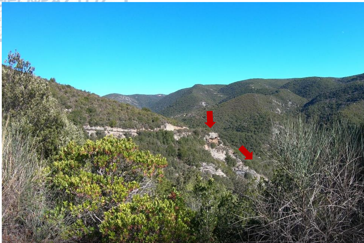
Εικόνα 118. Φωτογραφία κατολίσθησης (ακριβής θέση μέσω των κόκκινων βέλων) - προβολή από τα κατάντη του φράγματος.
