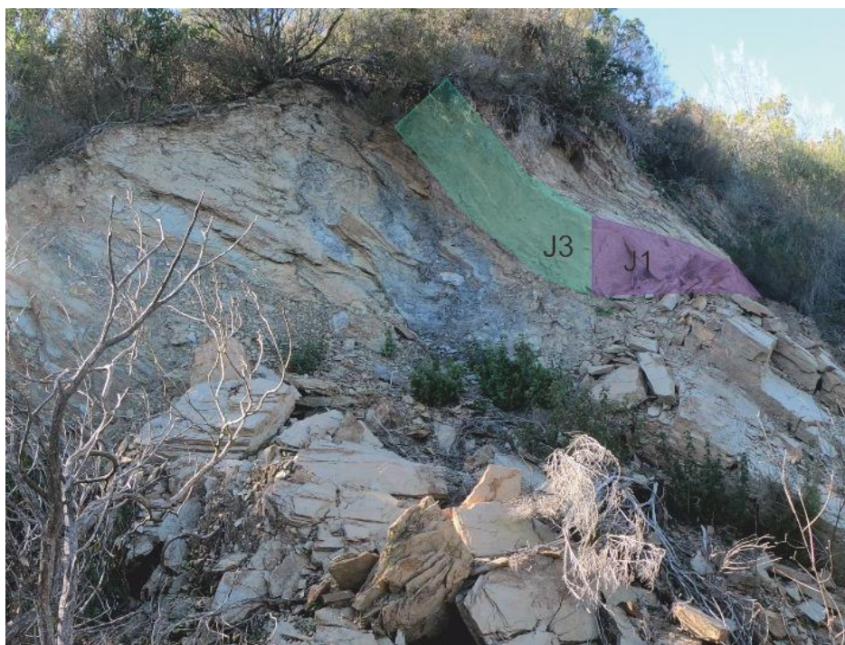
Εικόνα 120. . Βραχοκαταπτώσεις στην περιοχή μελέτης
