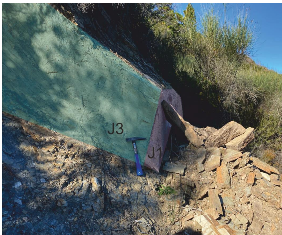
Εικόνα 121. Βραχοκαταπτώσεις στην περιοχή μελέτης.
