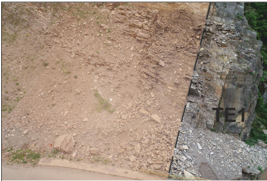
Εικόνα 40: Φωτογραφία από το UAV, που απεικονίζει την TE1 και με καφέ πλαίσιο τα υλικά βραχοκαταπτώσεων.
