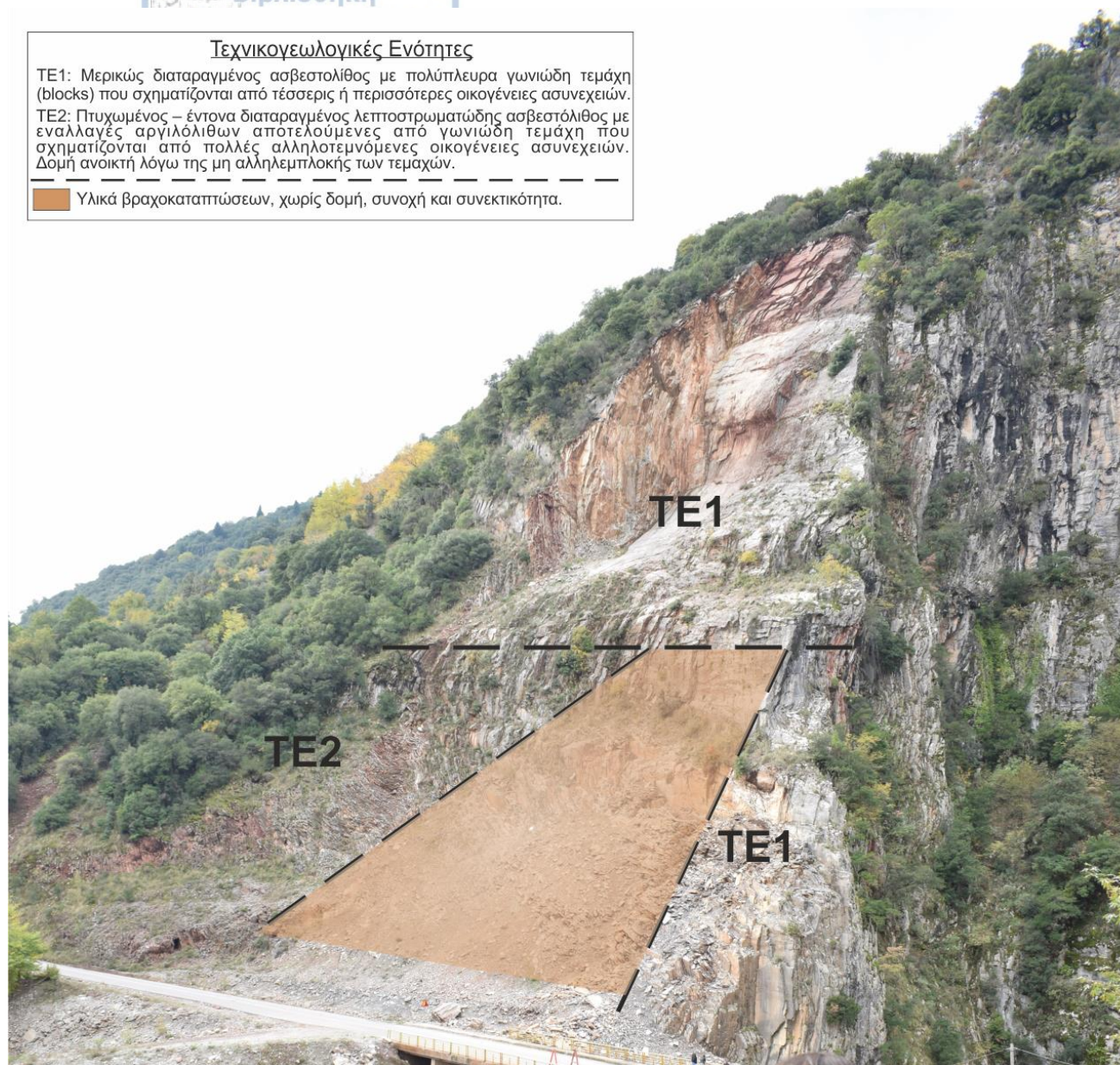
Εικόνα 39: Διαχωρισμός Τεχνικογεωλογικών Ενότητων κατά μήκος του πρανούς.
