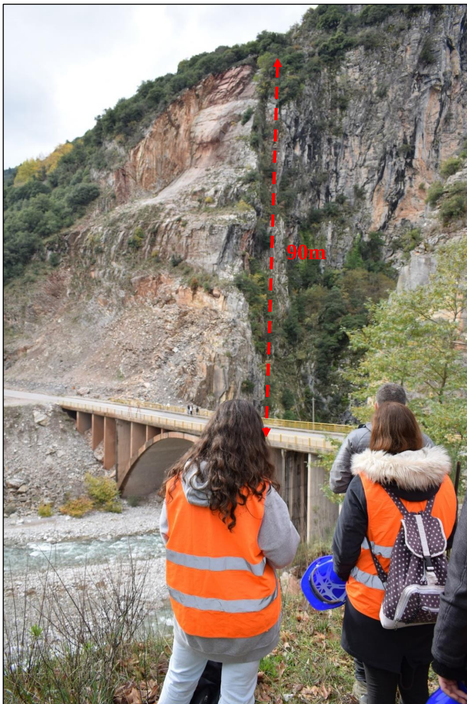
Εικόνα 25: Φωτογραφία στην οποία φαίνεται το πρανές και τα χαρακτηριστικά του (κόκκινη γραμμή - ύψος).
