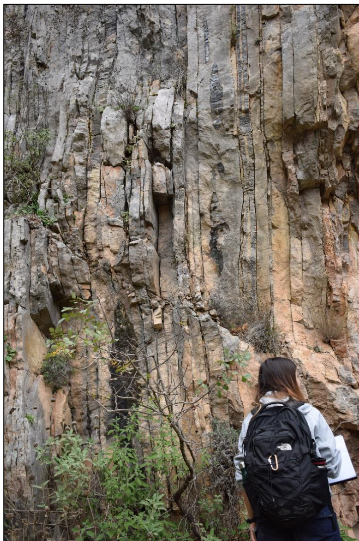
Εικόνα 29: Φωτογραφίες επιφανειακών εμφανίσεων λεπτοπλακώδων ασβεστόλιθων, στο υπό μελέτη πρανές.
