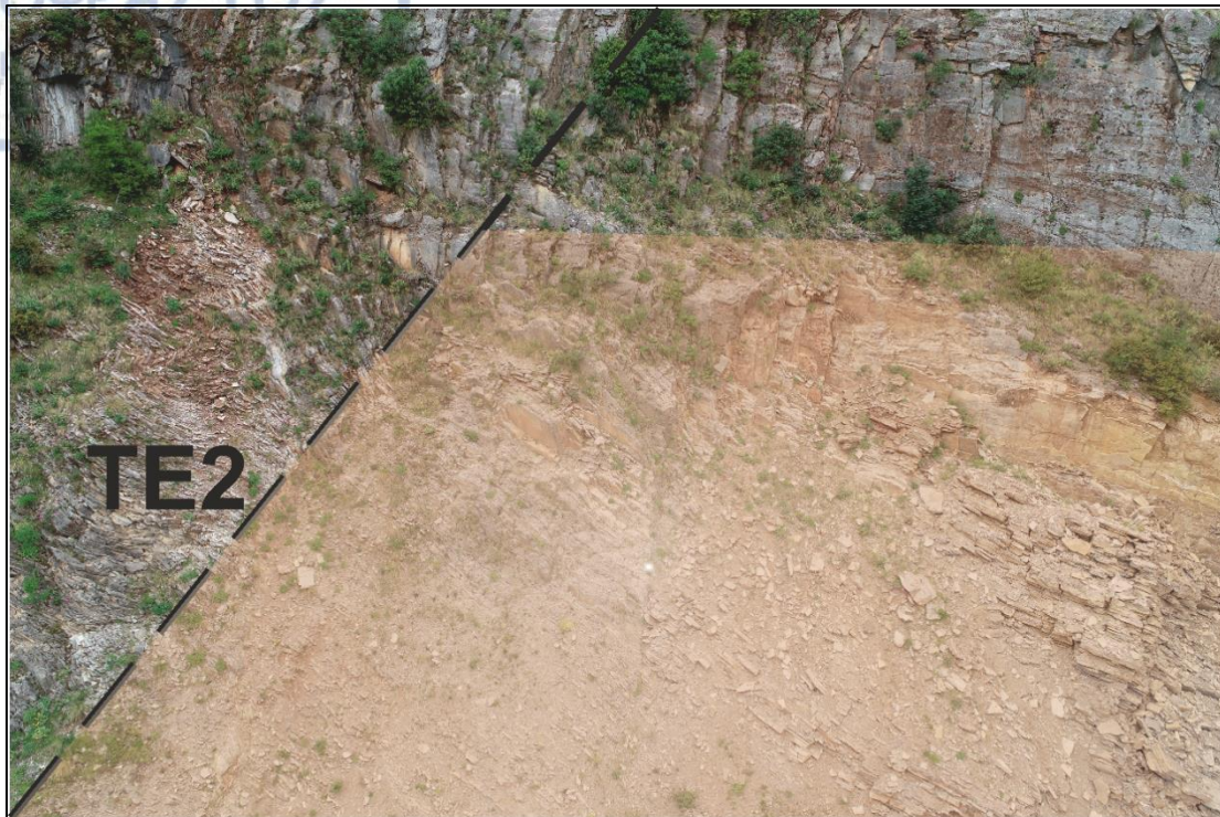
Εικόνα 42: Φωτογραφία από το UAV, που απεικονίζει την TE2 και με καφέ πλαίσιο τα υλικά βραχοκαταπτώσεων.
