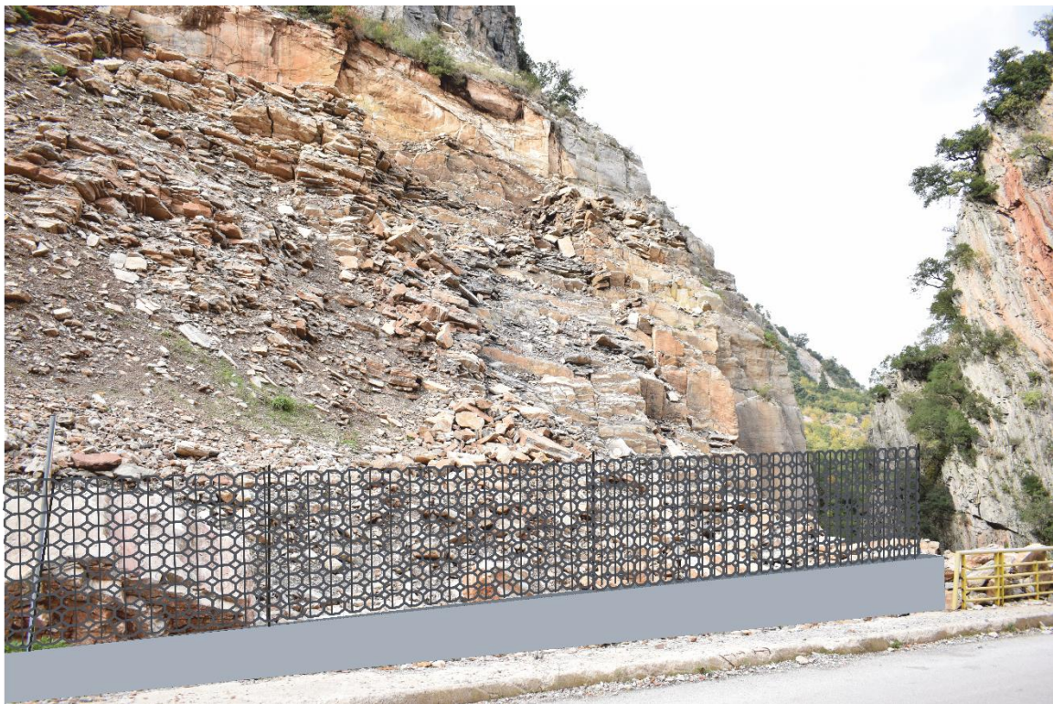
Εικόνα 81: Ενδεικτική θέση φράχτη ανάσχεσης στη βάση του πρανούς.
