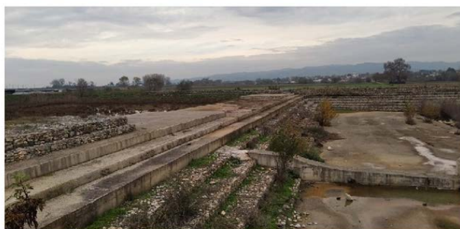
Φωτ.8: Υπερχειλιστής διαχείρισης στάθμης +73 m. Στα δεξιά της εικόνας δεν υπάρχει ίχνος νερού και στα αριστερά διακρίνεται ελαφρώς το έλος.
