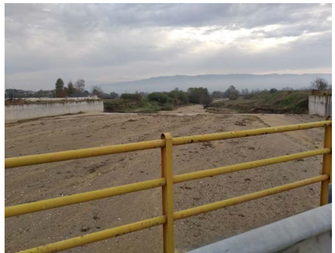
Εικ 1.8 Φράγμα ανάσχεσης από την κάτω πλευρά.
