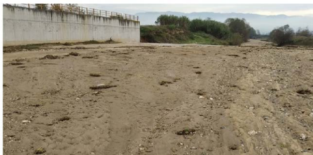
Φωτ.4: Θέση KOR-4. Διακρίνεται το υλικό του άνω ρου αλλά το φράγμα ανάσχεσης στο βάθος δε διακρίνεται διότι είναι καλυμμένο με υλικά.
