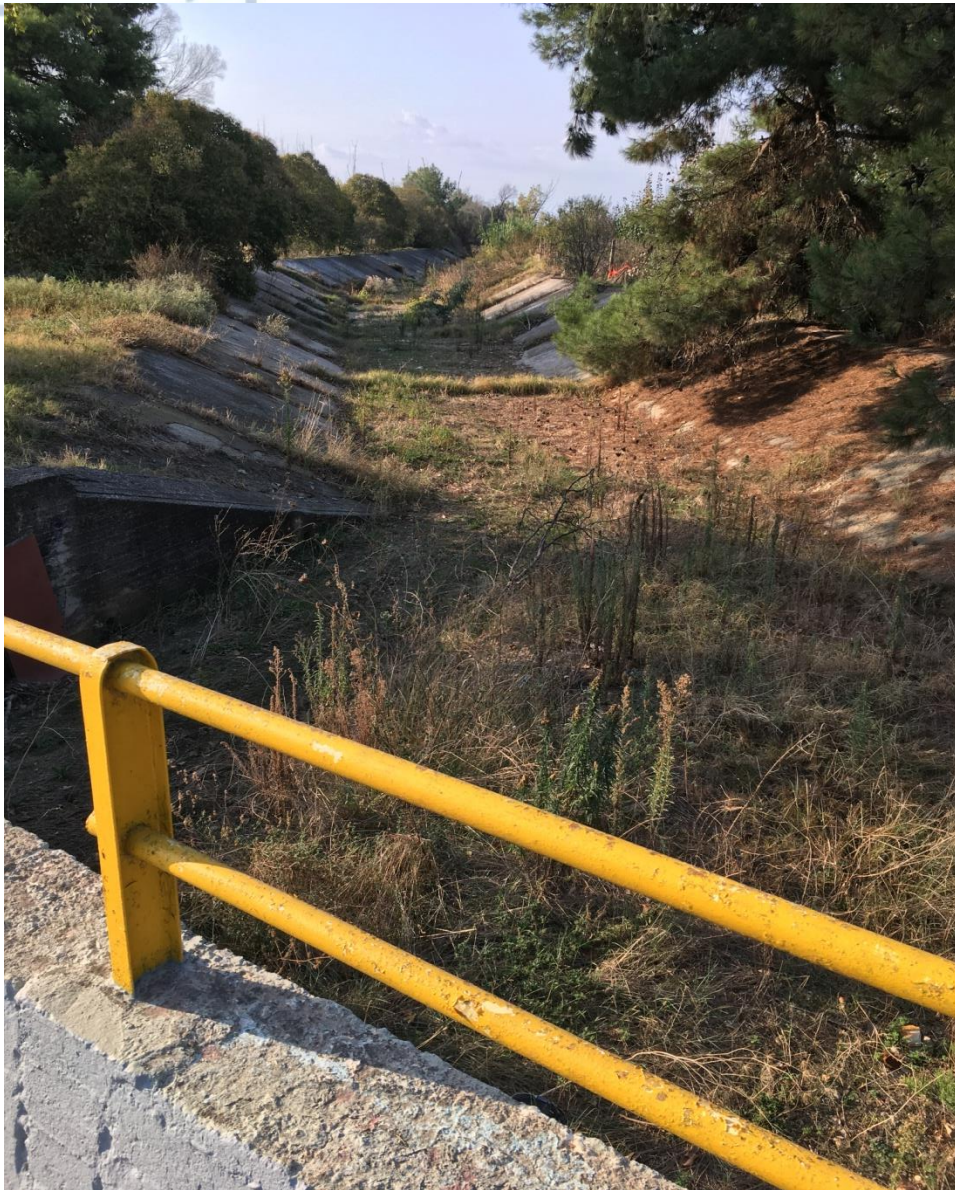
Εικόνα 6.3 Το ρέμα από την πλευρά του δρόμου κοιτώντας προς την θάλασσα
