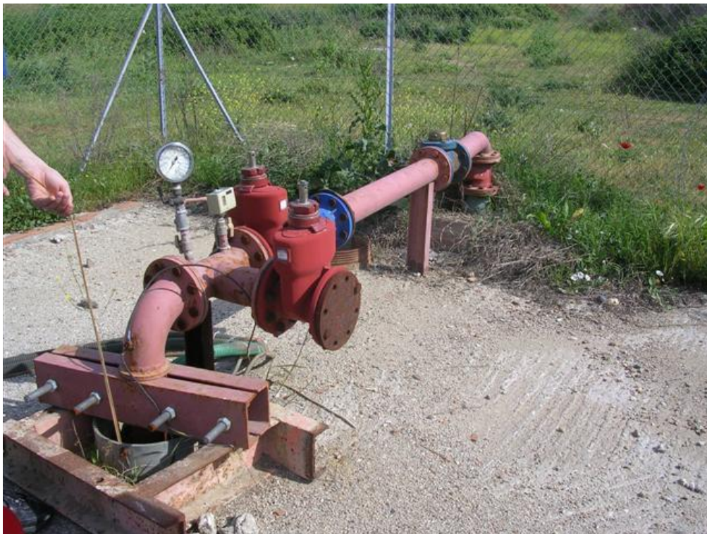
Εικόνα 3.3.1.Γεώτρηση κατά τη διάρκεια μέτρησης
