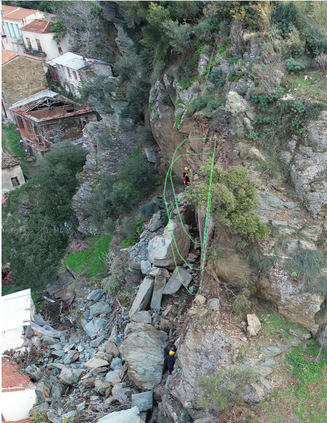
Εικόνα 29: Γεωμετρία αρνητικού όγκου του κατολισθαίνοντος τεμάχους (με πράσινες γραμμές), πλάγια όψη
