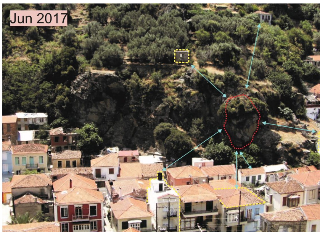
Εικόνα 43: Αεροφωτογραφία του πρανούς πριν την αστοχία από τα Β, Ιούνιος 2017. Από (SKOURTSOS, 2019)
