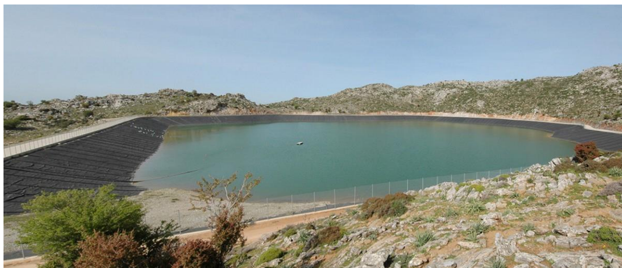
Σχήμα 2: Καλυμμένα πρανή με γεωμεμβράνη η οποία θα παραμείνει ακάλυπτη ( πηγή : φώτο αρχείο από Aropsilive.)
