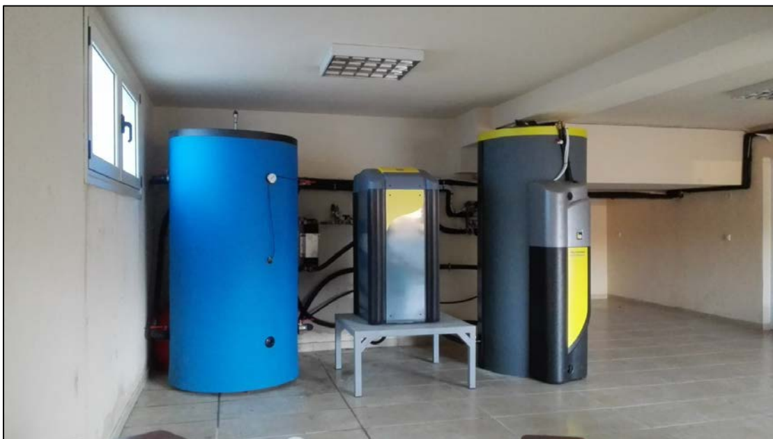
Εικόνα 3.3 Αντλία θερμότητας και σύστημα γεωεναλλάκτη
