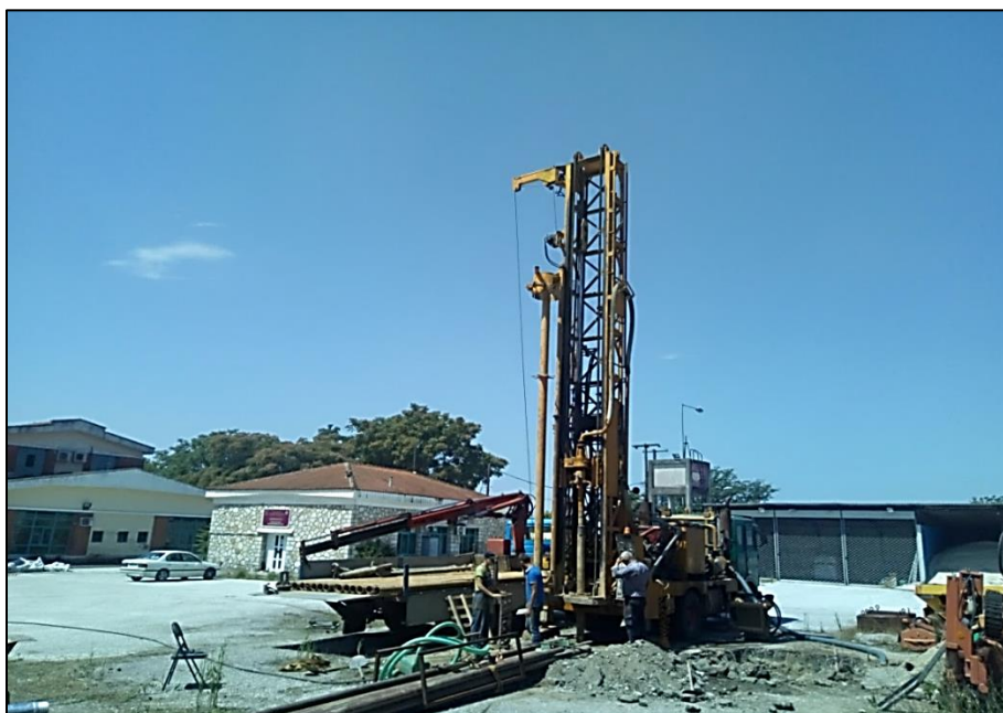
Εικόνα 3.14 Κατασκευή γεωτρήσεων στο κτίριο των διοικητικών υπηρεσιών της Περιφερειακής Ενότητας Σερρών
