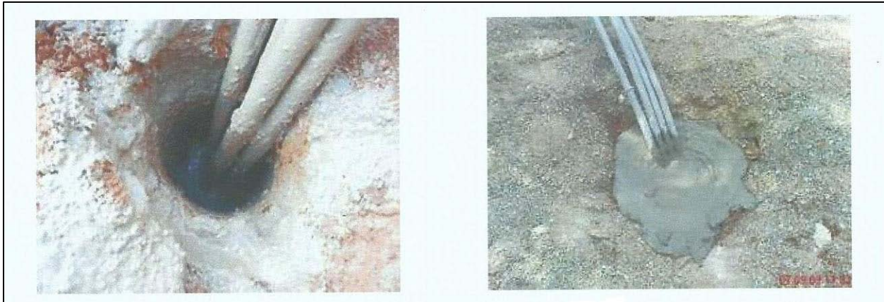
Εικόνα 3.4 Βύθιση σωληνώσεων διαμέτρων Φ32 και Φ25
